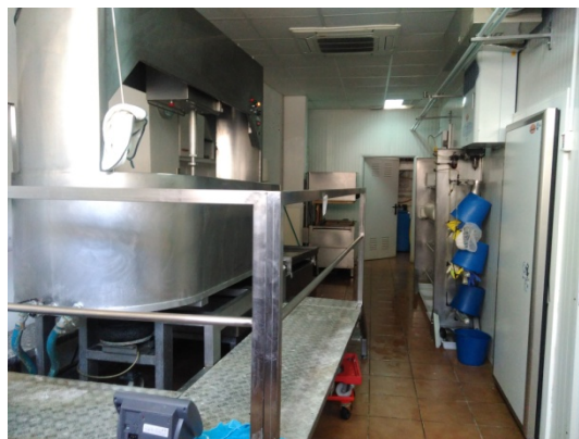
Figura 2. Instalaciones de Quesos la Sabina (Camporrobles, Valencia)
