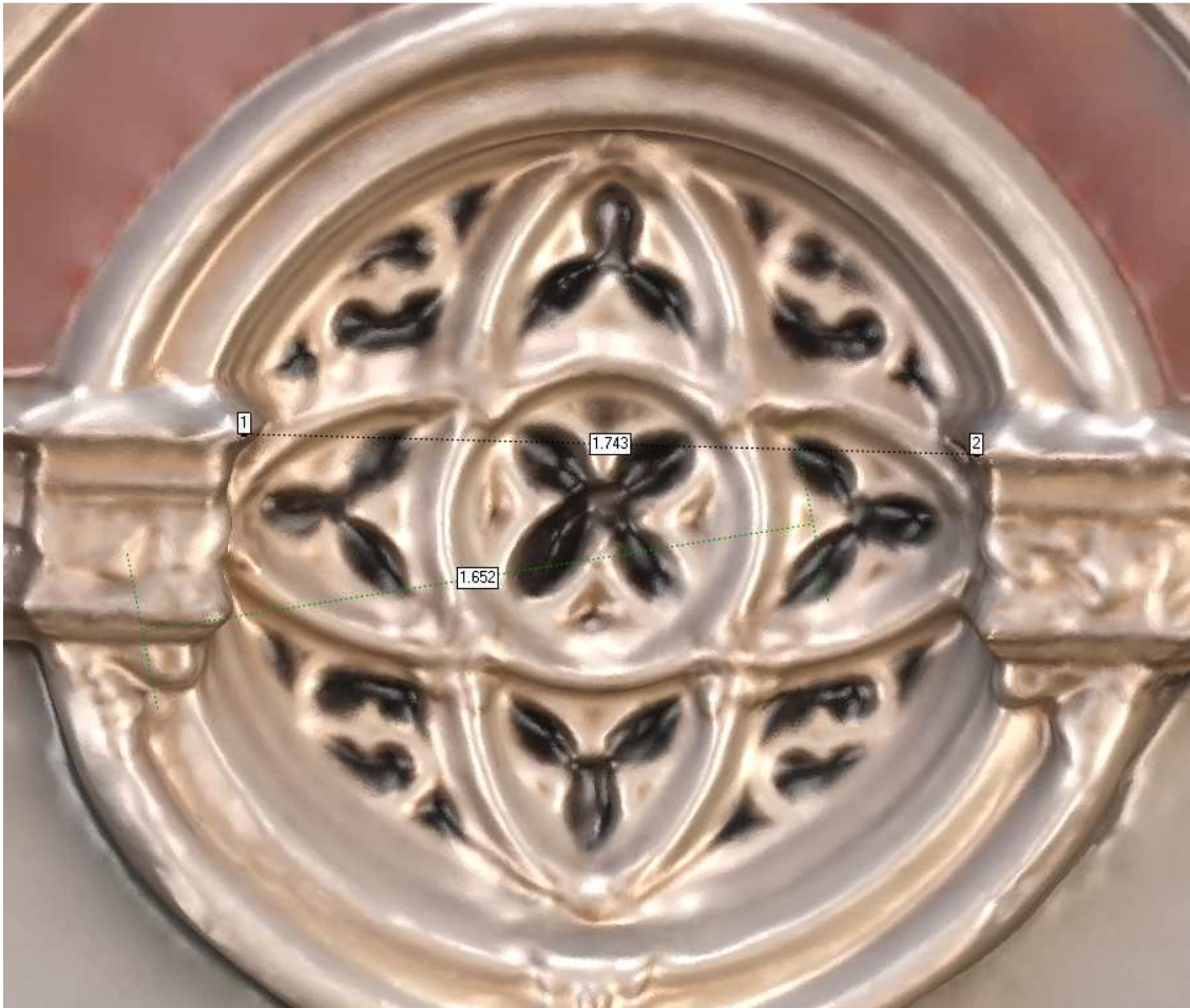
Ilustración 58.- Distancia entre cornisas sobre el modelo del rosetón. (Fuente: Fachada.wrp).
