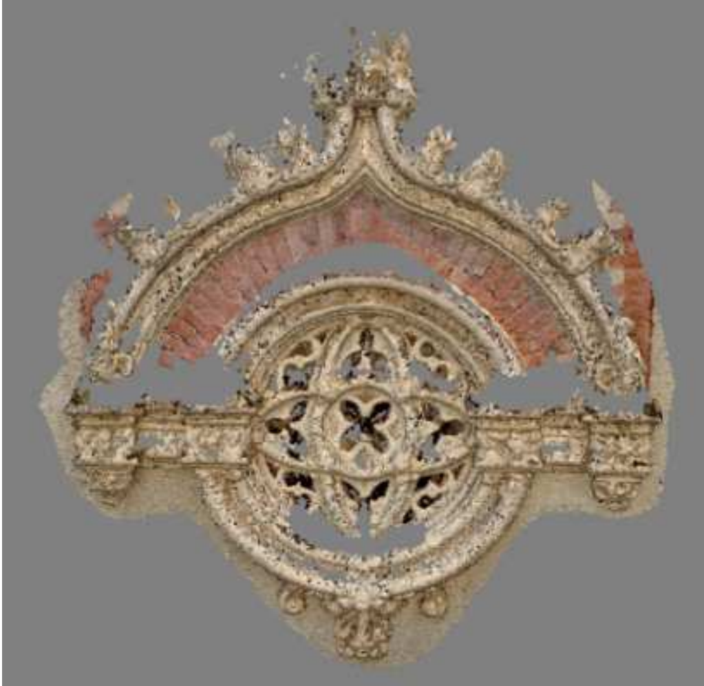
Ilustración 37. -Obtención de la nube de puntos densa del rosetón. (Fuente: Roseton.wrp).
