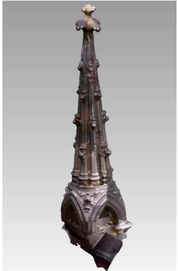
Ilustración 27. - Fusión de todos los escaneos del pináculo. (Fuente: Pinaculo.wrp).
