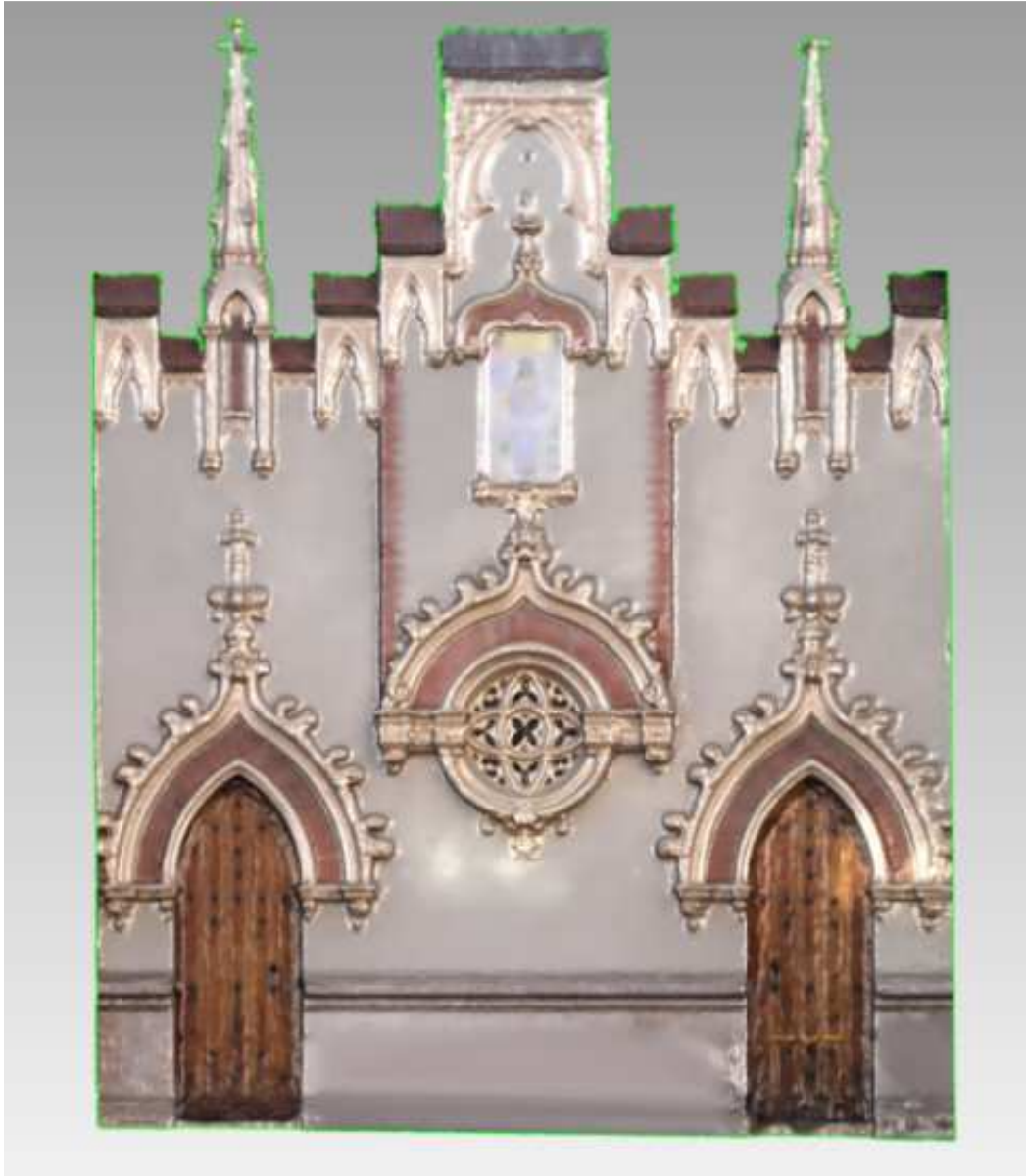
Ilustración 55. -Malla reparada de ruido e imperfecciones de la fachada. (Fuente: Fachada.wrp).
