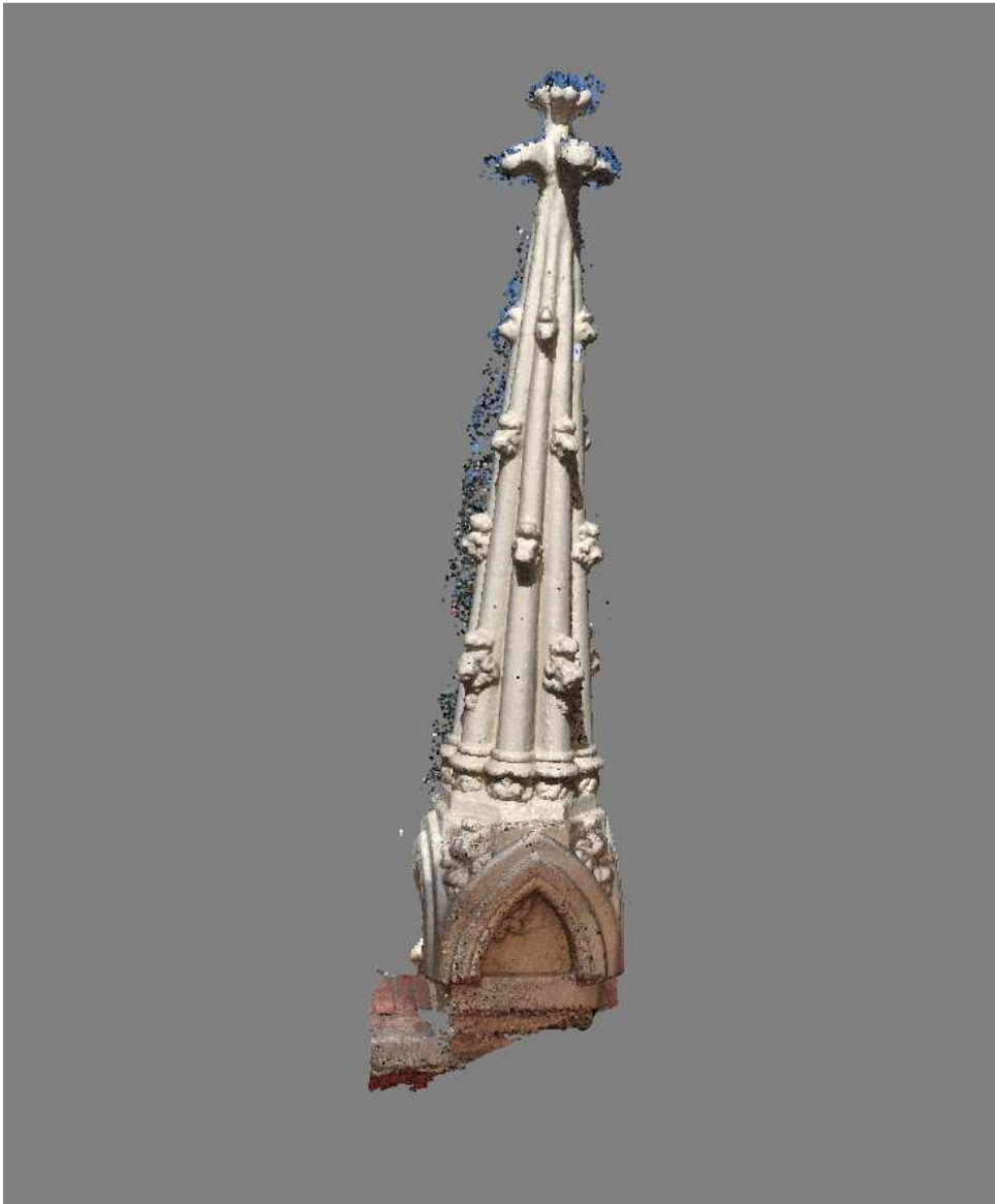
Ilustración 19. -Obtención de la nube de puntos densa del pináculo. (Fuente: Pinaculo.wrp).
