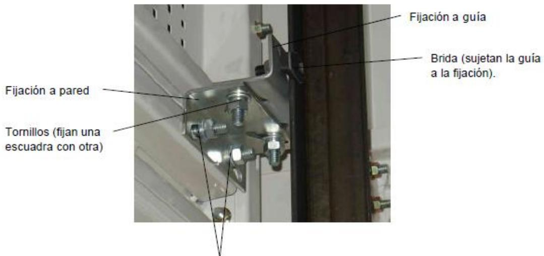
En este caso, las fijaciones que van sujetas a pared son tornillos, debido a que el hueco del ascensor es estructura metálica
