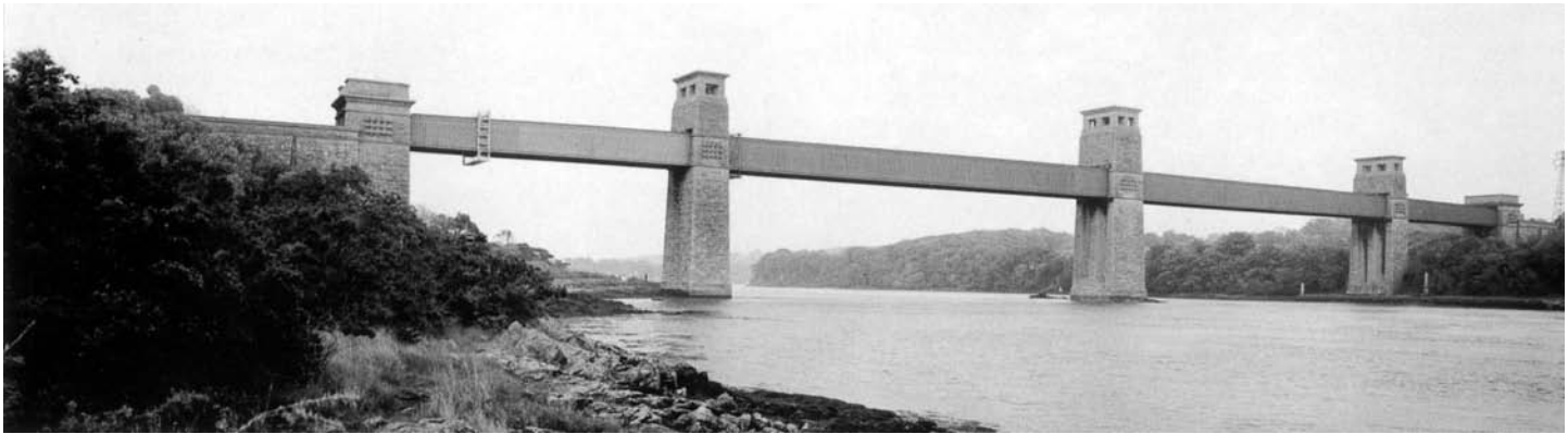
Fig. 2. Puente tubular Britannia sobre el estrecho de Menai. 1850. Robert Stephenson, Ing./Tubular Britannia Bridge over the Menai Strait, 1850. Engineer: Robert Stephenson.
