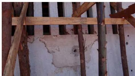
(a) deficiência e reparo na parede concretada com concreto convencional.
