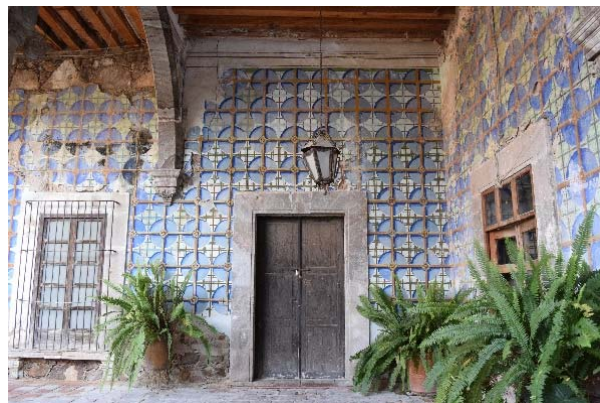
Figura 16 – Intervención de reintegración cromática y reconstrucción de las áreas decorativas perdidas (mayo 2017).
