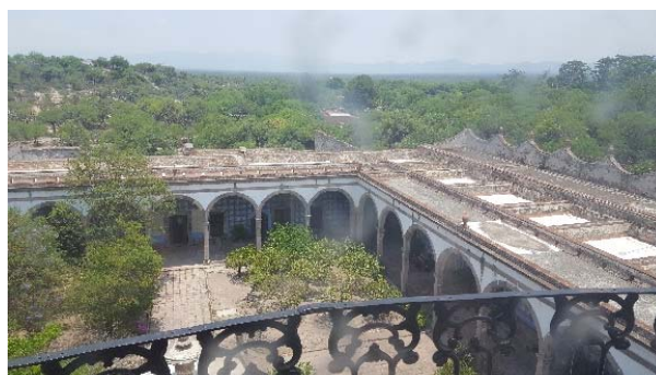
Figura 11 – Zonas impermeabilizadas (blancas) de la cubierta.
