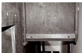
Apoyo al muro.
