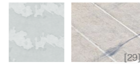
[29] Hormigón in situ con acabado cepillado y juntas de dilatación al tresbolillo
