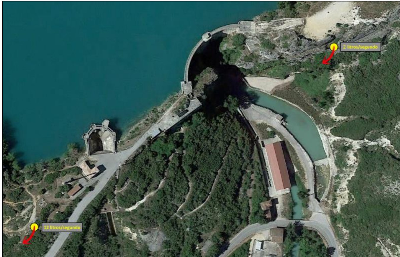
Figura 2. Localización de las filtraciones. Fuente: Propia
