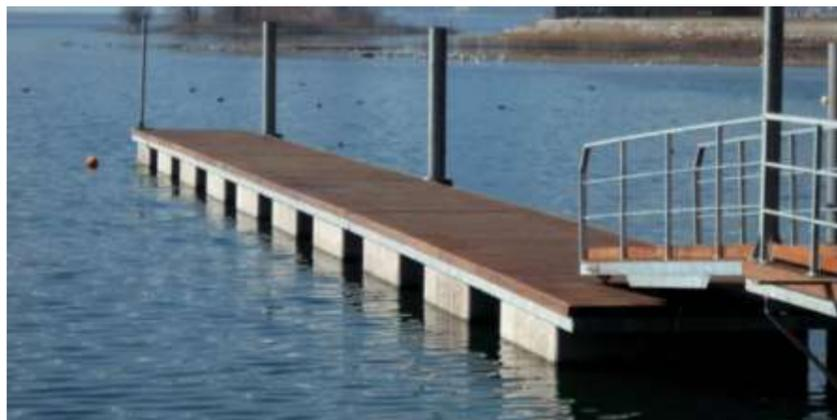
Figura 11. Pantalán de hormigón flotante
