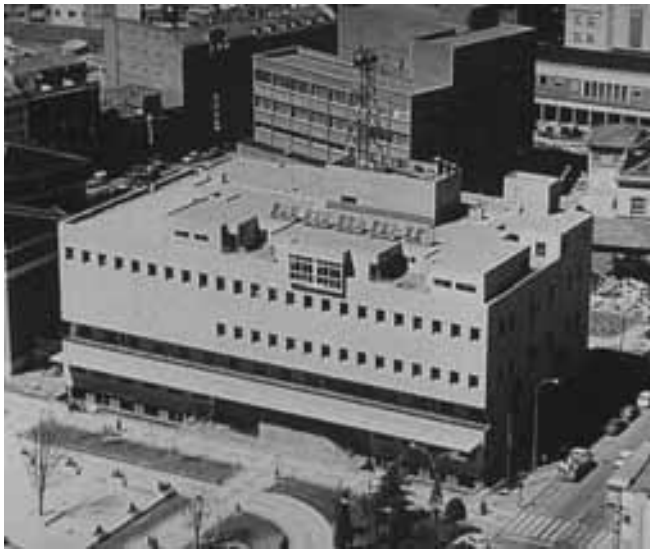
Ref 3. 129-A. de la Sota. Edificio de Correos y Telecomunicaciones. León. 1981
