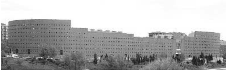
Ref 4. 160 -F.J. Sáenz de Oiza. Viviendas en la M-30. Madrid. 1986
