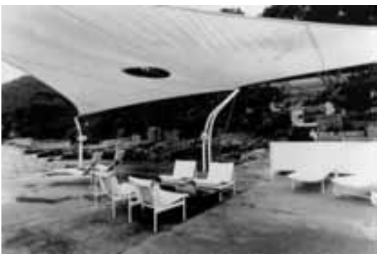
Ref 4. 105-F.J. Sáenz de Oiza. Solarium ampliación Casa Huarte. Formentor. 1968
