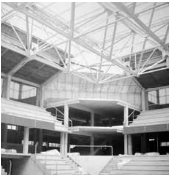
Ref 3. 102-A. de la Sota. Pabellón polideportivo de Pontevedra. 1966
