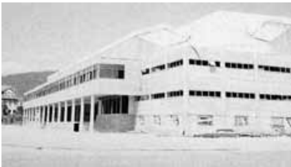
Ref 3. 103-A. de la Sota. Pabellón polideportivo de Pontevedra. 1966
