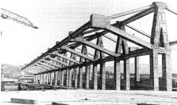
Ref 3. 100-A. de la Sota. Pabellón polideportivo de Pontevedra. 1966
