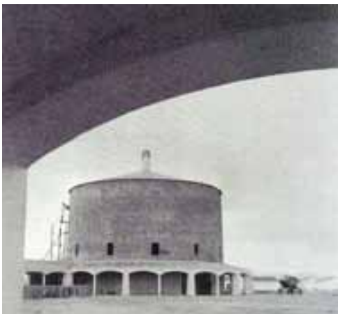
Ref 3. 19-A. de la Sota. Iglesia de Entreríos. 1953
