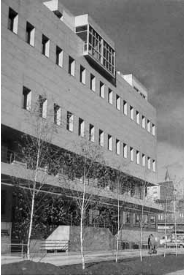
Ref 3. 132-A. de la Sota. Edificio de Correos y Telecomunicaciones. León. 1981
