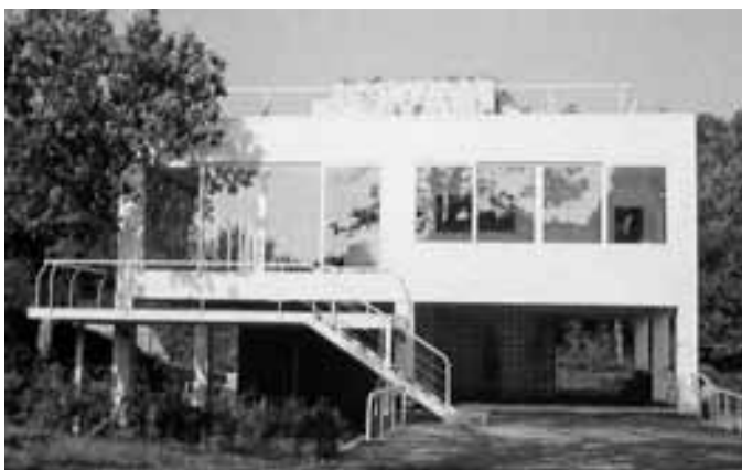
Ref 3. 142-A. de la Sota. Vivienda Domínguez. Pontevedra. 1976
