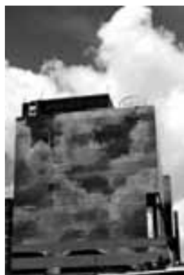
Ref 4. 184-4.185 . F.J. Sáenz de Oiza. Edificio de oficinas en Av. Pio XII. Madrid 1993
