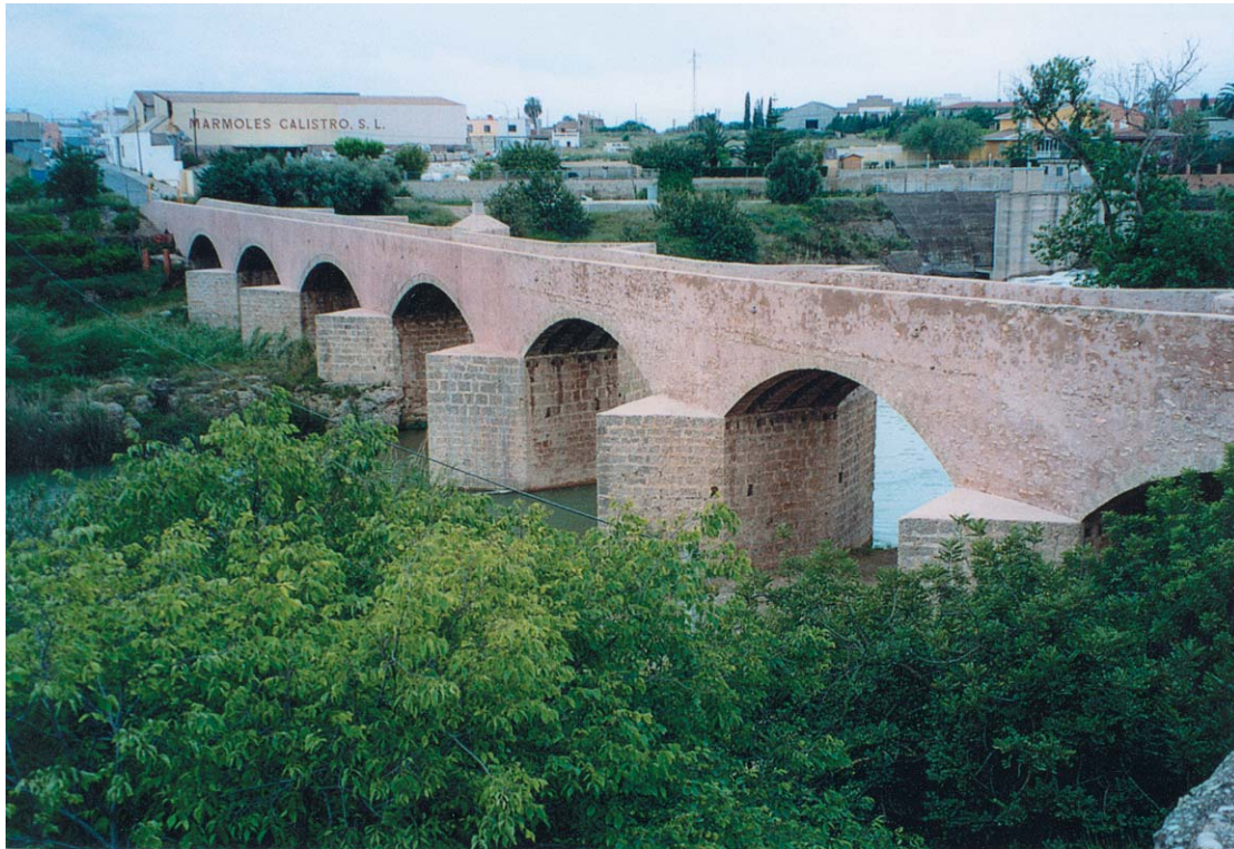
El puente de Santa Quiteria después de la restauración
