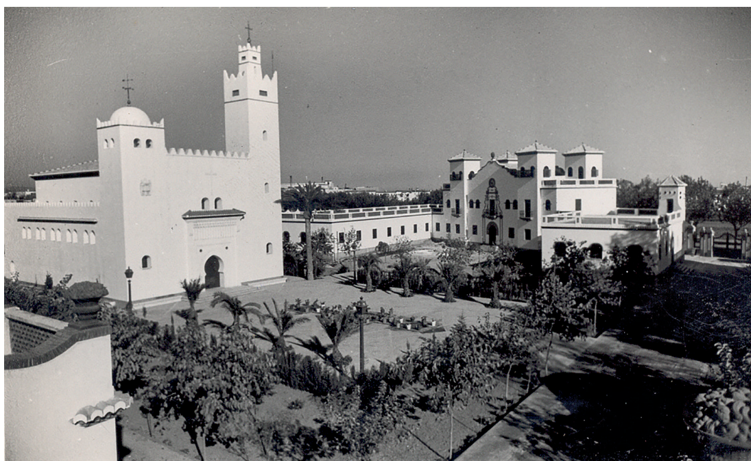
Figura 1. Vista de la capilla, antes de la demolición del conjunto. Pese a la diferencia de estilos, el edificio se integraba en el conjunto.
