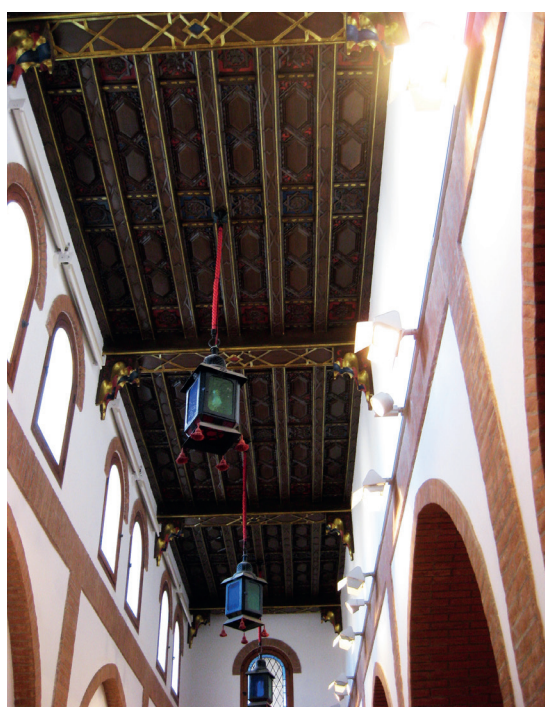
Figura 10 A. Alfarje que cubre las naves laterales (tras la restauración), en la imagen se observan las ventanas resueltas con arco de medio punto y pareadas que iluminan y ventilan estos espacios. 10 B. Alfarje que cubre el sotacoro (antes de la restauración).
