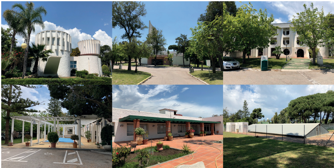
Figura 11. Ampliaciones e intervenciones. Arriba Izquierda: Antiguo despacho del director imitando al depósito. Arriba Centro: Cubrición de la iglesia y cambio de color. Arriba Derecha: Pabellón de apartamentos para empleados. Abajo Izquierda: Reforma en la plaza de acceso. Abajo Centro: Cambio de tectónica en la terraza del comedor. Abajo Derecha: Cubrición de piscina y conversión en aljibe (2018).
