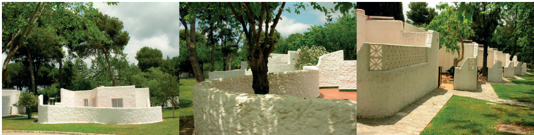
Figura 3. La relación entre lo construido y su entorno (2007).
