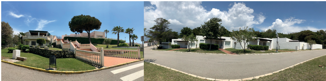
Figura 12. Izquierda: Edificio de usos recreativos varios junto al comedor. Derecha: Cinco viviendas para personas con movilidad reducida (2018).
