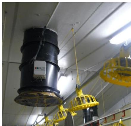
**Figura 4.** Imagen del ventilador situado en el techo de una de las naves
