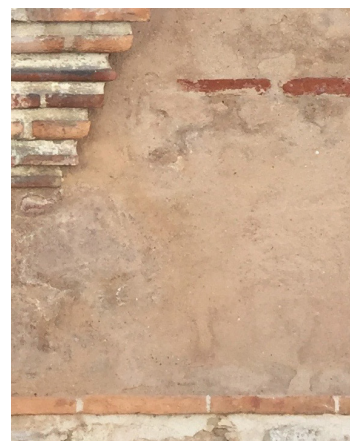
Detalle del muro del edificio con revestimiento.
