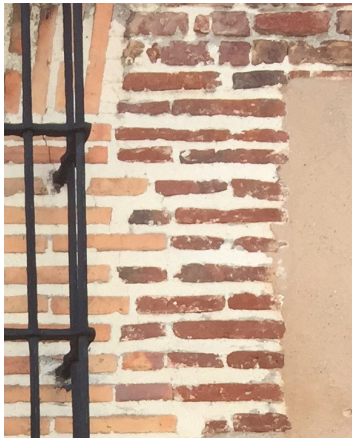
Detalle de ladrillo en la fachada principal.
