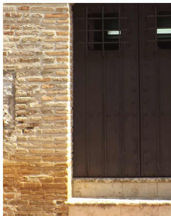
Detalle de Ladrillo visto en la fachada principal de las casas reales.
