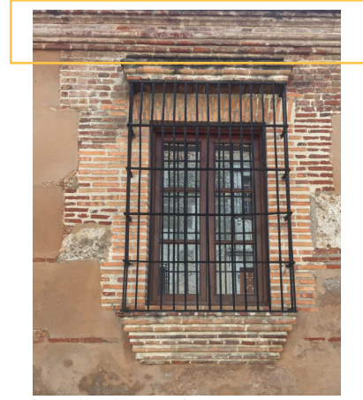
Detalle de cornisa.
