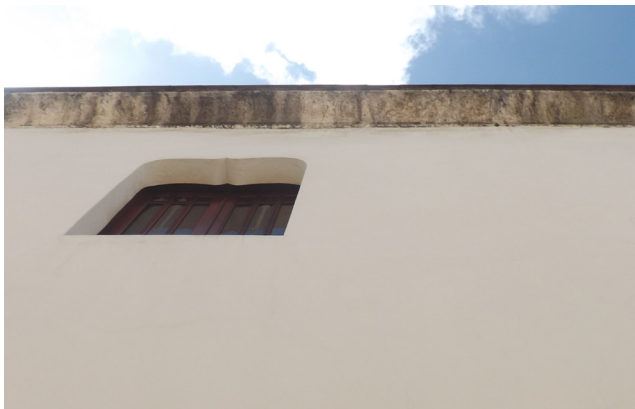
Detalle de la cornisa corrida en piedra con la parte de arriba en ladrillo.
