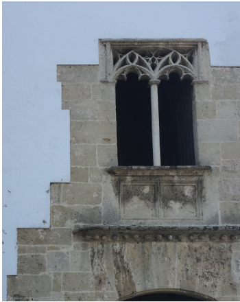
Detalle de ventan geminada del siglo XVI restaurada en el siglo XX..
