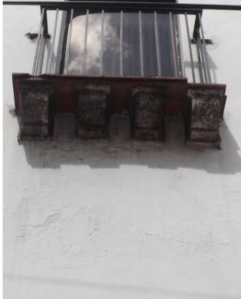
Detalle del antepecho del banco en piedra.
