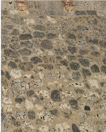
Detalle de piedra no homogénea e irregular en una de las paredes de la edificación.
