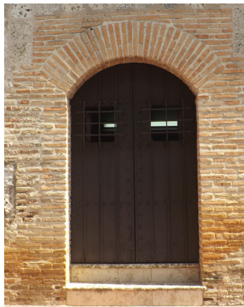
Detalle de puerta de dos hojas en madera reconstruida en el siglo XX
