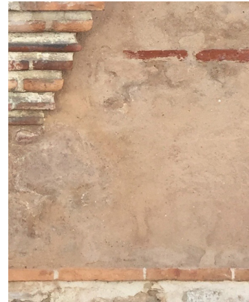
Detalle de piedra revestimiento en la edificación.
