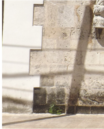
Detalle de piedra tallada y del revestimiento de cemento del edificio.
