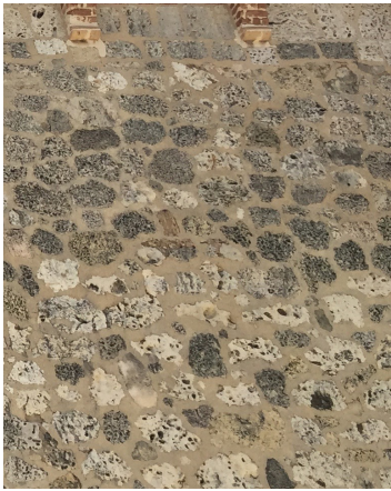
Detalle de piedra no homogénea e irregular en una de las paredes de la edificación.
