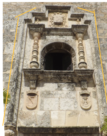
Detalle del arrabá en piedra que fue reconstruido en el siglo XX a partir de huellas.
