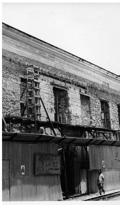
Vista del edificio en proceso de restauración. Fuente: Centro de Inventario de Bienes Culturales de Santo Domingo (CIBC)
