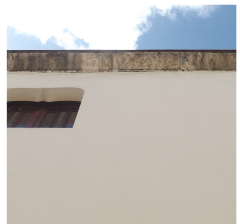
Detalle de la cornisa corrida en piedra con la parte de arriba en ladrillo.
