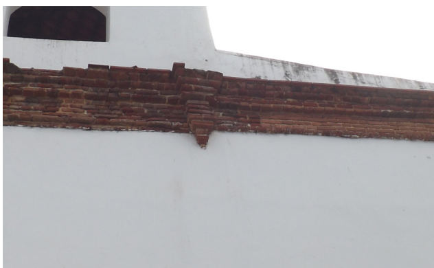
Detalle de cornisa en ladrillo.
