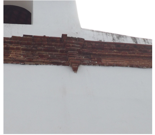
Detalle de cornisa en ladrillo.
