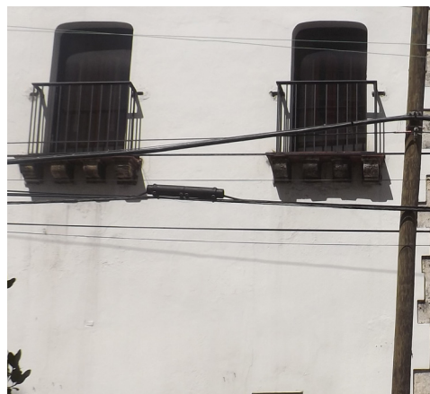
Detalle del balcón con balaustres en madera y antepecho en piedra.
