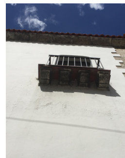
Detalle de balcón. Fuente propia.
