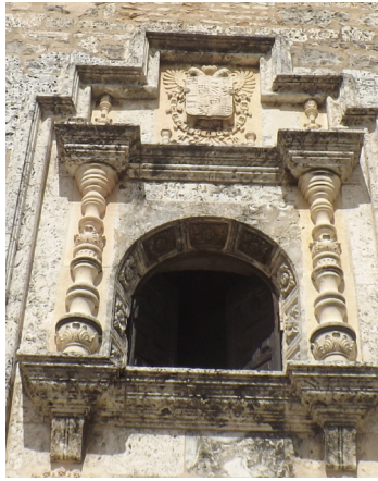
Detalle de ventana de dos hojas de madera de estilo plateresco del siglo XVI reconstruida en el siglo XX.
