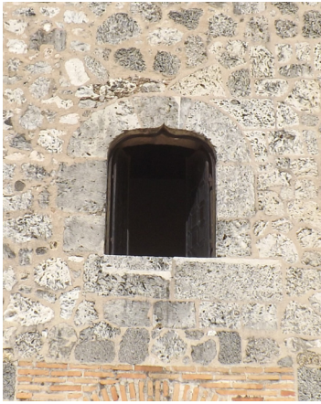
Detalle de ventana con arco conopial del siglo XVI reconstruida en el siglo XX.
