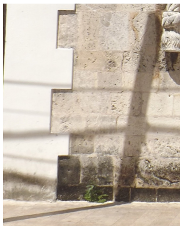
Detalle de piedra tallada y del revestimiento de cemento del edificio.
