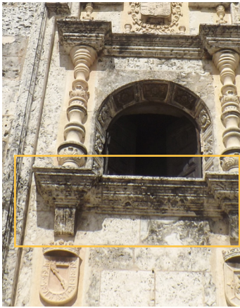
Detalle de antepecho en piedra que forma parte del conjunto del portón reconstruido en el siglo XX.
