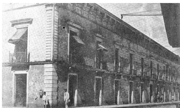
Fachada de las Casas Reales antes de su restauración Fuente: Centro de Inventario de Bienes Culturales de Santo Domingo (CIBC)
