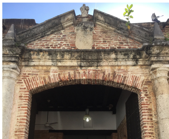
Detalle del portón después de su restauración. Fuente propia.
