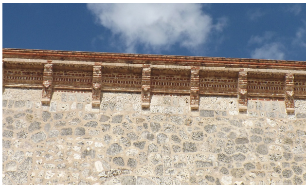
Vista de la cornisa y aleros en ladrillos añadidos a la edificación en el siglo XX.
