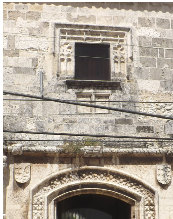
Detalle de arrabá que enmarca la ventana, todo el conjunto perteneciente al siglo XVI.
