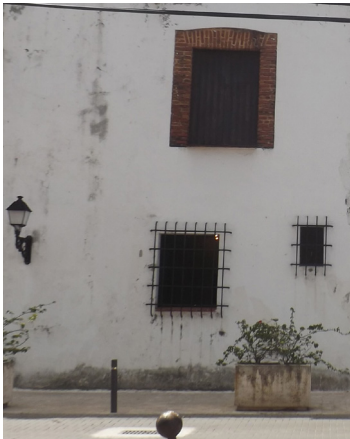
Detalle de ventana con rejería.
