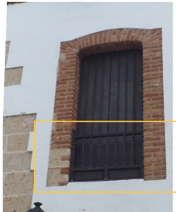
Detalle de balconcete.
