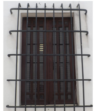
Detalle de ventana de dos hojas en madera con rejería del siglo XX.
