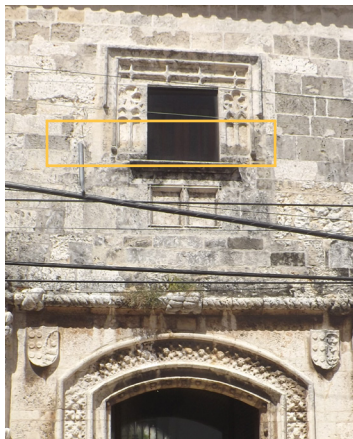
Detalle de alfeizar en el conjunto que conforma la ventana del siglo XVI.
