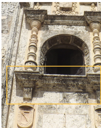
Detalle de antepecho en piedra que forma parte del conjunto del portón reconstruido en el siglo XX.
