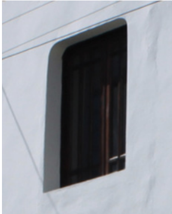
Detalle de ventana de dos hojas de madera reconstruida en el siglo XX.
