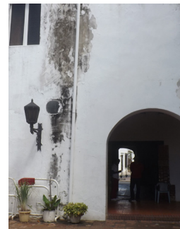
Detalle de arco, fuente propia.
