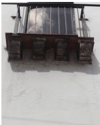
Detalle del antepecho del banco en piedra.
