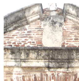
Detalle del portón. Fuente externa
