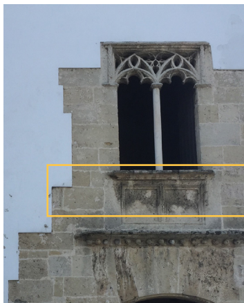
Detalle de ventana.
