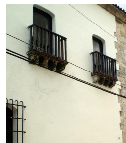
Detalle de balcón. Fuente externa
