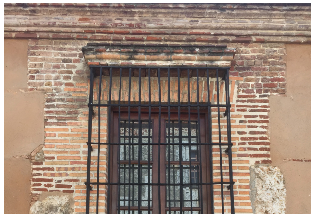
Detalle de cornisa.
