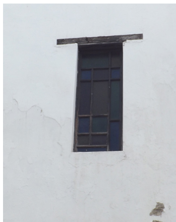
Detalle ventana con dintel apoyado.
