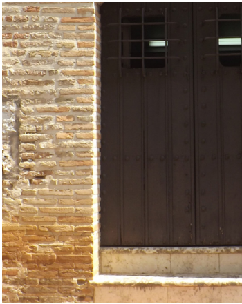
Detalle de Ladrillo visto en la fachada principal de las casas reales.
