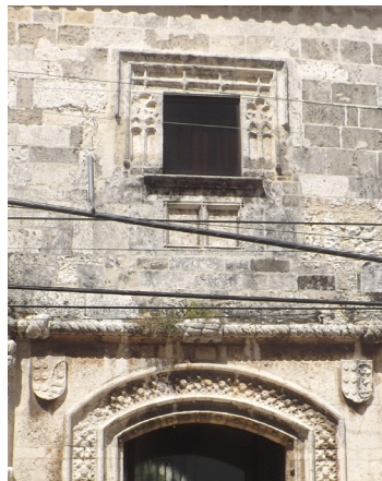
Detalle de arrabá que enmarca la ventana, todo el conjunto perteneciente al siglo XVI.
