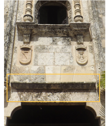
Detalle del guardapolvo en piedra sobre el portón principal, reconstruido en las reformas del siglo xx.
