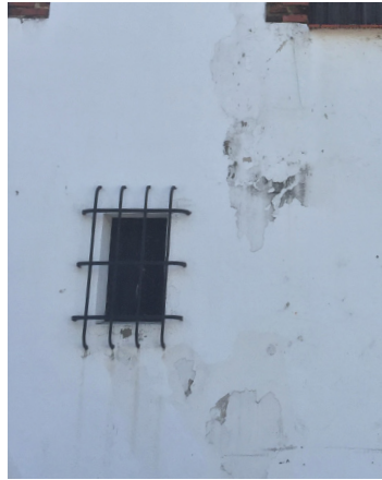
Detalle de ventana con rejería.
