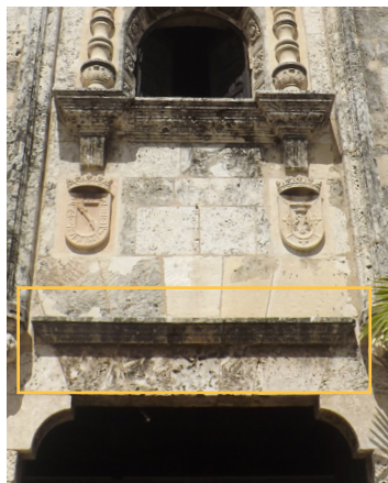
Detalle del guardapolvo en piedra sobre el portón principal, reconstruido en las reformas del siglo xx.
