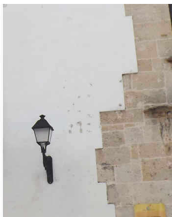
Detalle de revestimiento que oculta la piedra de la edificación.
