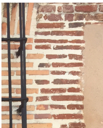
Detalle de ladrillo en la fachada principal.
