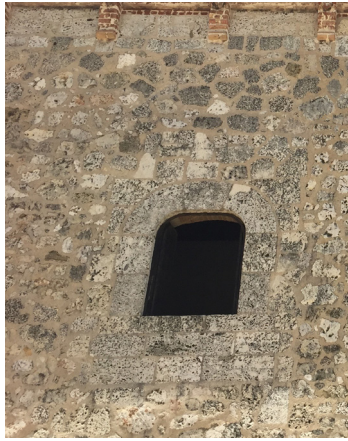
Detalle de ventana de dos hojas de madera reconstruida en el siglo XX.
