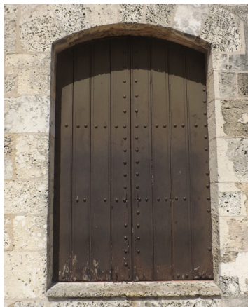
Detalle de puerta de dos hojas en madera reconstruida en el siglo XX
