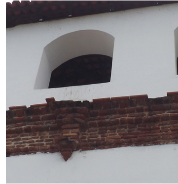
Detalle de ventaan de arco rebajado.
