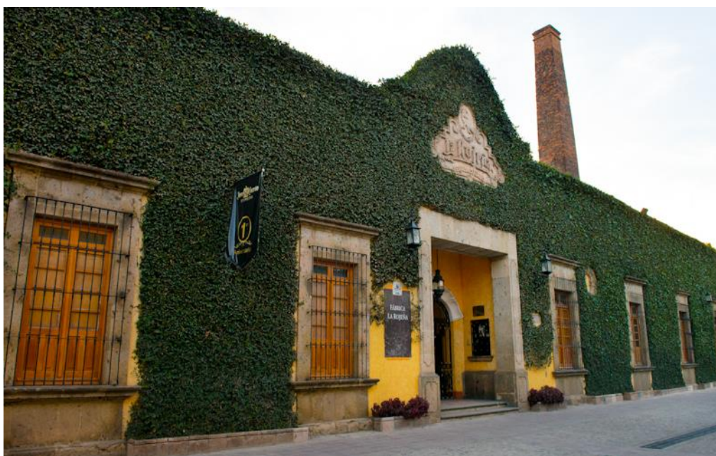
Imagen 51. Fachada de la fábrica "La Rojeña", Tequila, Jalisco, México
