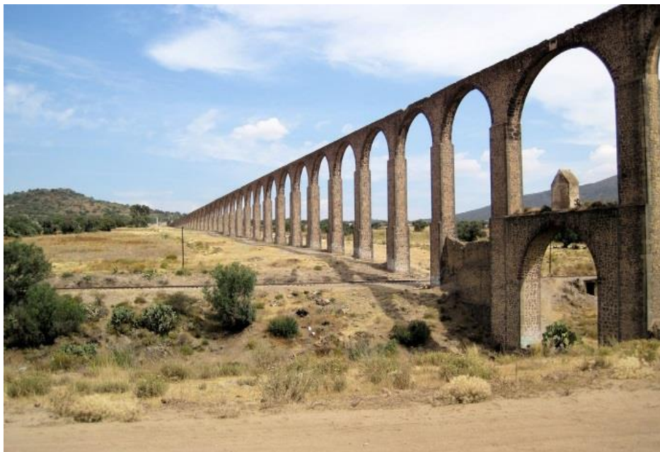
Imagen 36. Fotografía actual del Acueducto del Padre Tembleque, tomada desde la parte del Estado de México 87
