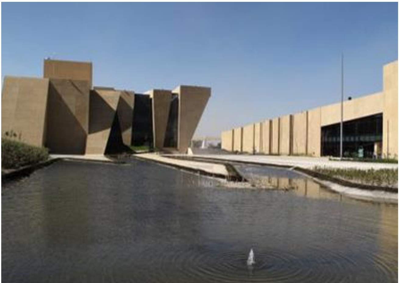
Imagen 67. Centro Cultural Mexiquense Bicentenario, Texcoco, Estado de México, México, proyectado por los arquitectos José Moyao y Alejandro Rivadeneira. 154
