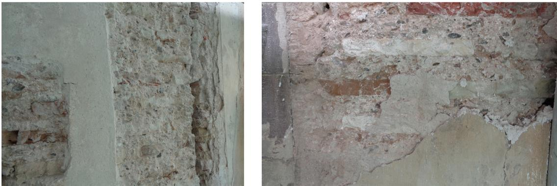
Ladrillos tomados con hormigón de cal en la fachada del palacio Lassala forman la hoja exterior que refuerza el muro de tapia.
