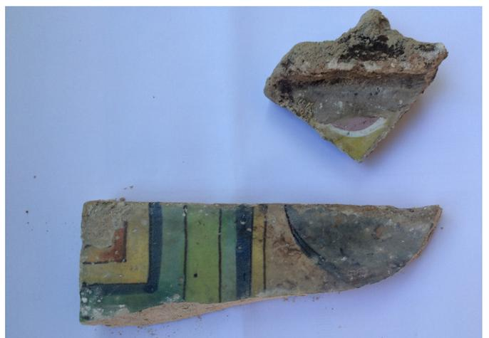
**FICHA 09:****REVESTIMIENTO 01: SILLAR FINGIDO EN EL MORTERO QUE ESTÁ EN CONTACTO CON EL MURO DE FÁBRICA DE LADRILLO****LOCALIZACIÓN**
