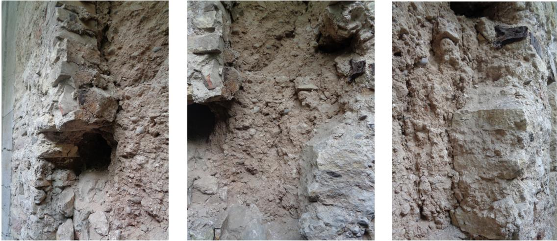
Tapia encontrada en planta baja del palacio Lassala, formada por tierra batida y una hoja de ladrillo tomado con hormigón de cal.
