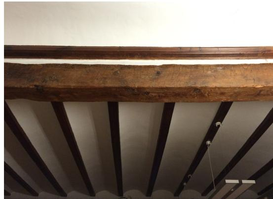
La imagen de la izquierda se corresponde con el forjado entre planta baja y el entresuelo. La imagen la derecha muestra el forjado entre planta segunda y la zona bajo cubierta. En ambas se aprecian revoltones con viguetas cortadas con serrucho.
