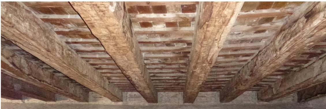
Cubierta entabacada de rasillas del palacio Lassala formada por vigas de sección 28x30 cm cortadas con serrucho, rastreles de madera de 9x4 cm y rasilla cerámica de 4 cm.
