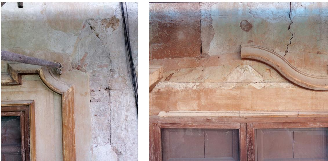
La imagen de la izquierda muestra el arco de ladrillo de la ventana central, mientras que en la derecha se aprecia que en lugar de un gran arco hay varias dovelas de piedra
