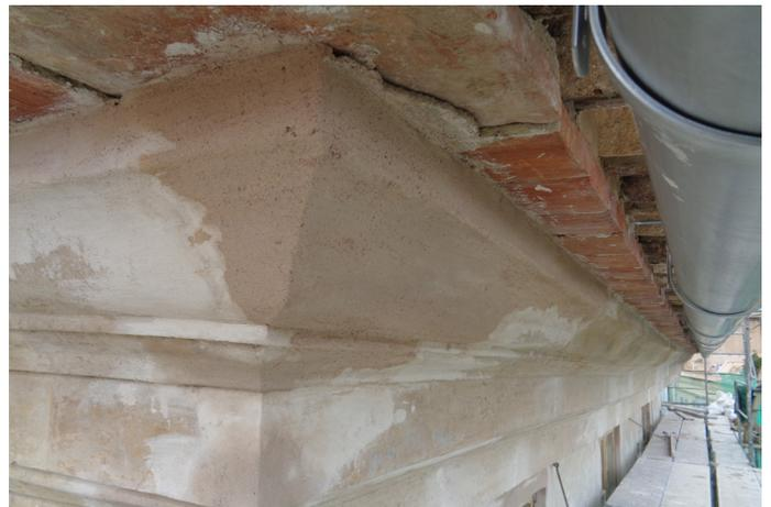
**FICHA 29:****RETIRADA DE LA MOLDURA Y FABRICACIÓN DE MOLDE PARA REPONERLA****LOCALIZACIÓN**
