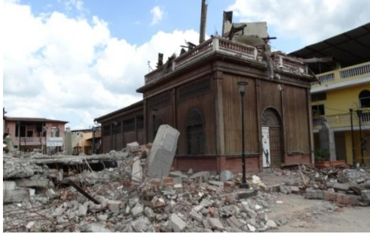
Ilustración 104: Torre de Reloj de Calceta post terremoto del 16A. (Manuel Barcia, abril de 2016)
