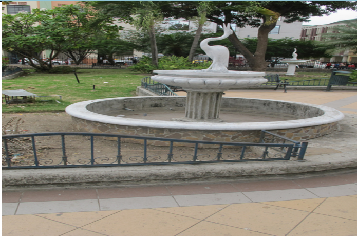
Descripcion Fuente de agua, base de la pileta no es original.
