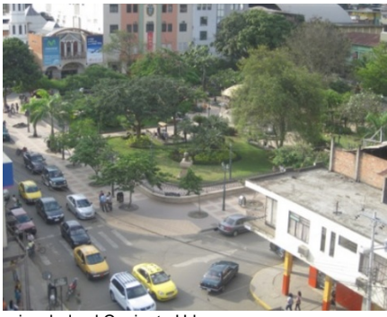
Espacio público vinculado al Conjunto Urbano.
