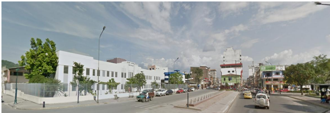
Ilustración 96: Avenida Urbina y Colegio Portoviejo frente a la Plaza Alfaro, 2015. (Google)
