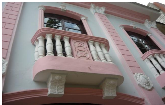
Ilustración 52: Detalle de balcón y ornamentación de la Casa Cevallos Arizaga. (INPC, 2017)
