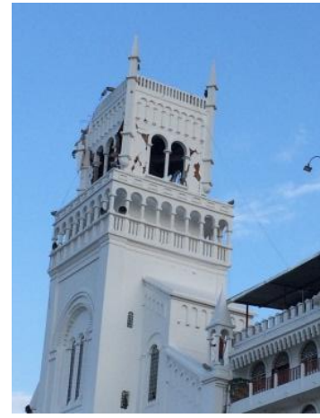
Ilustración 107: Torre de la Basílica Menor post terremoto del 16A. Manuel Barcia, abril de 2016)
