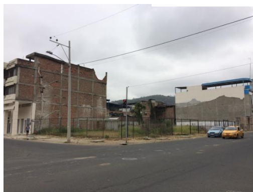
Ilustración 38: Solar donde existía la Pensione Cristal, edificación que colapsó por el terremoto del 16°. (Manuel Barcia, 2018)
