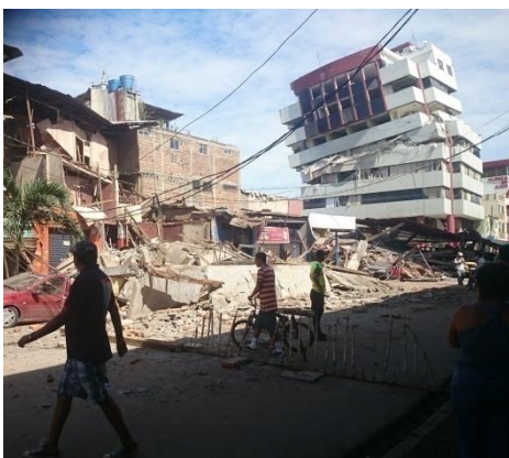
Ilustración 111: Edificio Mutualista Pichincha post terremoto 16A, calle 9 de octubre. (Manuel Barcia, abril 2016)
