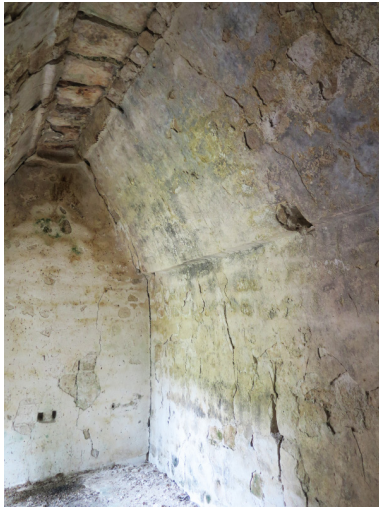
Figura 141. Ménsula de remate con el recubrimiento de estuco en el Palacio de Santa Rosa Xtampak.
