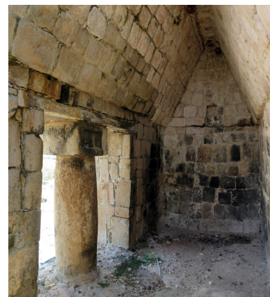
Figura 259. Portada provista de una columna central en una estancia del Palacio de los Cinco Pisos de Edzná.
