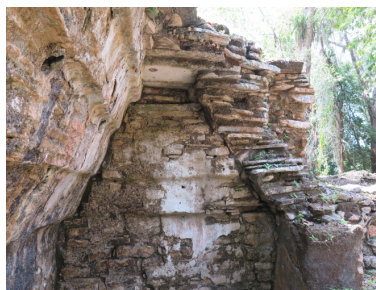
Figura 158. Estructura 74 de Yaxchilán.
