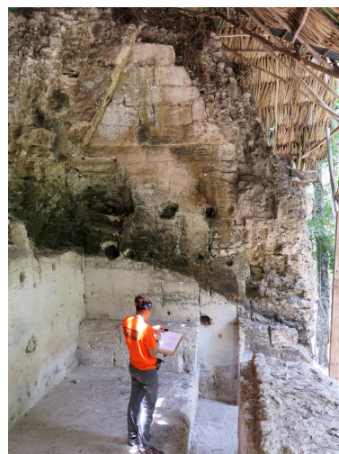
Figura 150. Cuarto 14 del Edificio 6J2 de La Blanca.
