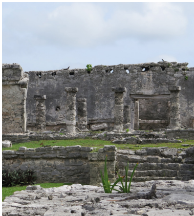
Figura 175. Edificio en Tulum, donde se aprecian las huellas del forjado de vigas de madera.
