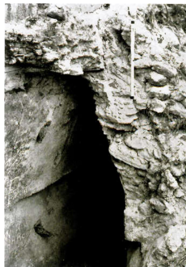
Figura 316. Bóveda del cuarto 6 de la Estructura A-XVIII de Uaxactún antes de los trabajos de restauración del edificio. Tomada de A. L. Smith (1937).
