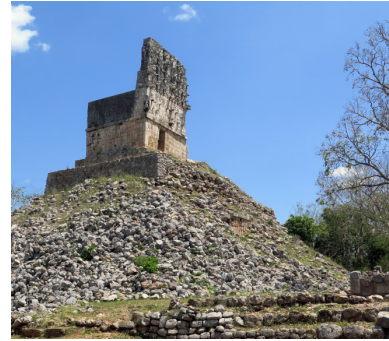
Figura 219. Crestería apoyada sobre la fachada delantera en la Estructura 4 de Labná.
