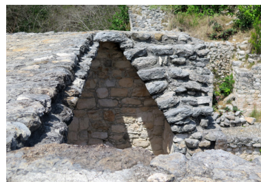
Figura 348. Detalle de bóveda en la Estructura 16 de Ek Balam.
