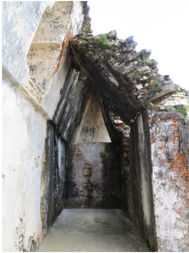
Figura 372. Vuelco como sólido rígido de una bóveda en la Casa D del Palacio de Palenque.
