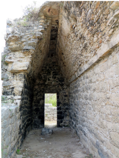
Figura 185. Bóveda de la Estructura 57 de Dzibilchaltún.
