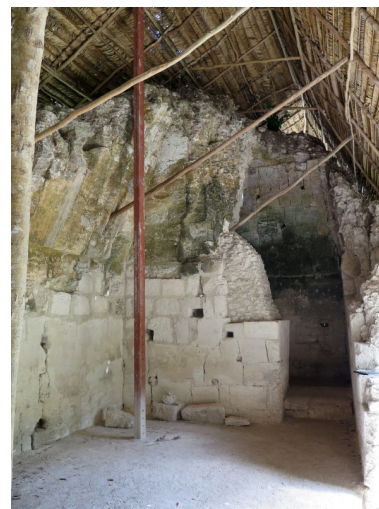
Figura 114. Cuarto 3 del Edificio 6J1 de La Blanca.
