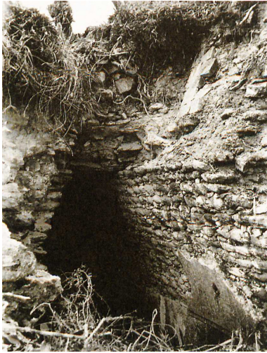
Figura 79. Bóveda en la Estructura VIII de Becán. Tomada de D. F. Potter (1977, p. 55).
