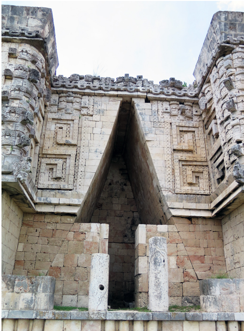
Figura 135. Uno de los arcos del Palacio del Gobernador de Uxmal.
