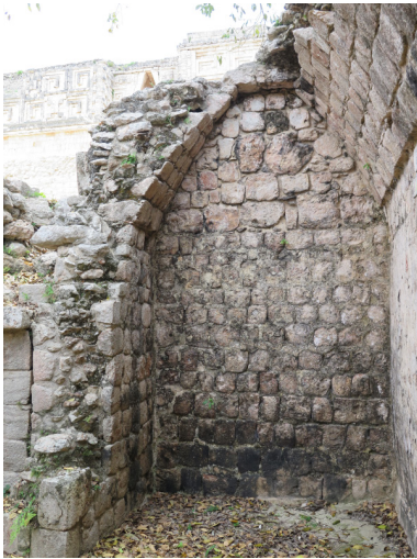
Figura 196. Testero vertical en el Templo Chenes 1 de Uxmal.
