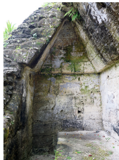
Figura 126. Bóveda de sección recta en el Edificio E de Nakum.
