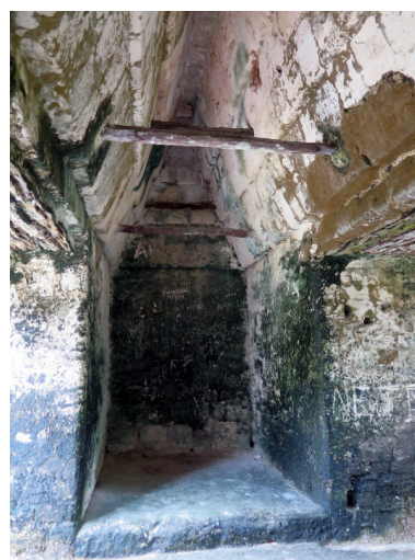
Figura 130. Bóveda con escalonamiento múltiple inclinado en el Edificio 5D-91 de Tikal.
