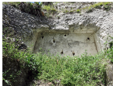
Figura 360. Bóveda en el Edificio Y de Nakum
