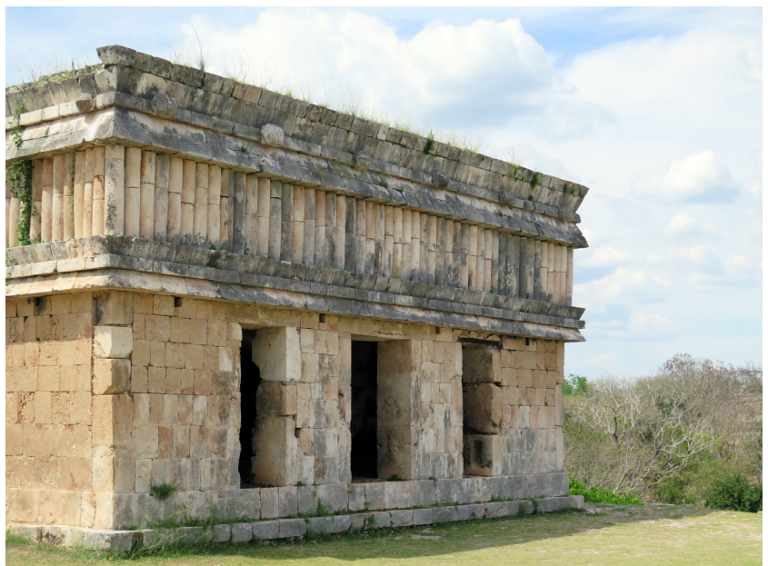
Figura 209. Fachada este de la Casa de las Tortugas de Uxmal, donde se aprecian los mechinales bajo la cornisa media.
