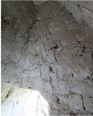
Figura 200. Cuarto 8 del Edificio 3E1 de Chilonché.
