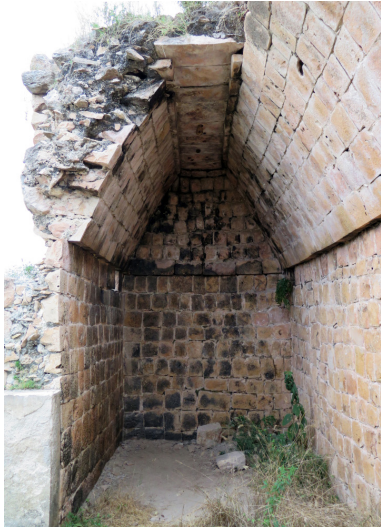
Figura 337. Bóveda en el Palacio Chich (CA-7) de Oxkintok.
