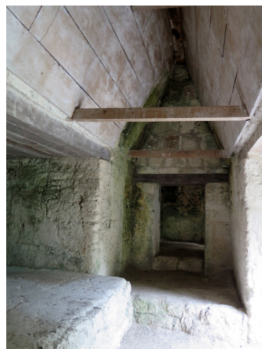
Figura 386. Bóveda en el Edificio N de Nakum.
