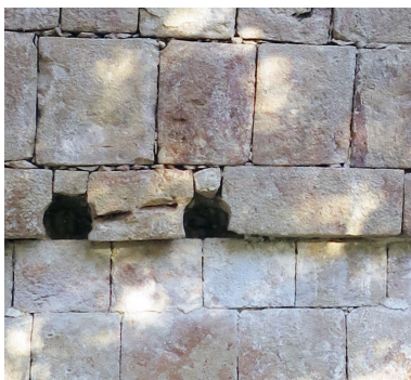
Figura 231. Detalle de un hueco de morillo doble sobre la línea de impostas de la en el Edificio Oeste del Cuadrángulo de las Monjas de Uxmal.
