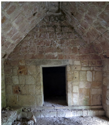
Figura 116. Cuarto 11 de la Estructura 5 de Chacmultún.
