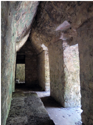
Figura 134. Estructura 19 de Yaxchilán.
