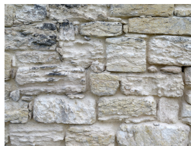
Figura 375. Deterioro de la piedra caliza por meteorización en la Acrópolis Central de Tikal.
