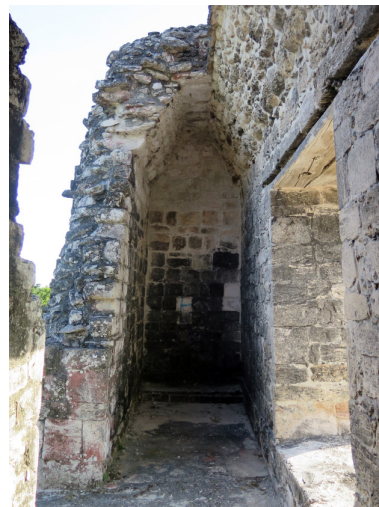
Figura 328. Estructura X de Becán.
