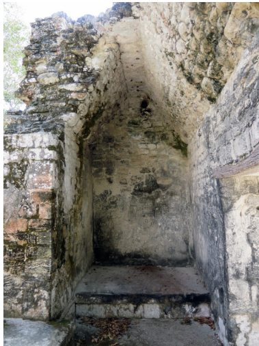
Figura 180. Bóveda de la Estructura II de Chiccanná.
