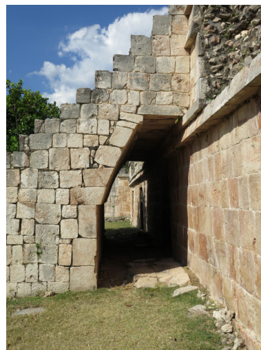
Figura 288. Media bóveda bajo escalinata en la Estructura 2C3 de Kabah.
