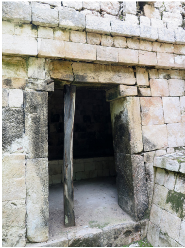
Figura 363. Dintel de piedra apeado en el Cuad. Sureste de Santa Rosa Xtampak.
