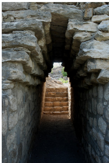
Figura 35. Pasillo abovedado en la Estructura 14 del sitio de Xochipala (Guerrero, México). Fuente: INAH.
