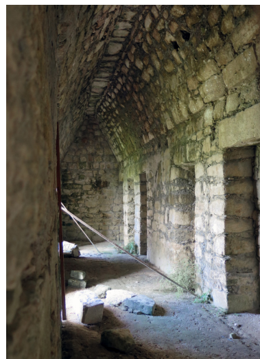
Figura 350. Estancia principal del edificio superior del Conjunto de las Monjas de Chichén Itzá.
