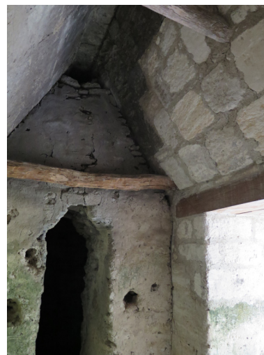
Figura 356. Bóveda parcialmente restituida sobre un nuevo dintel en el Edificio VII de San Clemente.
