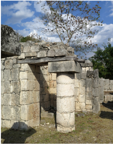
Figura 351. Dinteles sobre columnas en la Estructura 3C6 de Chichén Itzá.
