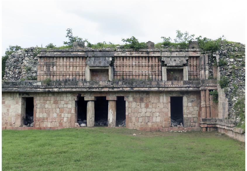
Figura 379. Fachada sur del Edificio 1 de Chacmultún. Imagen superior: fotografía de principios del siglo XX tomada de T. Maler (1997). Imagen inferior: fotografía actual.
