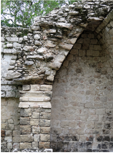
Figura 329. Bóveda en el Palacio de Santa Rosa Xtampak.
