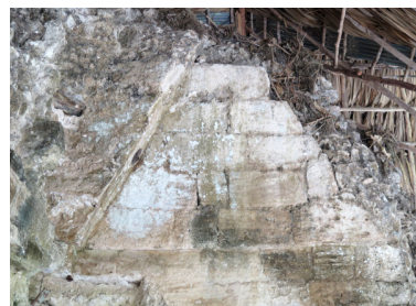
Figura 199. Testero de la bóveda del cuarto 14 del Edificio 6J2 de La Blanca.
