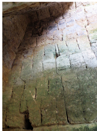
Figura 214. Aparejo de las dovelas sin traba en el plano del intradós en la bóveda del cuarto 2 del Palacio de Oriente de La Blanca.
