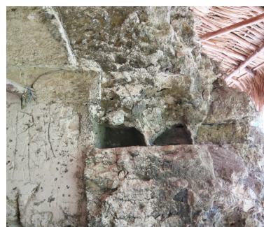
Figura 149. Huella de los dinteles en el relleno del cuarto 5 del Edificio 6J2 de La Blanca, donde se aprecia la diferencia de cota entre la cama de apoyo de los cargaderos y el arranque de la bóveda.
