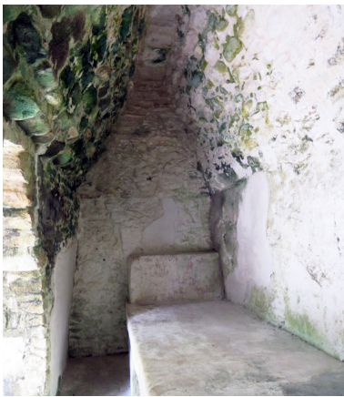
Figura 319. Bóveda en el Edificio E1 de la Acrópolis de Cahal Pech.
