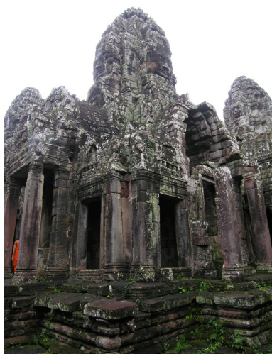
Figura 27. Bóveda por aproximación de bloques de piedra colocados a hueso en Bayon. Fotografía de Francesco Bandarin, tomada de Unesco (2005).
