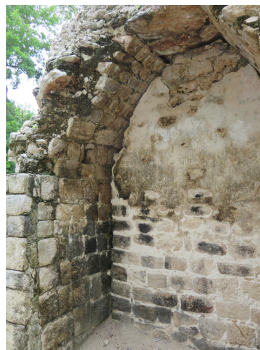
Figura 153. Muro hastial en el Edificio Boca de Serpiente de Santa Rosa Xtampak.
