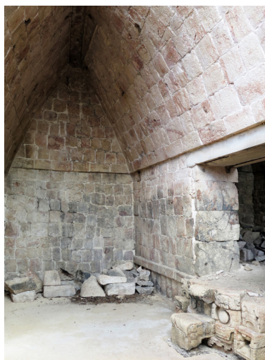
Figura 340. Estancia del Edificio Codz Pop (2C6) de Kabah.
