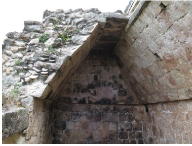
Figura 189. Bóveda del Edificio 2 del Grupo Este de Kabah.
