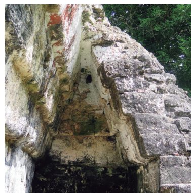
Figura 188. Bóveda de la crujía exterior del Palacio de las Ventanas de Tikal.
