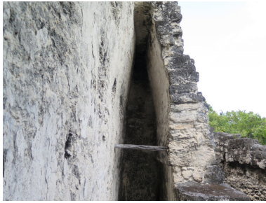
Figura 184. Bóveda en el Edificio 23 de la Acrópolis Norte de Tikal.
