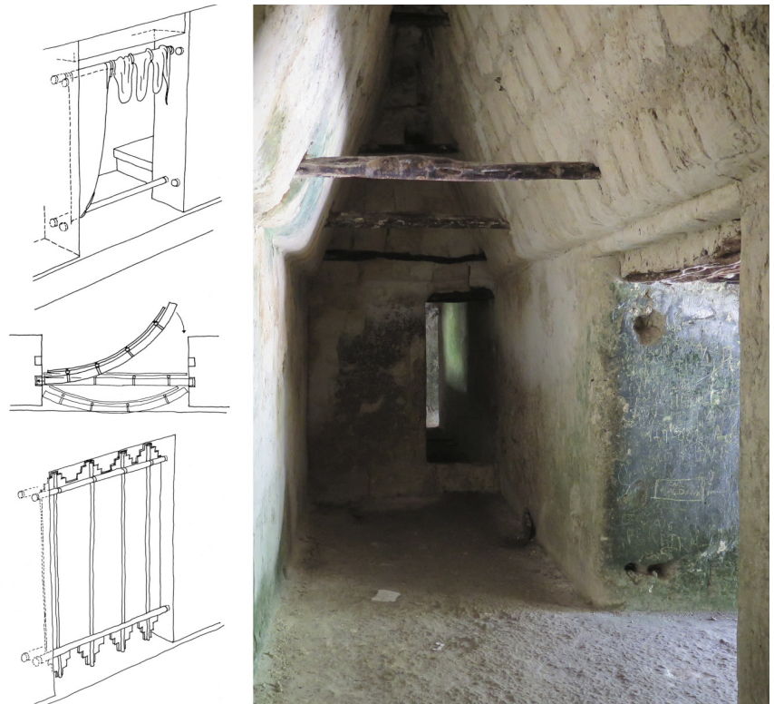
Figura 266. Izquierda: Reconstrucción hipotética de varios sistemas de cierre de puertas con portavaras según Hasso Hohmann (2017, p. 120). Derecha: Portavaras en el Palacio de las Ventanas de Tikal.
