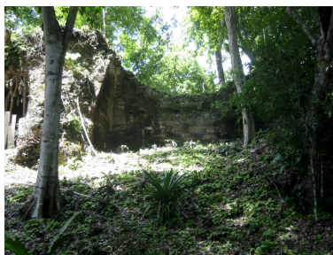
Figura 371. Cuarto 4 del Edificio 6J2 de La Blanca antes del inicio de las labores de excavación en el sitio. Fotografía: Gaspar Muñoz Cosme, 2004.
