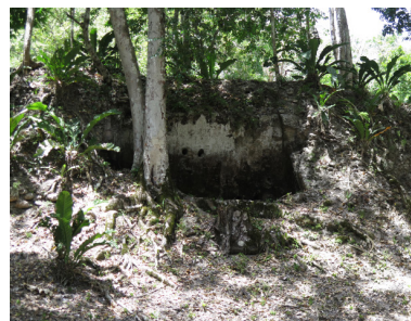
Figura 374. Bóveda del Edificio D de Nakum.
