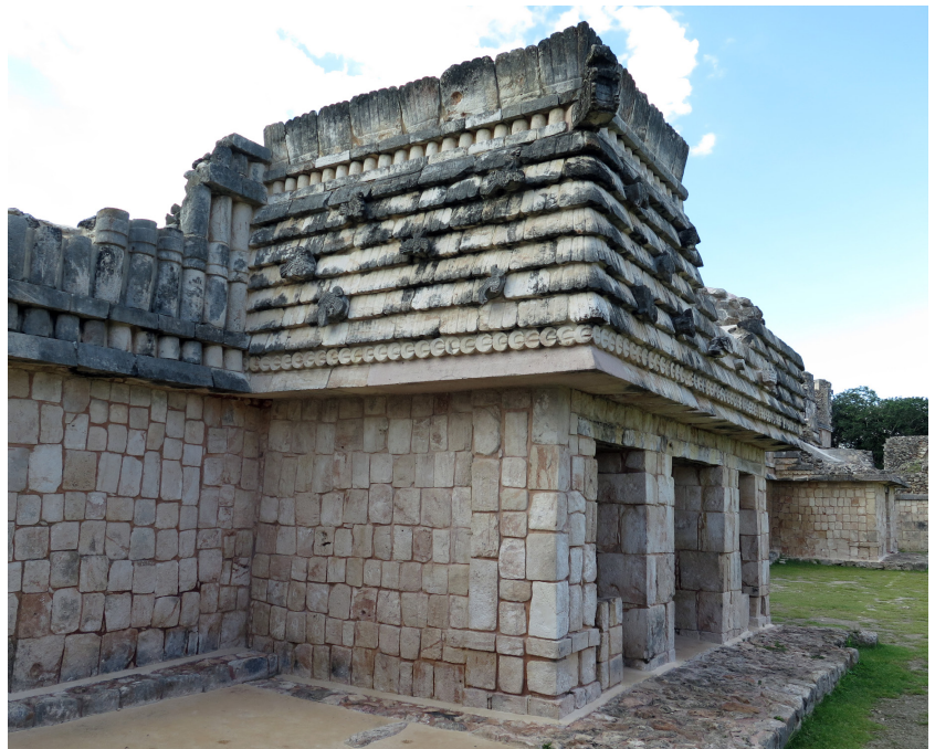
Figura 300. Fachada del edificio oeste del Cuadrángulo de los Pájaros de Uxmal.
