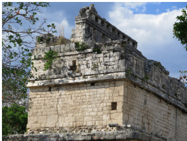
Figura 248. Superior: Alzado sur de la Casa Colorada de Chichén Itzá tomado de G. Andrews (1991a, p.23). Inferior: Fotografía actual del edificio.
