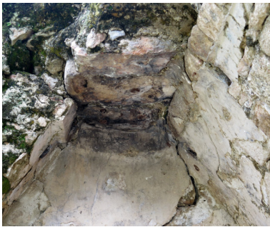
Figura 330. Detalle del revestimiento de estuco de la ménsula de remate en el Palacio de Santa Rosa Xtampak.
