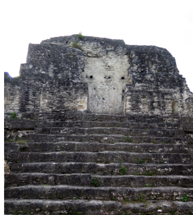
Figura 359. Templo 23 de la Acrópolis Norte de Tikal, en el que se ha derrumbado la parte central de la semibóveda principal y de la tapa de la crujía interior.
