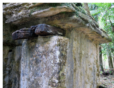
Figura 163. Restos de los dinteles originales de madera en la Estructura 7 de Yaxchilán.
