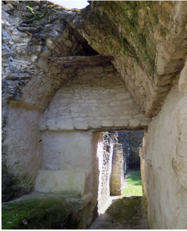
Figura 317. Bóveda en la Acrópolis Central de Naranjo.
