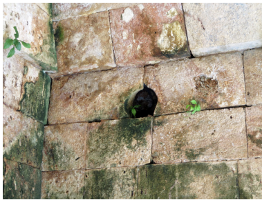
Figura 230. Detalle de un hueco de morillo en la Casa de las Tortugas de Uxmal.
