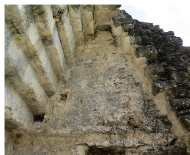
Figura 129. Bóveda con escalonamiento múltiple vertical en el Edificio E-X de Uaxactún.
