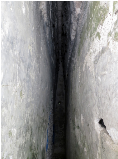
Figura 274. Cuarto interior del Edificio A de Nakum, con una luz de 60 cm.
