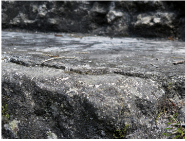
Figura 208. Detalle de la capa de estuco sobre la cama de los dinteles en el Edificio R de Nakum.
