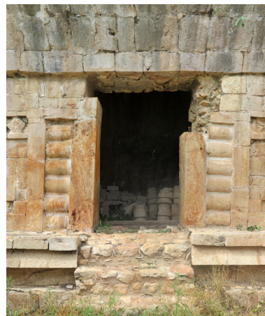
Figura 366. Vano de acceso al cuarto 24 del Palacio o Estructura 1 de Labná.
