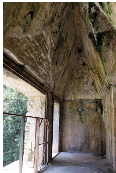
Figura 381. Vista interior de la primera crujía del Templo del Sol de Palenque, donde se aprecia la zona de la semibóveda restituida.
