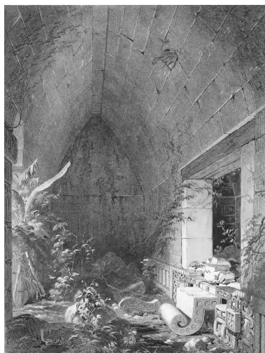
Figura 40. Dibujo de Frederick Catherwood (1844) del interior uno de los cuartos del edificio Codz Pop de Kabah.
