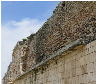
Figura 217. Detalle de la fachada oeste del Palacio del Gobernador de Uxmal.
