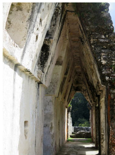
Figura 183. Bóveda de la crujía interior de la Casa A del Palacio de Palenque.
