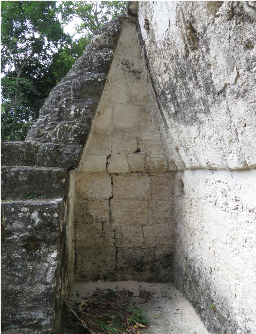
Figura 321. Bóveda en el Edificio Z de Nakum.
