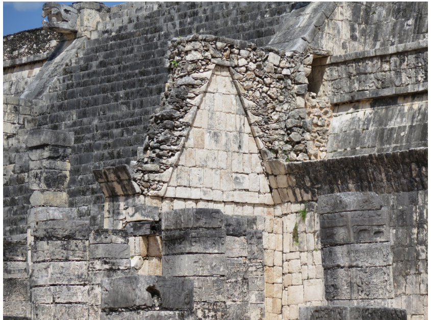
Figura 352. Testero de una de las bóvedas en el Templo de los Guerreros de Chichén Itzá.
