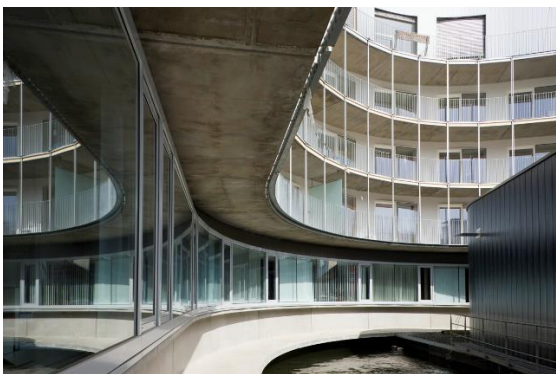
Ilustración 40: Vista de fachada interior-Planta baja
