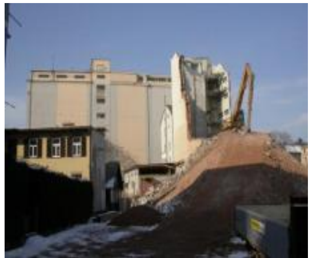
Ilustración 4: Demolición del Marienmühle año 2005
