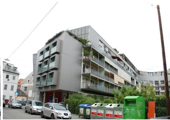
Ilustración 39: Vista exterior fachada secundaria-Ala B
