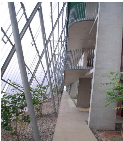
Ilustración 36: Vista interior-estructura metálica de la fachada
