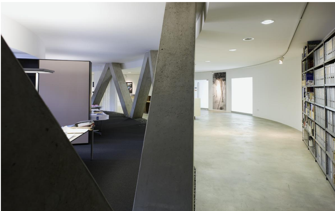
Ilustración 15: Vista interior estudio de arquitectura Perenthaler: cerchas triangulares
