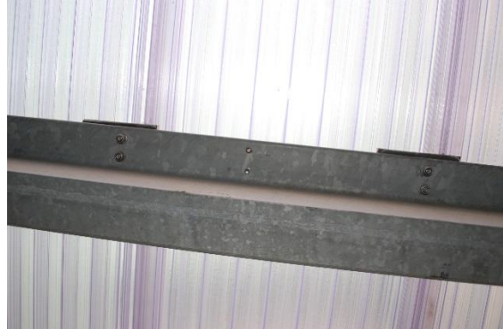
Ilustración 34: Detalle de perfil metálico con piezas de agarre
