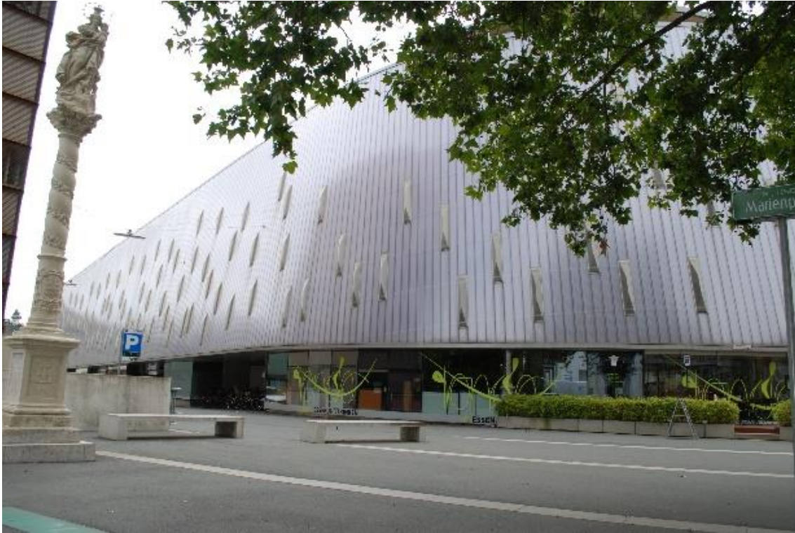
Ilustración 29: Imagen exterior de fachada principal
