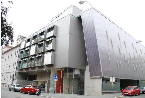
Ilustración 38: Vista de fachada exterior secundaria-Ala A
