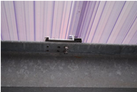
Ilustración 33: Detalle pieza metálica de sujeción
