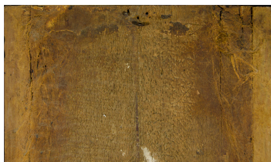
Fig. 67 Detalle de la zona superior del reverso fracturado.
