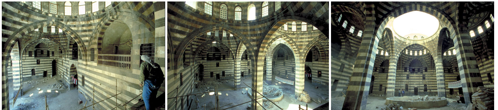
Imágenes 72, 73, 74. Fotografías del patio interior durante la restauración.
