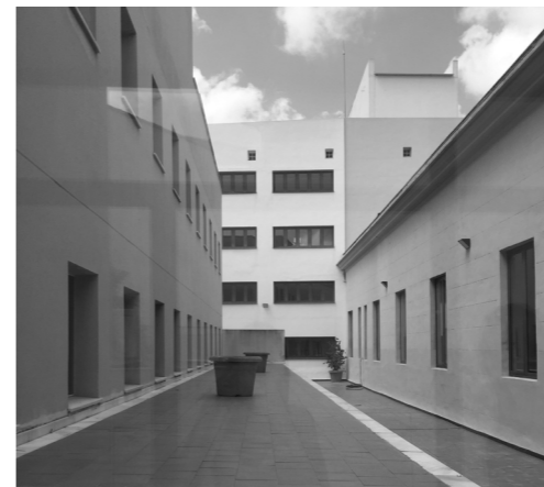
Figura 66. Vista unión entre edificios.
