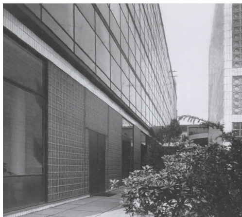
Figura 46. Espacio verde exterior del edificio.
