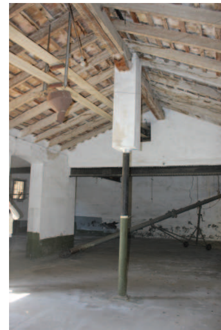
Sistema mediante vigas y viguetas de madera
