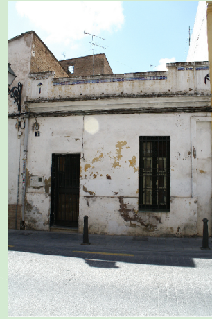
VIVIENDA 10.03a CONSTRUIDA HACE 71 AÑOS
