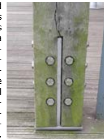
ANCLAJE Y TORNILLOS OCULTOS
