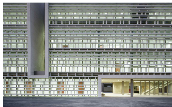
Facultad de telecomunicaciones de Valencia.
