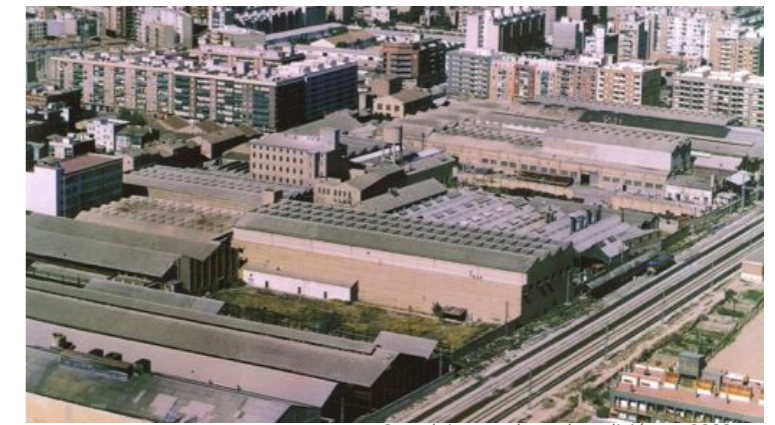
Complejo antes de su demolición en 2009.
