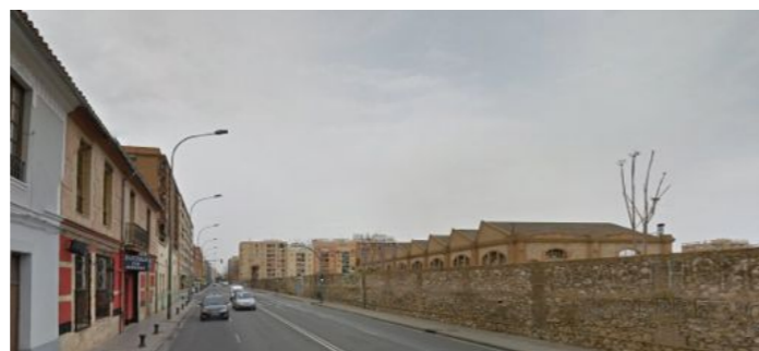
Vista de la parcela desde la calle San Vicente Ferrer.
