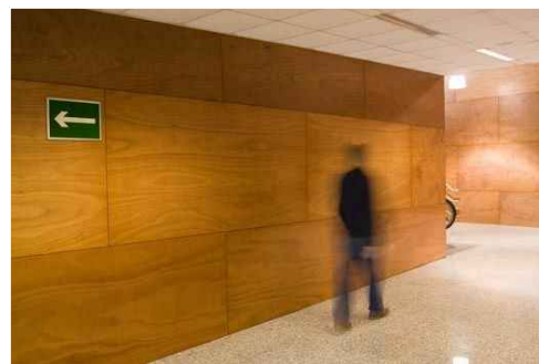
Revestimiento de tabiquería con paneles de contrachapado, con rieles de anclaje a montantes de madera
