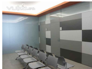
Revestimiento de pared con composición de paneles fenólicos en escala de grises.
