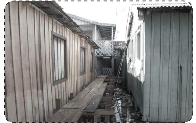
Accesos viviendas situadas en los Igarapés
