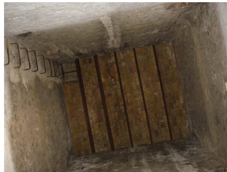
Primer forjado que se aprecia en la torre derecha
