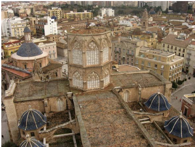
Imagen de las cubiertas de la Catedral de Valencia. Ejemplo de la doble función que originalmente cumplían las bóvedas
