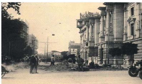
El ayuntamiento en construcción. Vista 1
