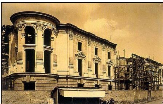
El ayuntamiento en construcción. Vista 2
