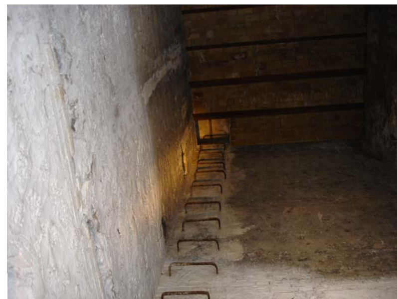
Acceso de la torre derecha mediante escalerilla
