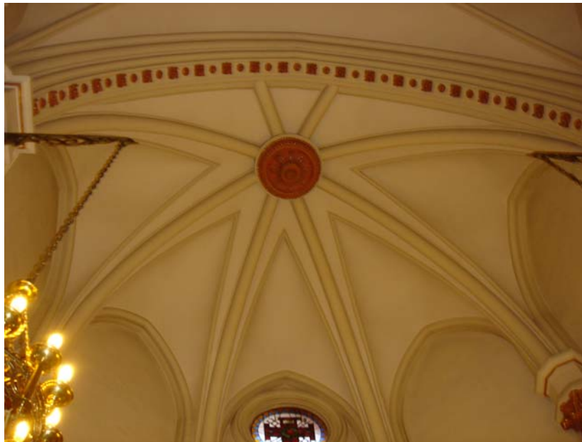
Imagen de la Bóveda de crucería radial del ábside
