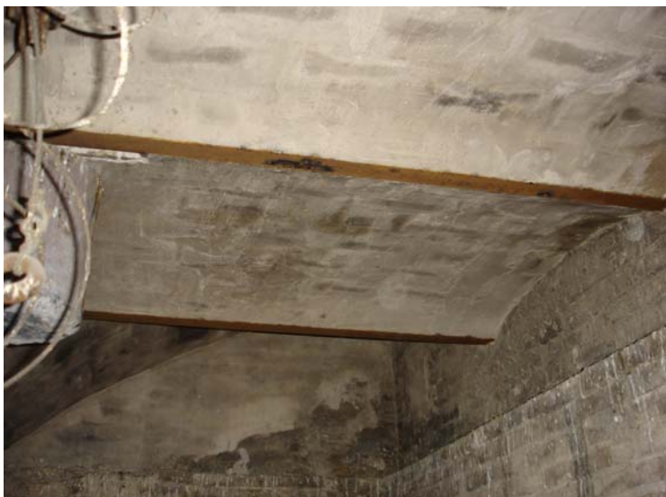
Forjado sobre el que se encuentra el habitáculo para la maquinaria del reloj en la torre izquierda
