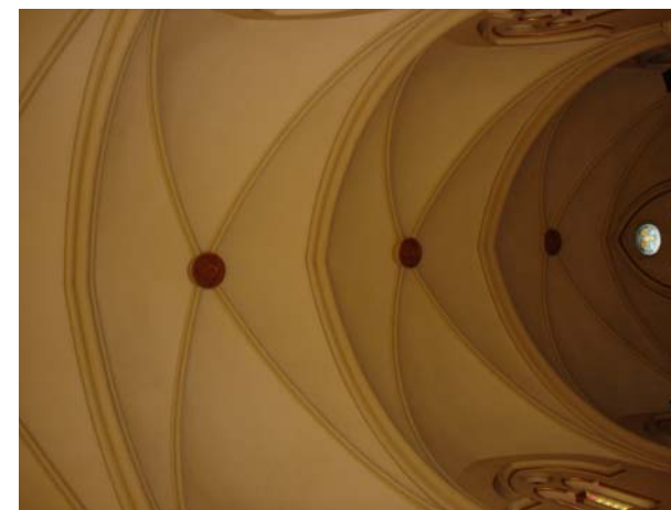
Bóvedas de crucería cuatrimpartitas
