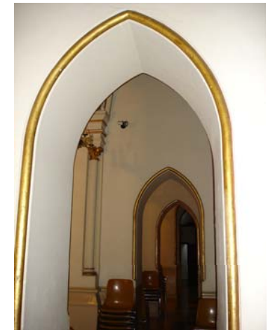
Pasos entre contrafuertes que comunican las capillas
