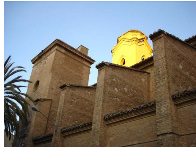
Contrafuertes laterales entre los cuales se sitúan las capillas
