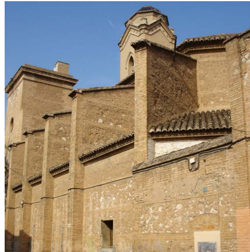
Imagen en la que se aprecian los contrafuertes y los muros de cierre confeccionados de igual forma
