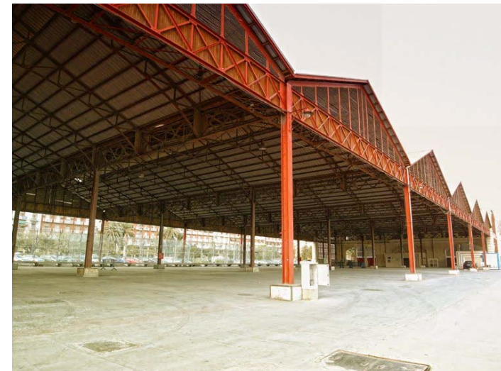
Tinglados del puerto de Valencia. Ejemplo del uso de nuevos materiales
