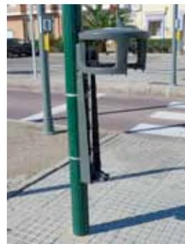
Imagen 5. Distintas formas de fijación al soporte: empotramiento, mediante pernos o sujeción por flejes metálicos.
