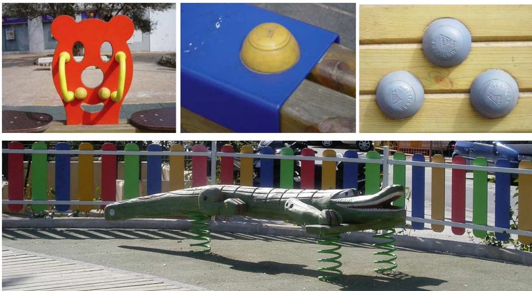
*Imagen 6. Aspectos de seguridad en área de juego: asideros, tornillería autoblocante con revestimiento plástico, vallado perimetral, pavimento de acceso y amortiguación bajo el elemento de muelles.*
