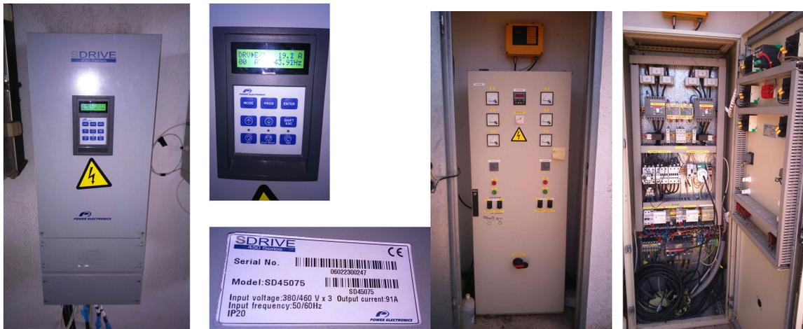
Figura 2.3.4: Variador de frecuencia de la bomba del Pozo Pamis II (izquierda) Arrancador de la bomba del pozo Pamis I, instalado en el centro de transformación de los pozos Pamis (derecha)
