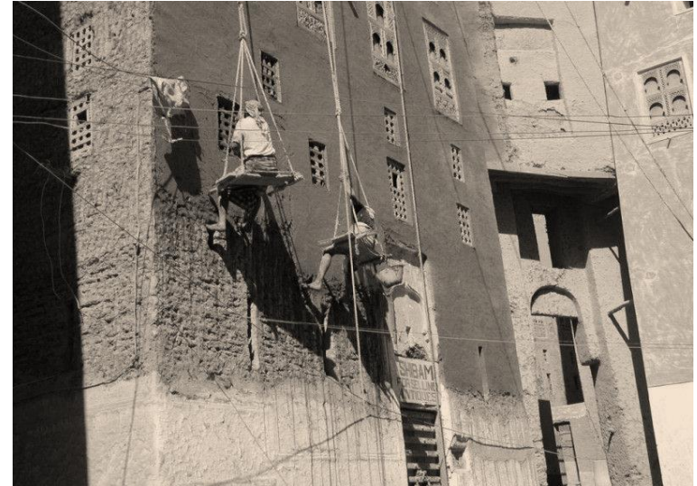
Fig. 34, Reparación de la fachada de un edificio en Shibam
