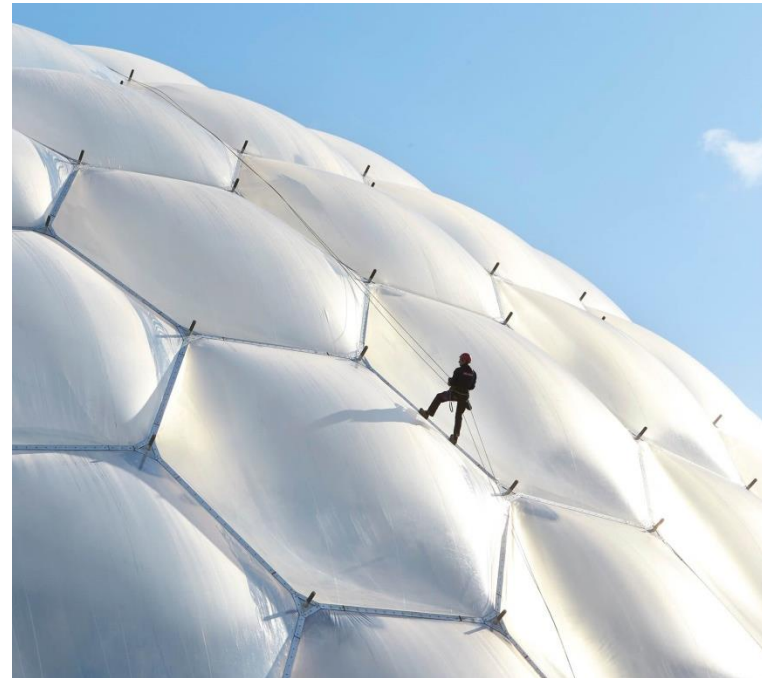
Fig. 69, Vista exterior detalle de una cúpula de Eden Project
