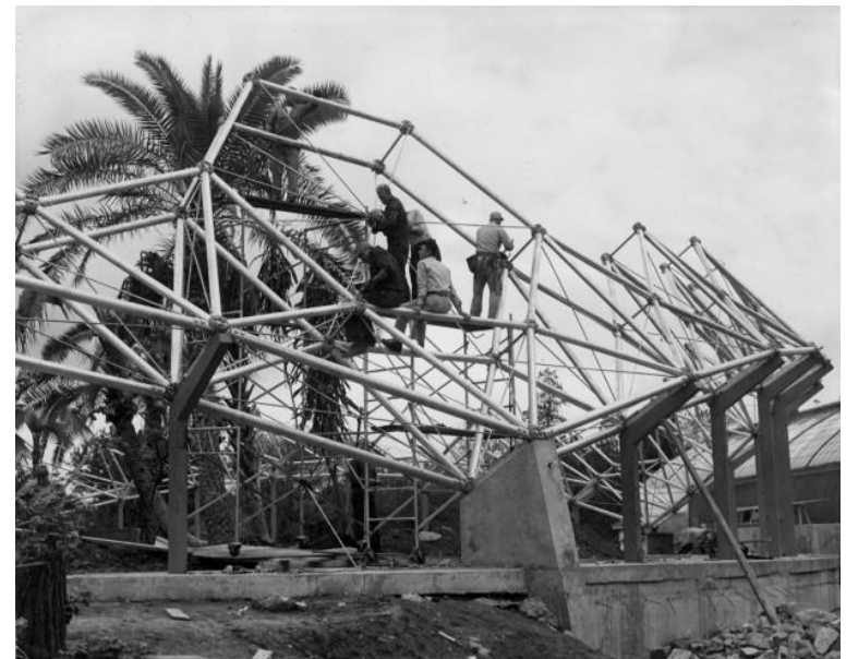
Fig. 67, Construcción de la cúpula del Jardín Botánico
