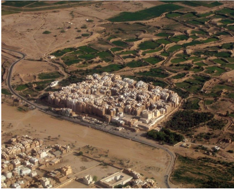
Fig. 32, Vista aérea de Shibam y los campos de cultivo anegados
