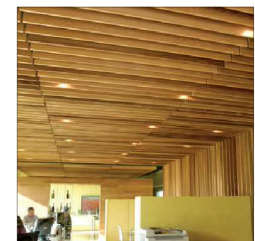
FALSO TECHO LAMAS MADERA ABIERTA
