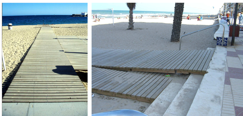
Imagen 7. Pasarelas de duelas anexa a plataforma y actuando como rampa.
