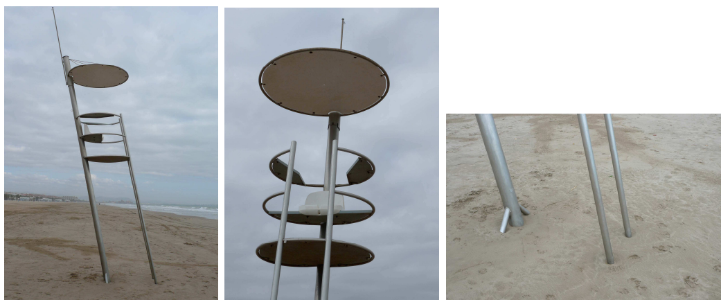
Imagen 11. Silla de vigilancia de estructura de acero galvanizado con asiento independiente de plástico termoconformado y sombrilla.
