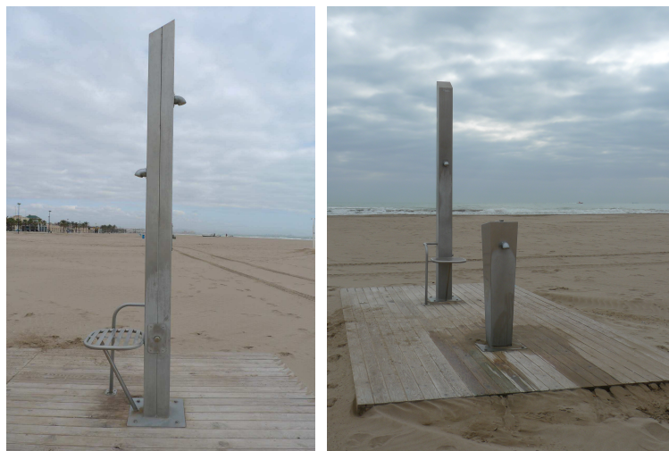
Imagen 3. Área de ducha y lava—piés. La ducha doble adaptada presenta doble altura de rociado y asiento con elemento de agarre.
