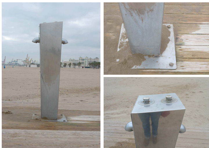
Imagen 5. Lava-piés: Conjunto y vistas de detalle que permiten observar el sistema de anclaje con pletina atornillada y los pulsadores en la parte superior.
