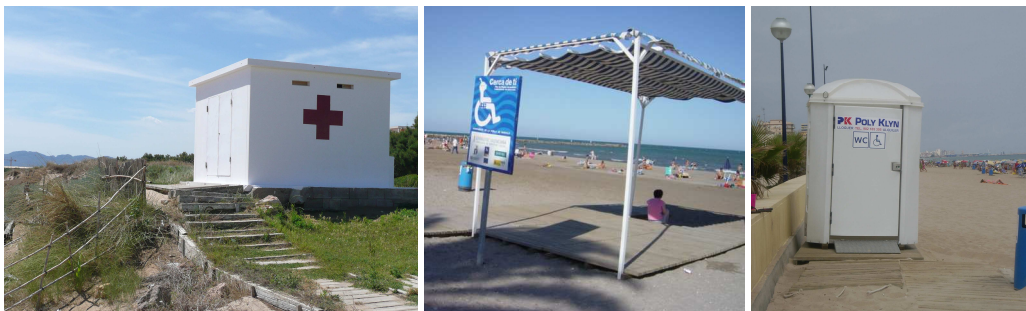
Imagen 2. Elementos de uso y servicio que, en ocasiones requieren instalaciones y toma de servicios.
