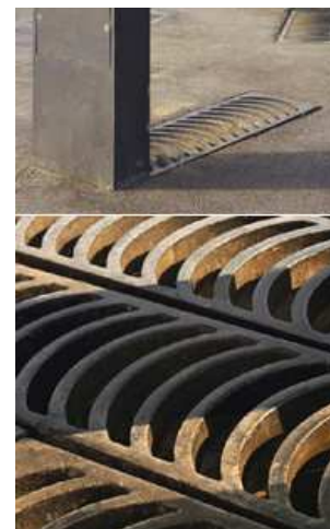
Imagen 5. Fuente de hormigón con distintos niveles para facilitar el acceso a los niños, fuente de plato en fundición de aluminio con pedal circular de accionamiento y detalle de la rejilla de fundición de fuente de caída descendente.
