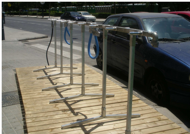
Imagen 3. Fuente de uso de instalación provisional en eventos multitudinarios. Está construida a partir de los elementos funcionales propios del elemento: tuberías, plataforma para drenar y favorecer la evacuación del agua sobrante evitando el encharcado de la zona.
