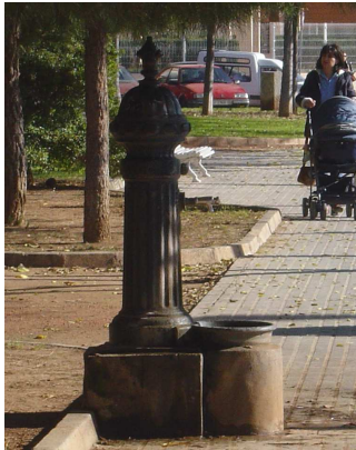
Imagen 6. Fuentes de fundición con distintos elementos de accionamiento, cubetas y rejillas de evacuación del agua.
