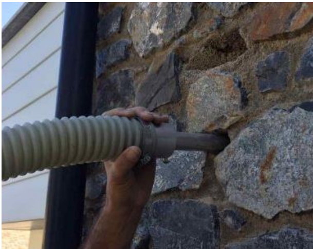
Figura 4.26 Momento de insuflado de aislante de celulosa Imagen de ecospai.com
