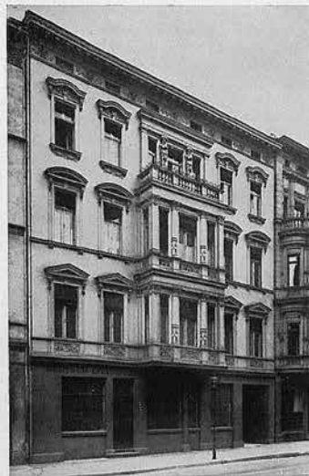
Das Gebäude vor dem Umbau
