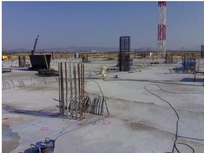
Fig. 3.107 Imagen de una de las losas postesas en el Aeropuerto de Murcia.
