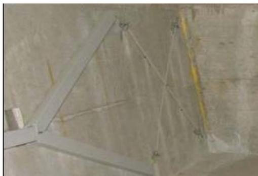
Fig. 2. 12 Sensores cruzados en apoyos para control del cortante. (Glisic et al. 2007)
