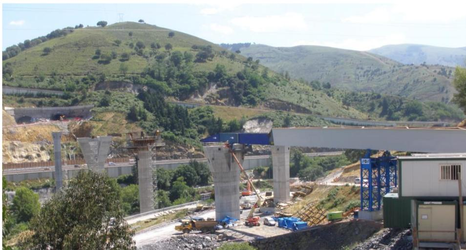
Fig. 3.118 Vista del cajón metálico que formará la variante Sur Metropolitana de Bilbao.
