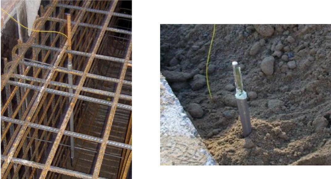
Fig. 3.113 Imágenes de los sensores ópticos instalados en el interior del encepado (a) y encargado de medir la temperatura ambiente (3).
