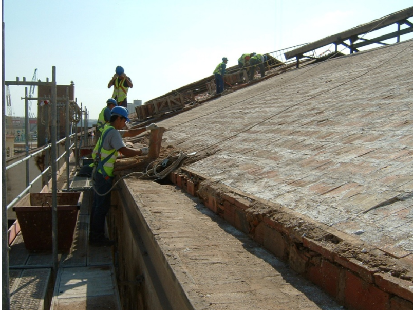
15.- Retirada y limpieza de las tejas curvas cerámicas.
