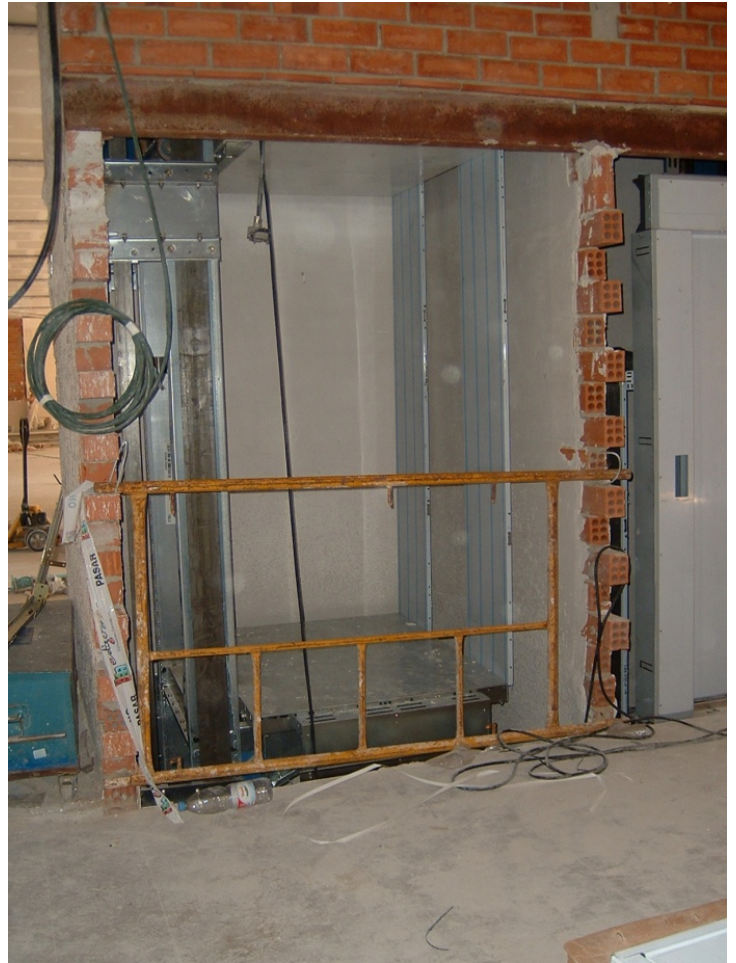
137.- Instalación de los ascensores.
