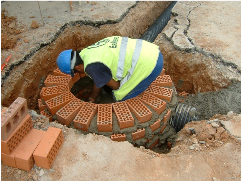
158.- Ejecución de las arquetas de la red de desagüe de aguas pluviales.
