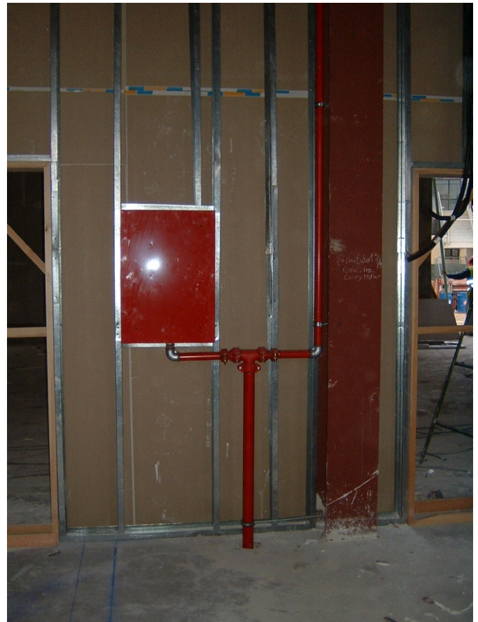
116.- Instalación de tubería y boca de incendio equipada embebida en la tabiquería.
