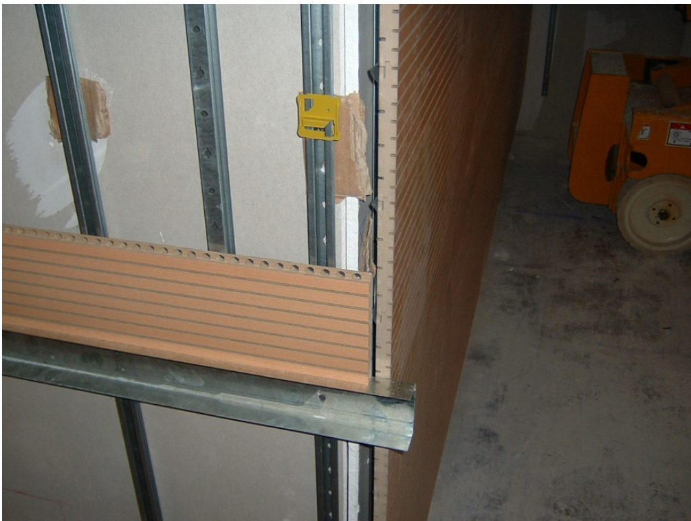
118.- Colocación del revestimiento de madera en el salón de actos sobre la tabiquería.
