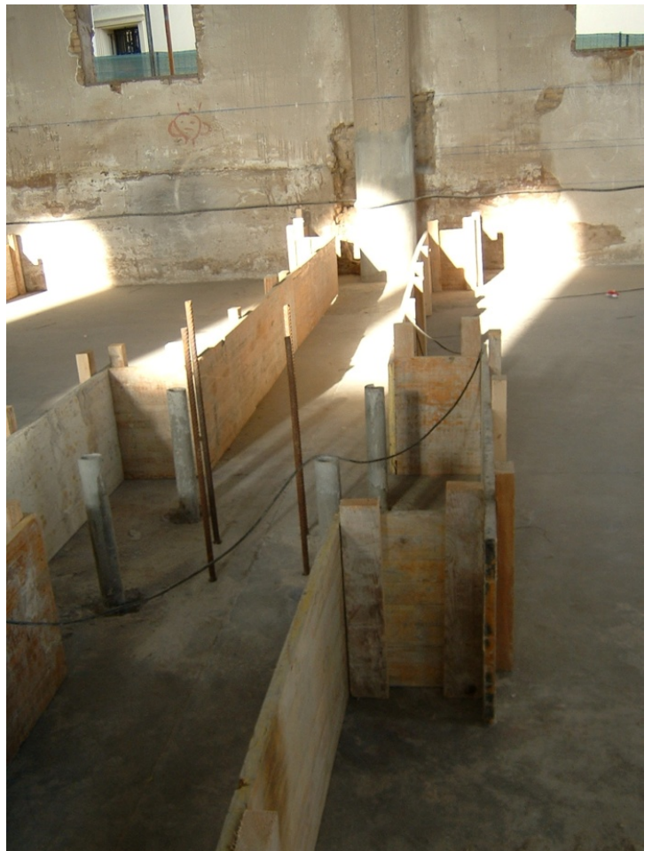
9.- Encofrado de zapatas y riostras de la nueva estructura.
