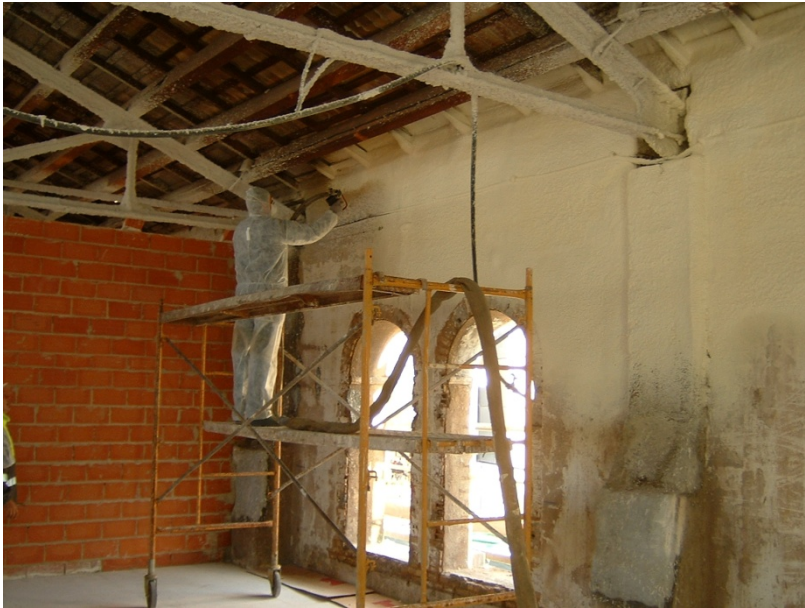
72.- Proyectado de poliuretano en el intradós de la fachada.
