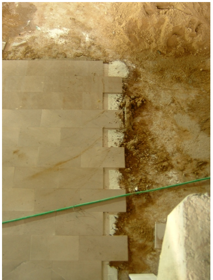
56.- Colocación de las baldosas de mármol a diente de sierra.
