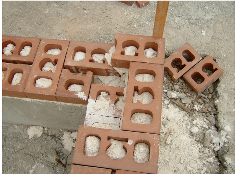
69.- Detalle del encuentro en esquina de la fábrica de ladrillo caravista.
