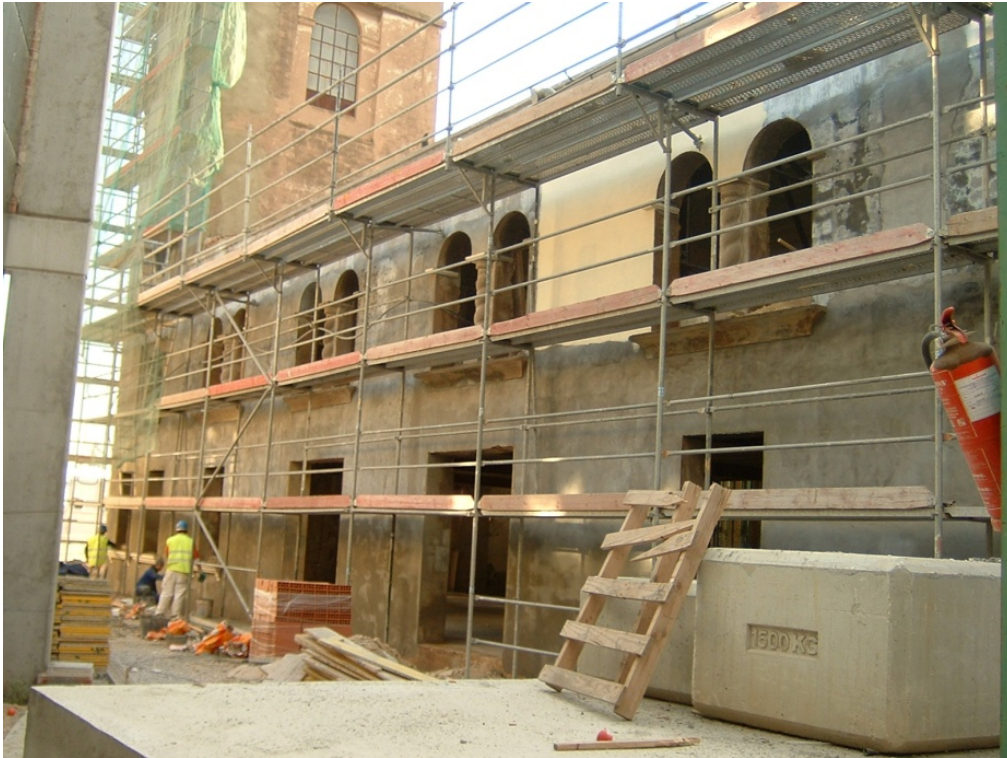
59.- Pintado de la fachada sobre el enfoscado maestreado mediante pintura al silicato.
