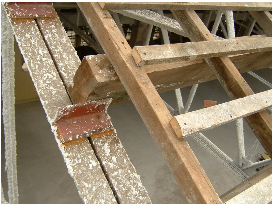
78.- Detalle del entramado de madera de la cubierta y del empleo de ejiones metálicos en las cerchas para el apoyo de las correas.
