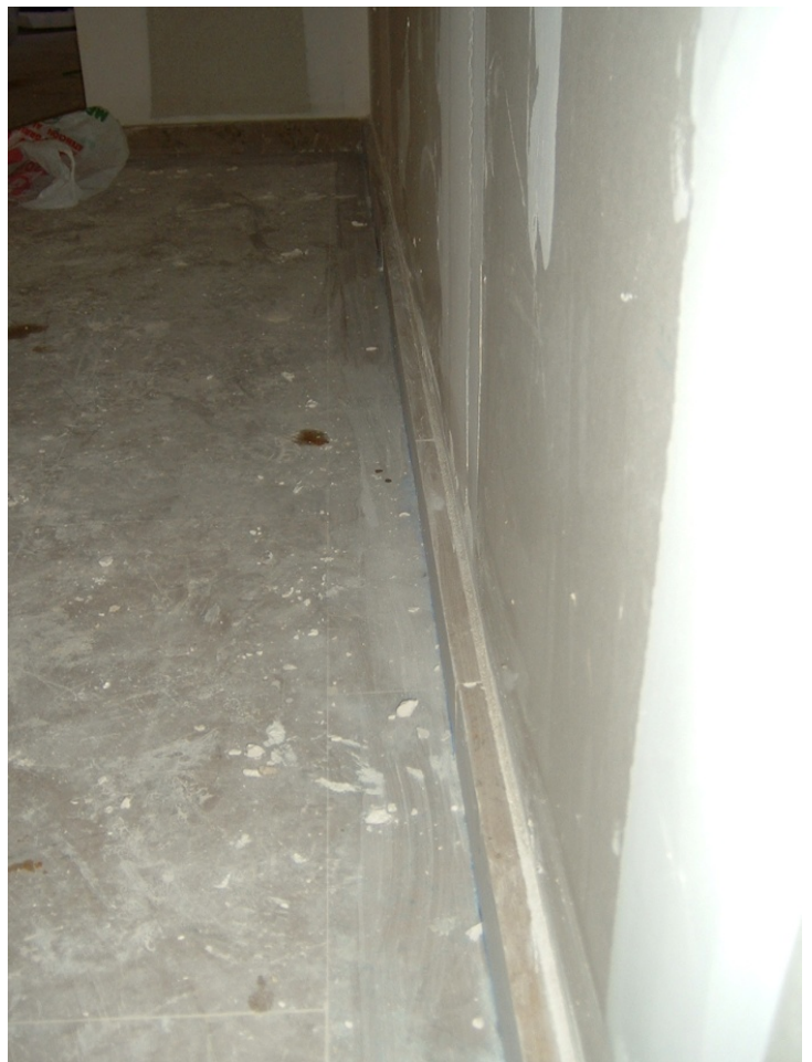
140.- Colocación de rodapiés de mármol.
