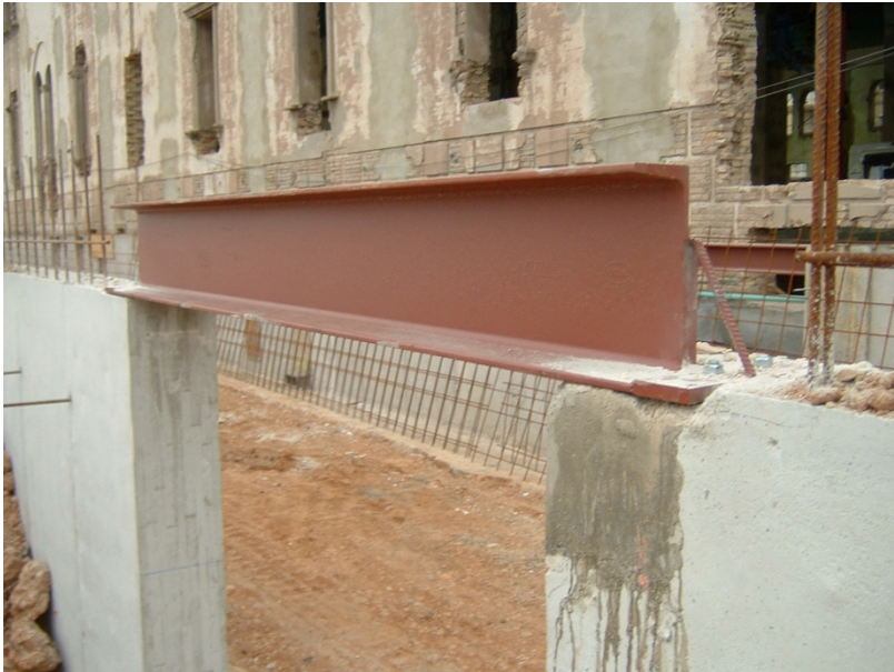
21.- Fijación de los dinteles de los huecos de los muros exteriores.
