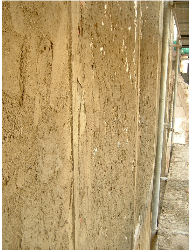
33.- Maestreado del enfoscado de la fachada.
