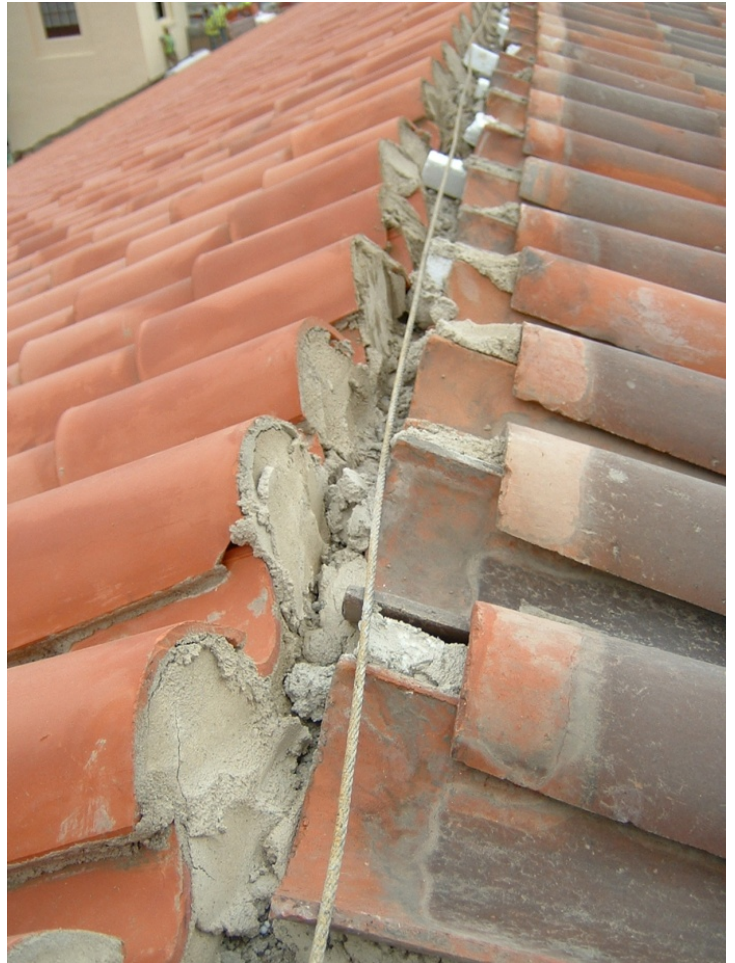
117.- Encuentro de dos faldones del tejado en la cumbre.
