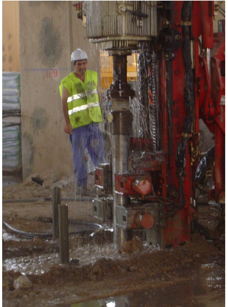
6.- Ejecución de micropilotes con armadura de tubo.
