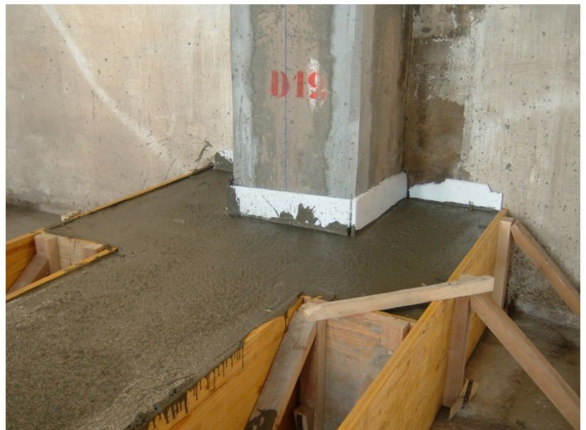
10.- Hormigonado de la cimentación y colocación de basas para la estructura metálica.
