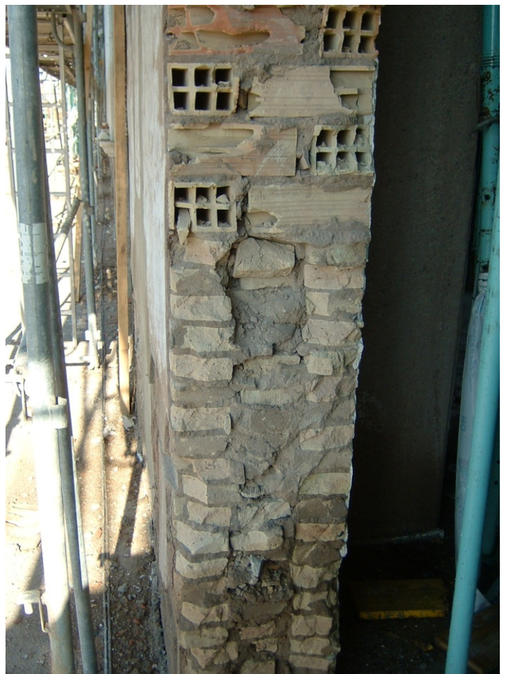
62.- Sección del muro de fachada tras la apertura de un hueco en la misma.
