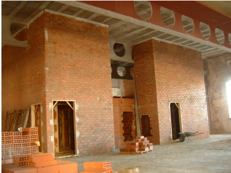
86.- Ejecución de la tabiquería de los núcleos de aseo en planta baja mediante fábrica de ladrillo perforado.
