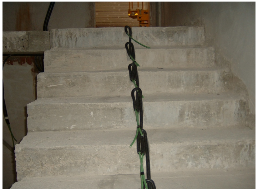
150.- Instalación del cableado para la alimentación de las balizas de los escalones.
