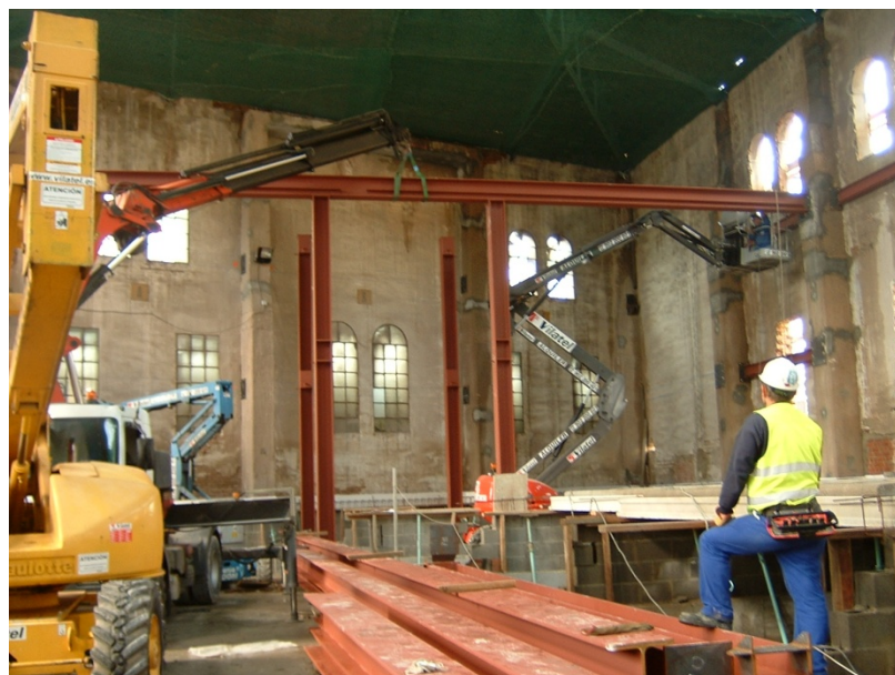
Figura 5.13 – Colocación de viga continua sobre pilares.
