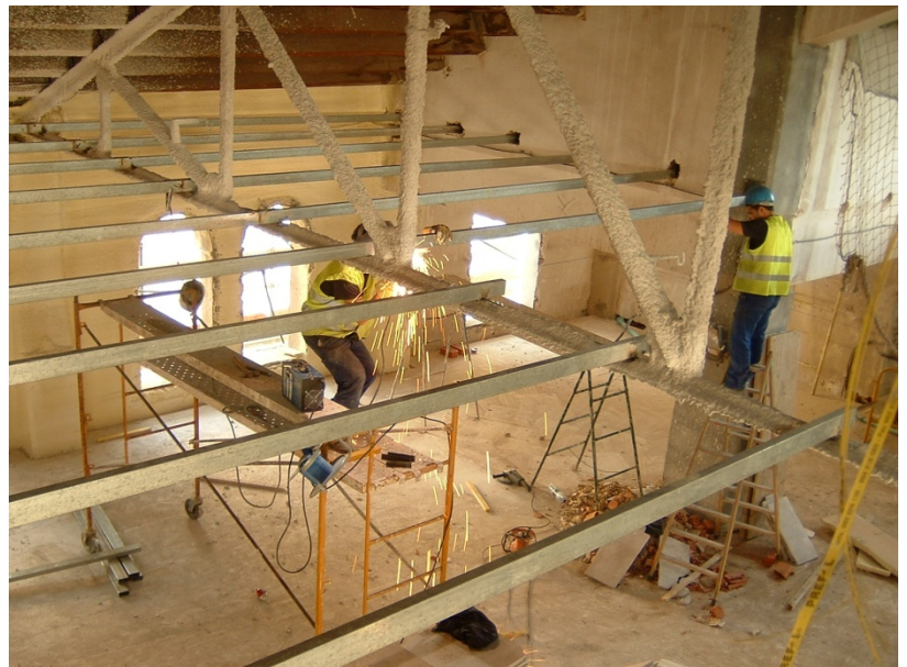
84.- Colocación de la perfilera metálica de soporte al falso techo mediante soldado a las cerchas de cubierta.
