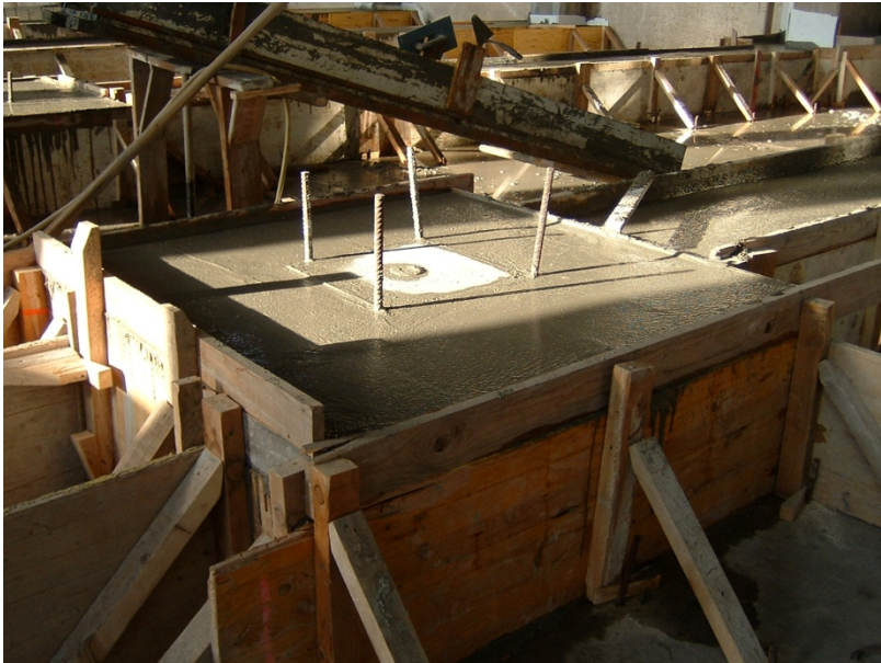
10.- Hormigonado de la cimentación y colocación de basas para la estructura metálica.
