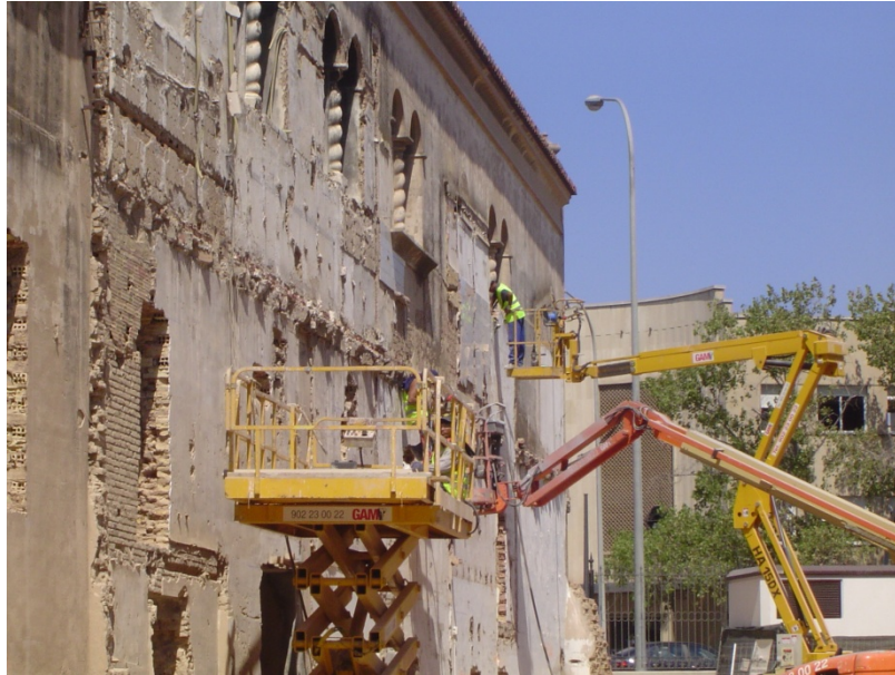
Figura 5.5 – Retirada de la carpintería empleando plataformas elevadoras.
