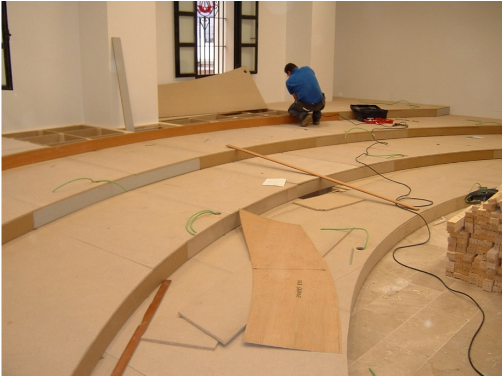
184.- Ejecución del entarimado para las gradas de las aulas de formación.
