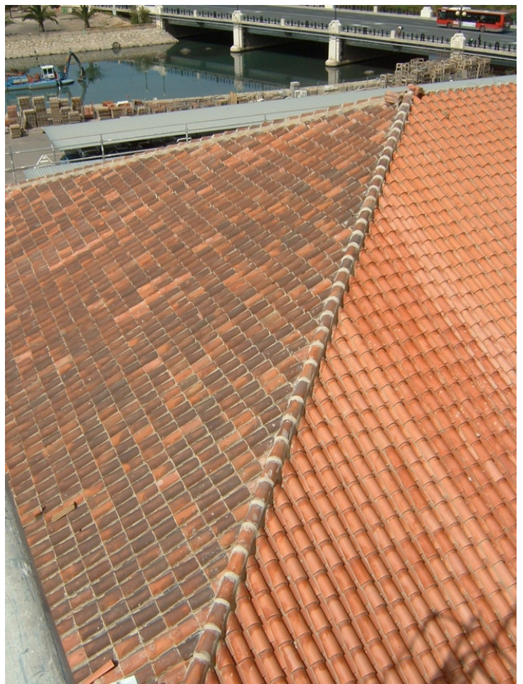
128.- Limatesa del tejado ejecutada con teja curva cerámica.
