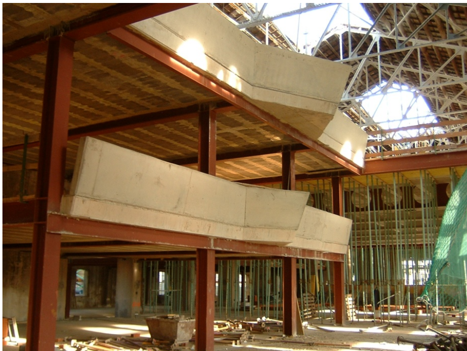
80.- Antepecho de hormigón armado visto en el vestíbulo de entrada.
