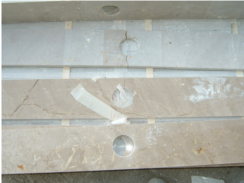
149.- Tabicas de mármol con perforación en su centro para la instalación de luminarias de baliza.
