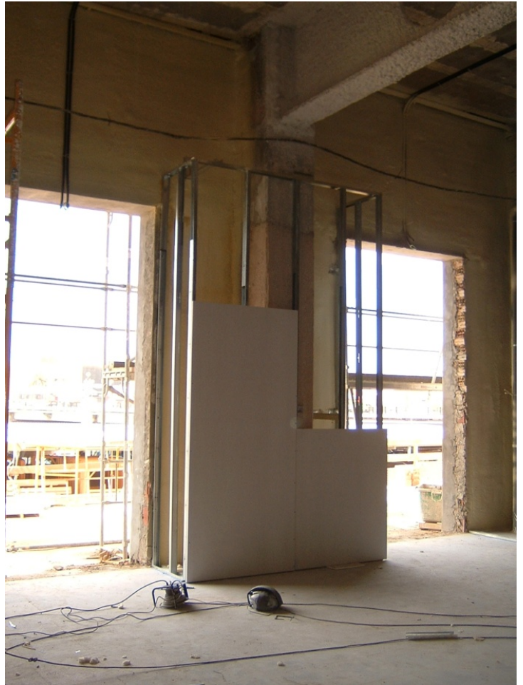
111.- Trasdosado de la fachada en el salón de actos ocultando la estructura existente.
