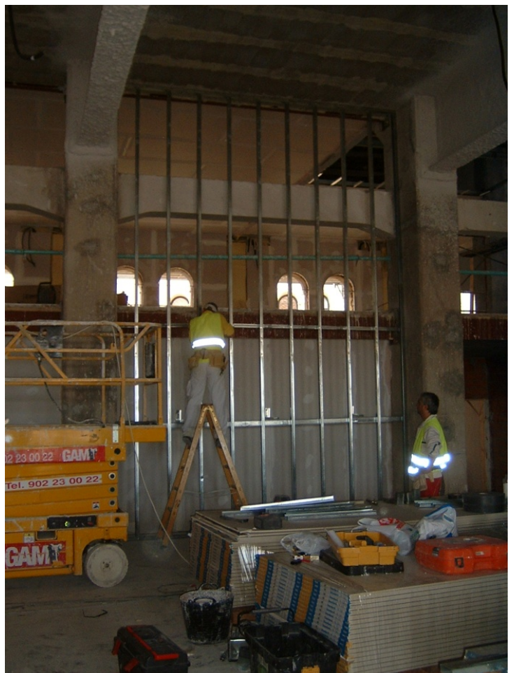
110.- Ejecución de la tabiquería del salón de actos.
