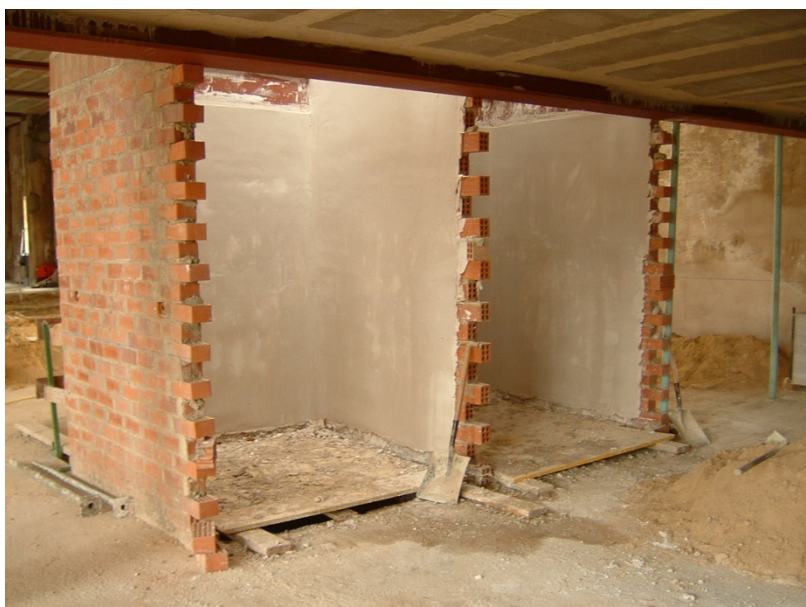
87.- Recercado de las ventanas mediante una rosca de ladrillo para el falcado de los premarcos.
