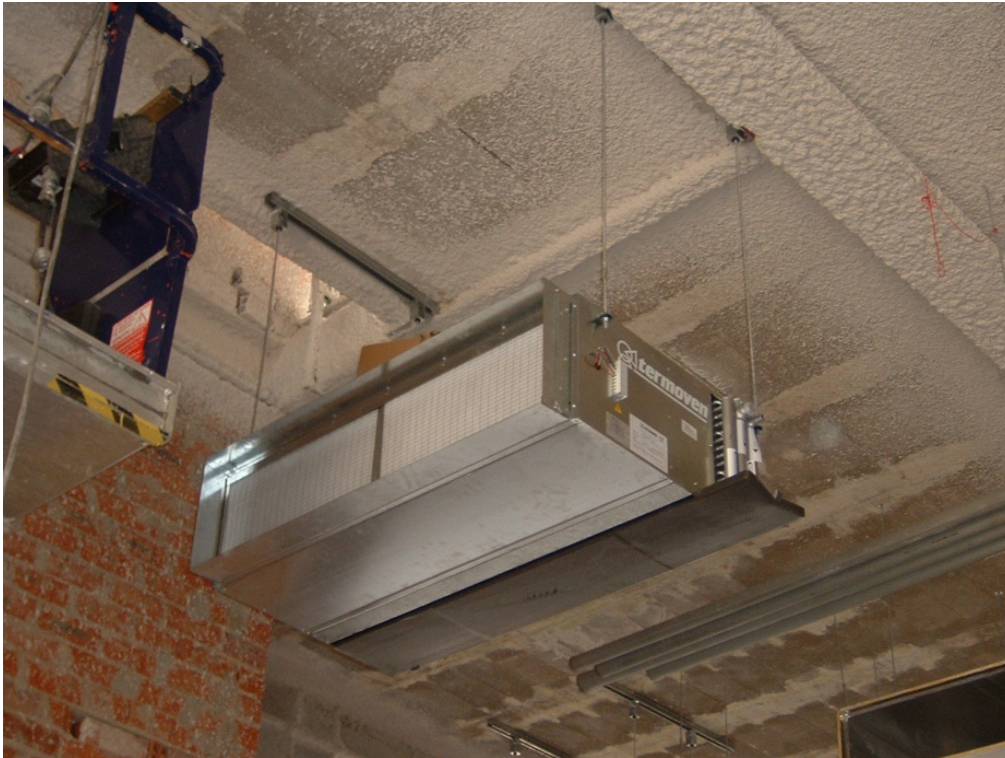
113.- Colocación de las unidades climatizadoras mediante varillas roscada de acero sustentadas de la estructura metálica y a los nervios del forjado.
