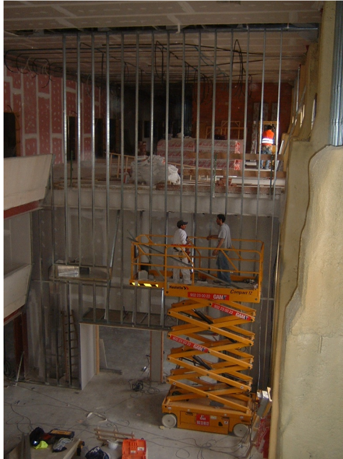
Figura 5.25 – Ejecución de tabique de 10,35m. de
