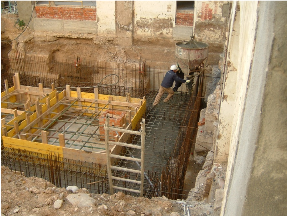
81.- Hormigonado de la cimentación de los muros de sótano.
