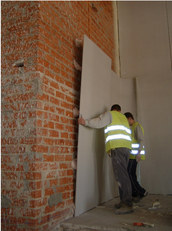
115.- Trasdoso directo con placas de cartón yeso sobre la tabiquería de ladrillo.
