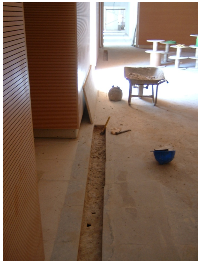
148.- Apertura de rozas en el pavimento del salón de actos para la instalación de luminarias.
