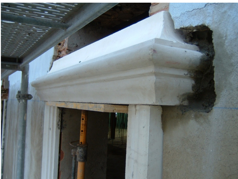
64.- Empleo de viguetas prefabricadas de hormigón para la formación de dinteles en los huecos de fachada.
