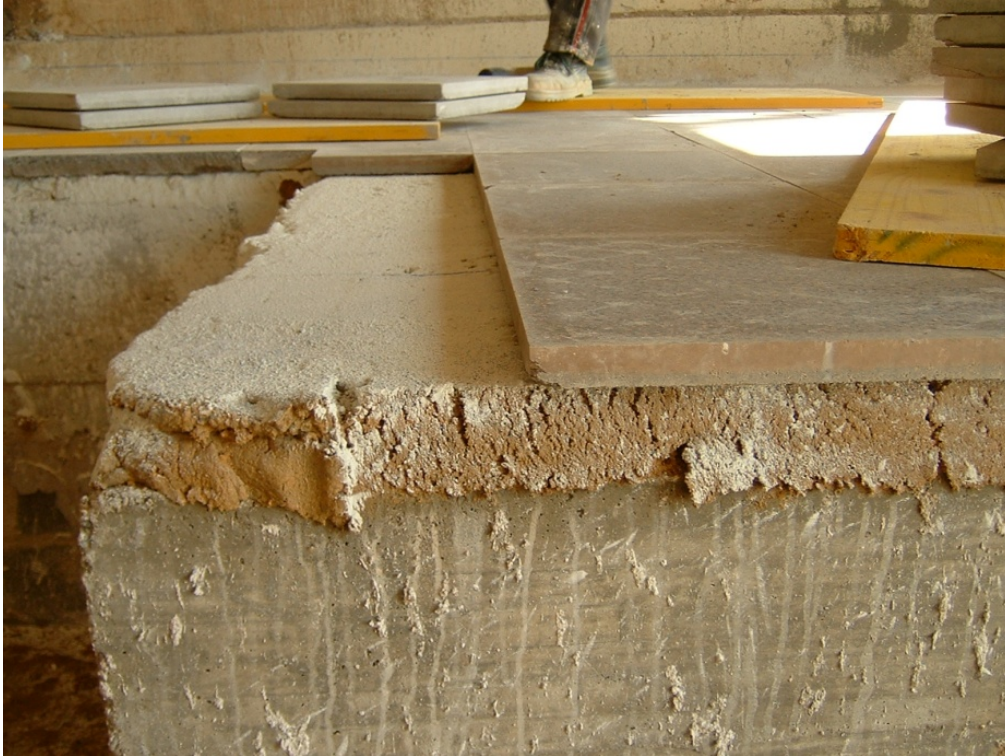
91.- Detalle de la colocación del terrazo sobre el escenario del salón de actos como soporte del parquet.
