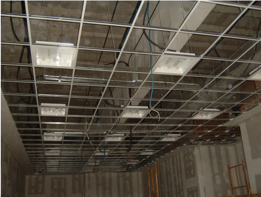
141.- Instalación de luminarias en los falsos techos.
