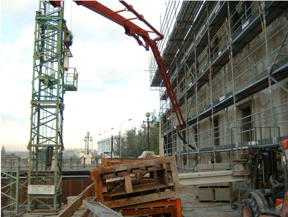
31.- Bombeado del hormigón a través de los huecos de fachada para la ejecución de los forjados interiores.
