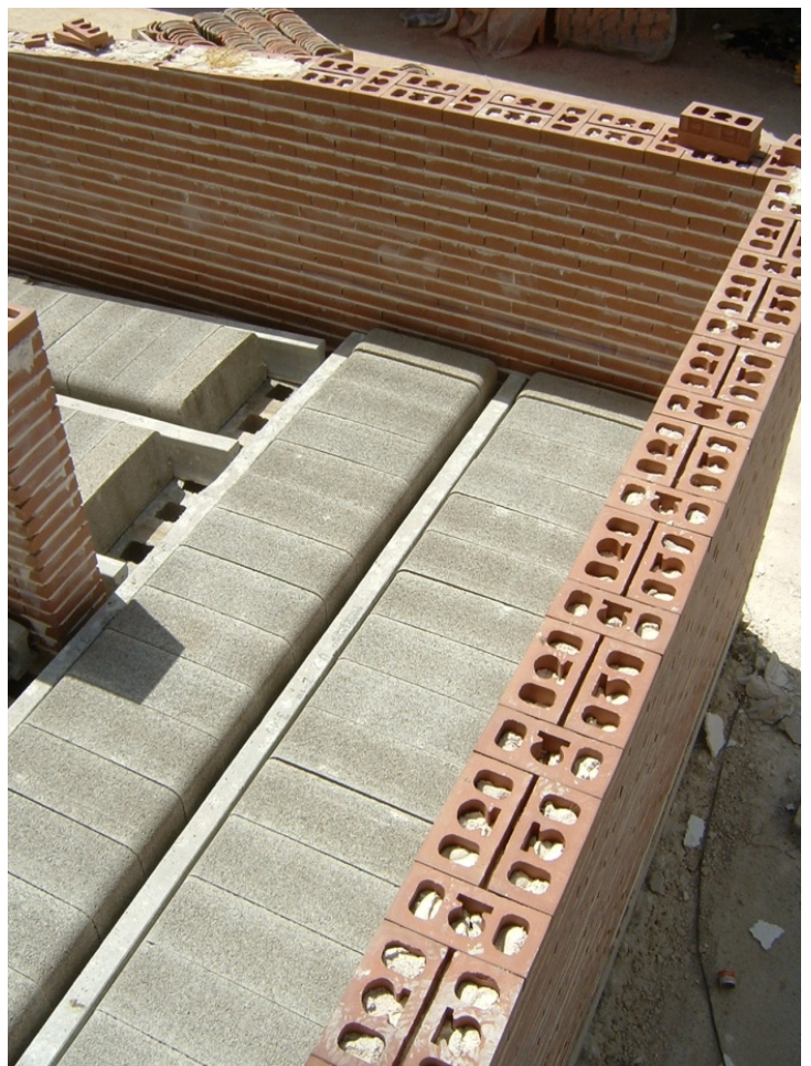
122.- Ejecución del forjado para las de acceso al edificio.
