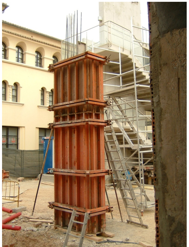
58.- Encofrado de los pilares de hormigón visto de la estructura de la pasarela.
