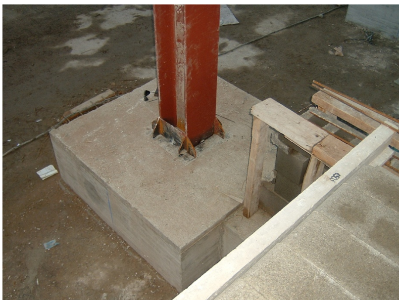
25.- Armado de la plataforma exterior de entrada realizada con placa alveolar prefabricada.
