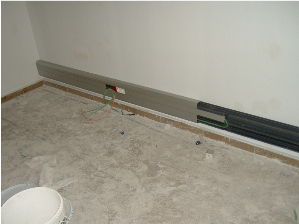
152.- Instalación de las tomas de corriente y de datos en los rodapiés metálicos.
