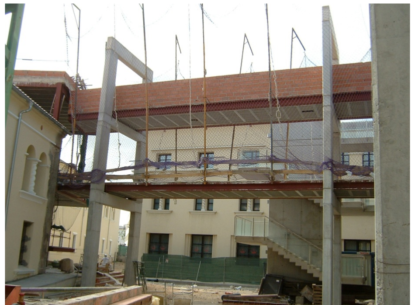
171.- Instalación de bandeja de rejilla de acero para el paso de las instalaciones eléctricas del Centro de Proceso de Datos.
