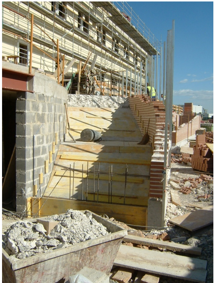
101.- Encofrado de las escaleras exteriores de acceso al edificio.
