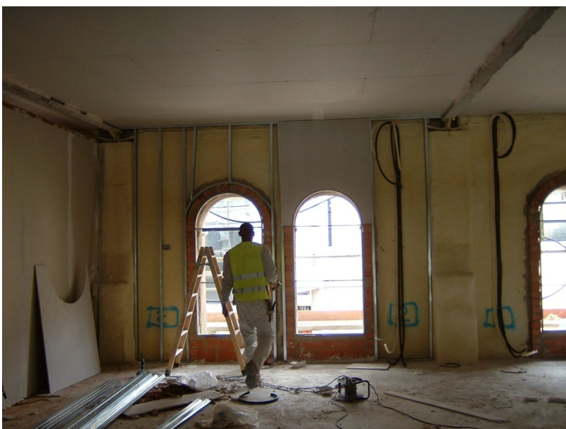
103.- Impermeabilización del trasdós del muro de sótano mediante poliuretano.
