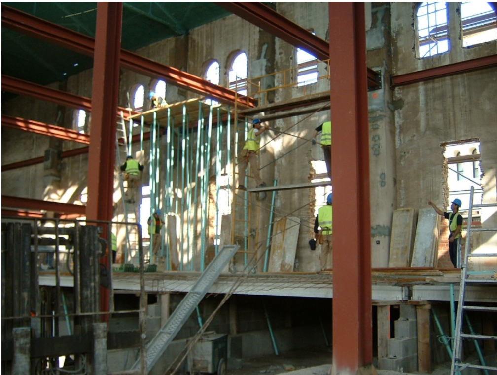
27.- Encofrado del forjado de planta primera.
