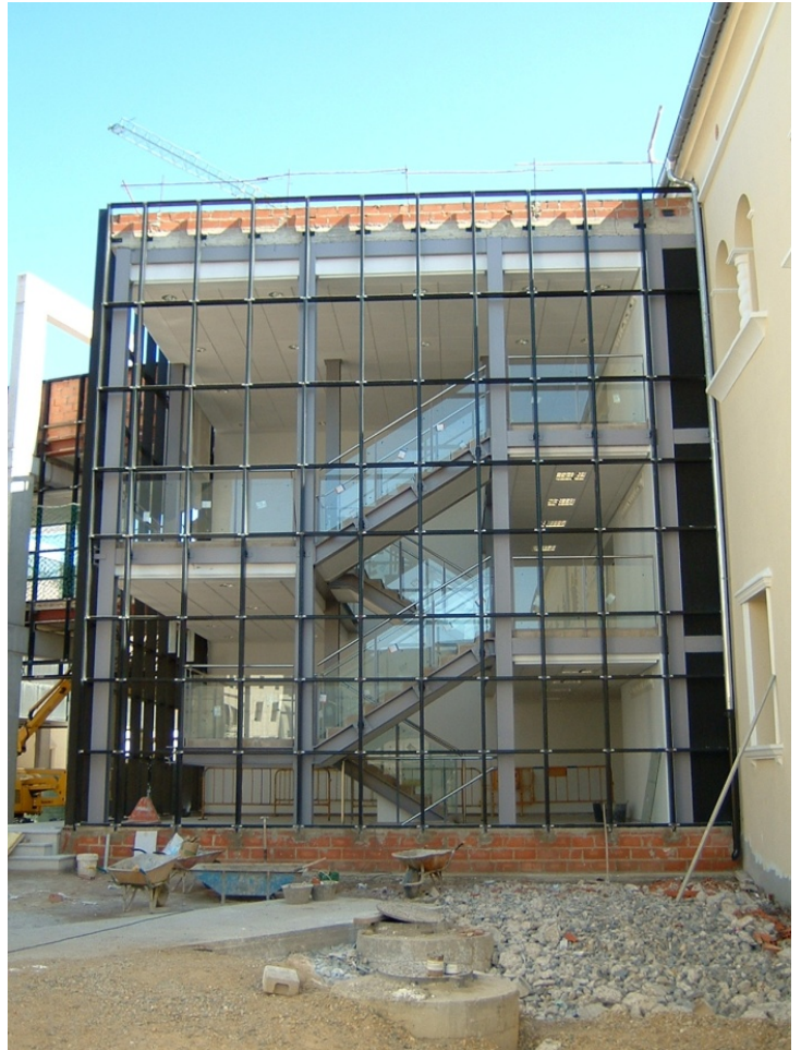
182.- Ejecución del muro cortina que reviste la escalera exterior.
