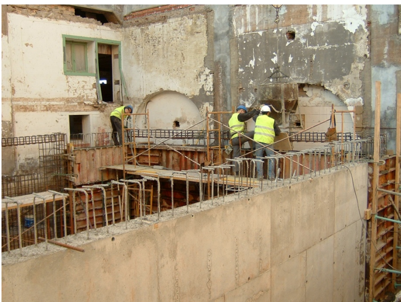
85.- Hormigonado de los muros de sótano.
