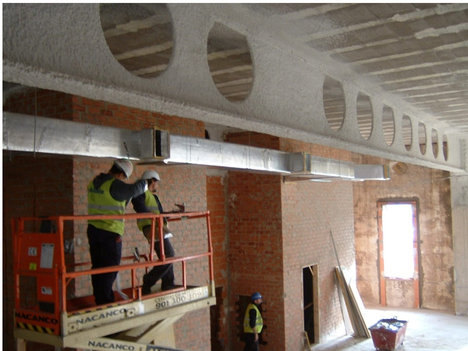
106.- Colocación de conductos de impulsión y retorno de aire acondicionado.
