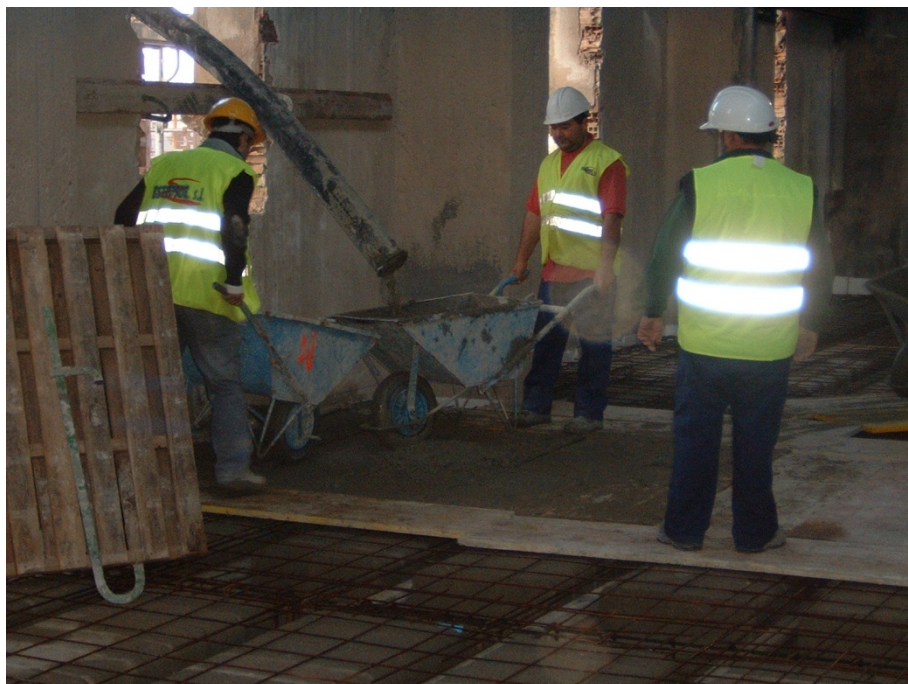
Figura 5.17 – Hormigonado del forjado de planta baja.
