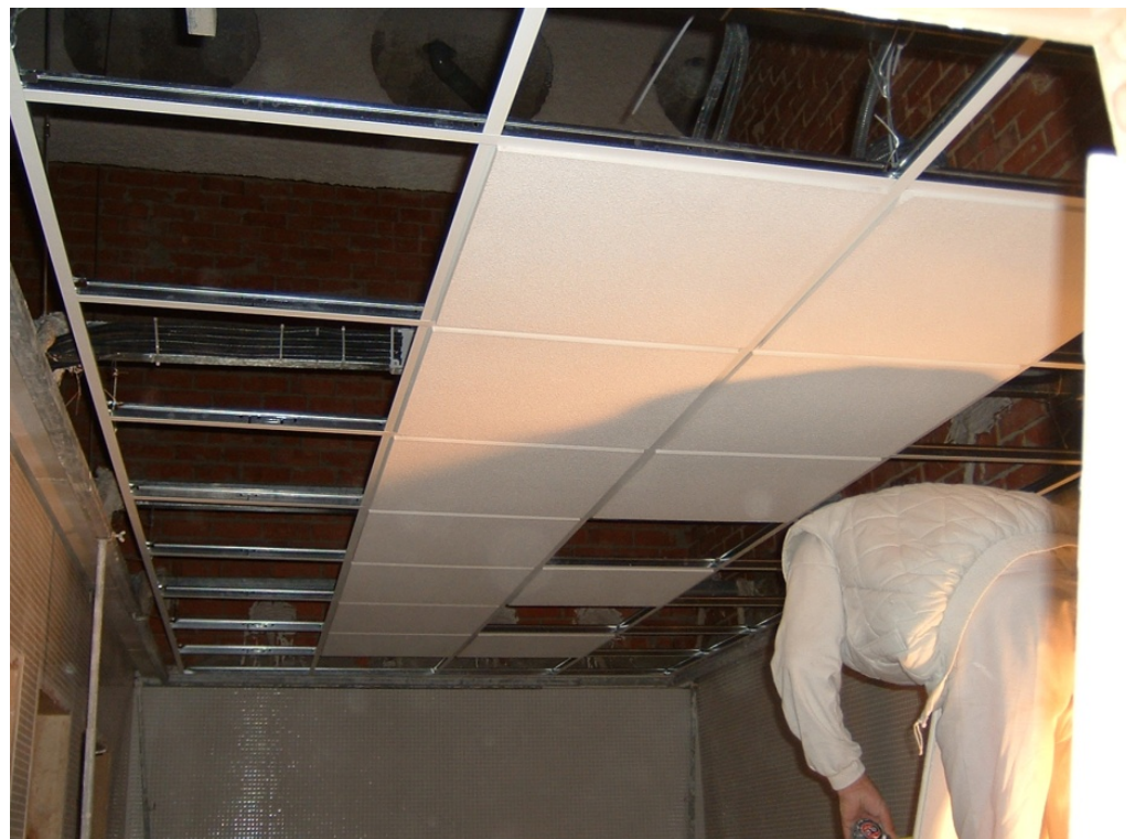
130.- Ejecución de falsos techos desmontables de escayola con perfilera semioculta.
