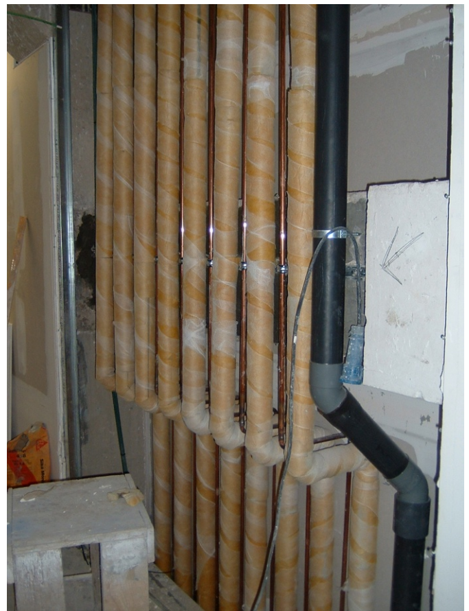
157.- Instalación de las tuberías de alimentación al sistema climatización del Centro de Proceso de Datos a través de un patinillo de instalaciones.
