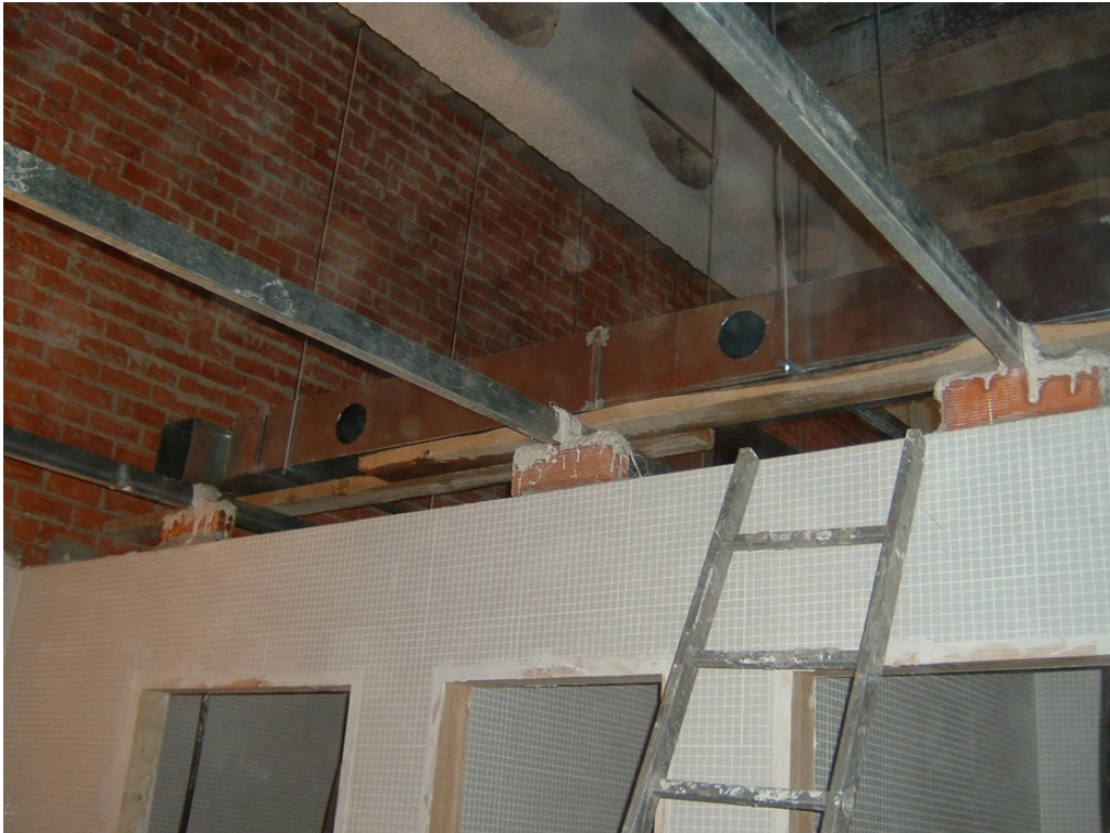
129.- Colocación de perfiles metálicos sobre la tabiquería de los aseos para la ejecución del falso techo.
