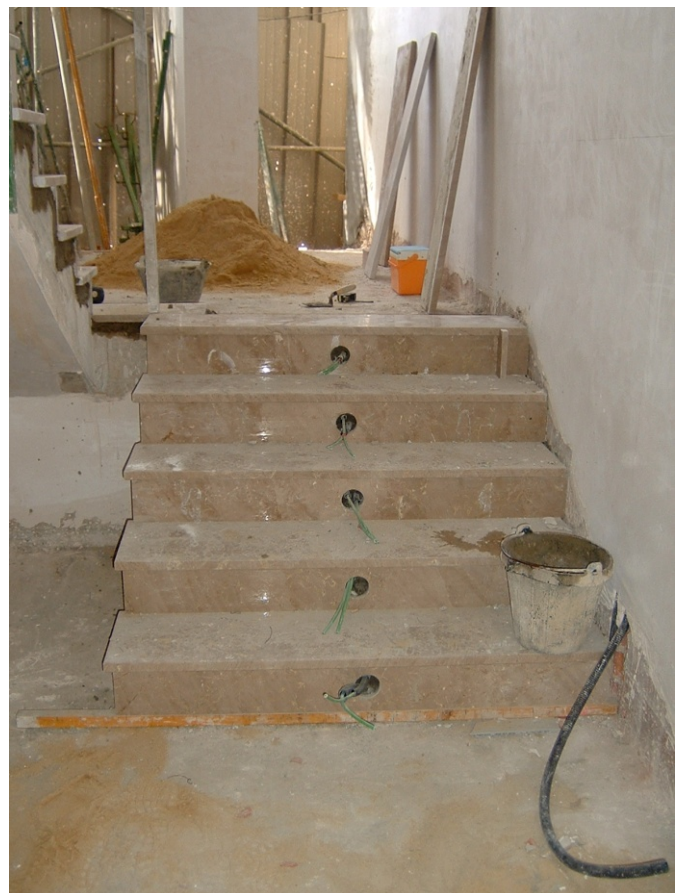
153.- Revestimiento de mármol de los peldaños de las escaleras.
