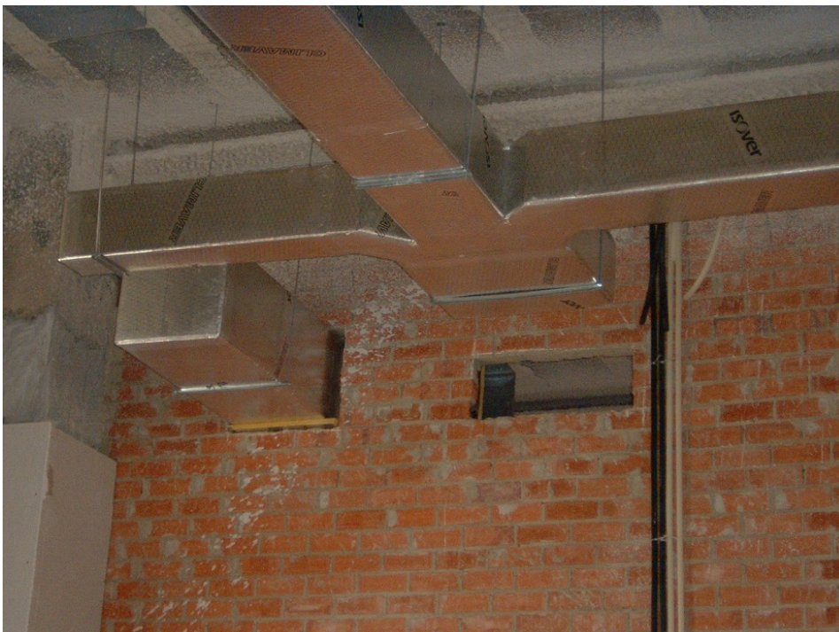
112.- Paso de los conductos de impulsión y retorno de aire de la climatización a través de la tabiquería de ladrillo.
