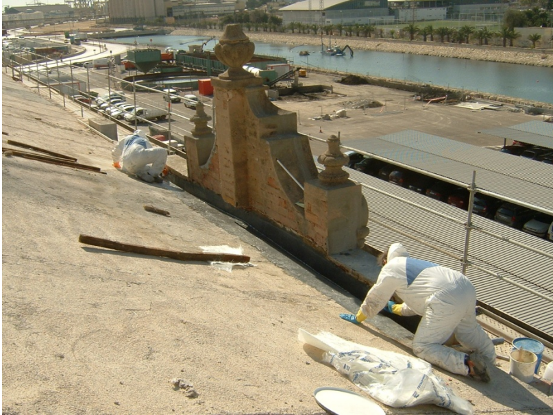
83.- Ejecución del canalón oculto del tejado tras la espadaña mediante resina de poliéster y fibra de vidrio.
