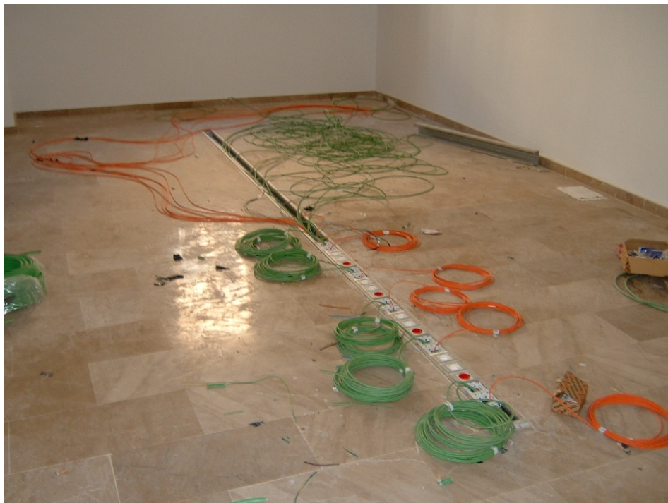
179.- Instalación de tomas de corriente y de datos en el suelo para las aulas de informática.
