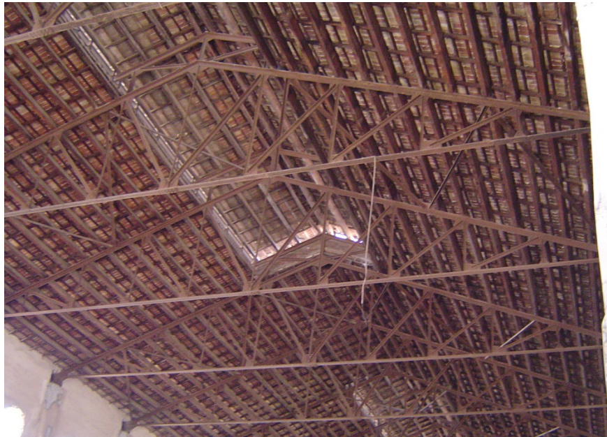
Figura 2.2 – Vista desde el interior del sistema de cubierta.
