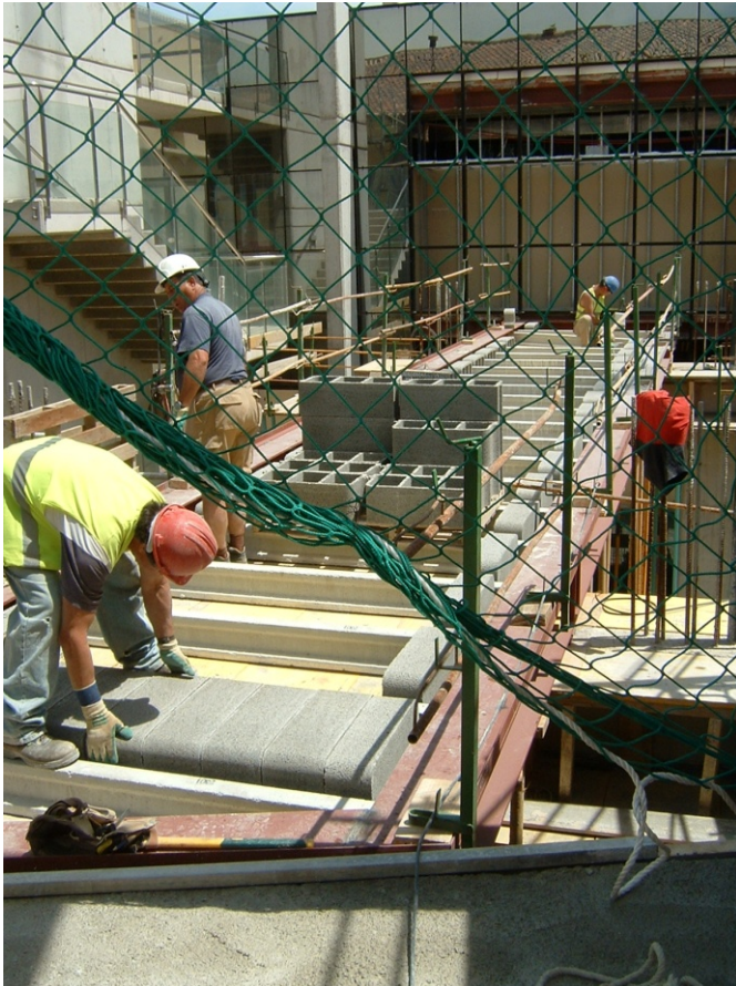
147.- Ejecución del forjado de la pasarela de conexión.
