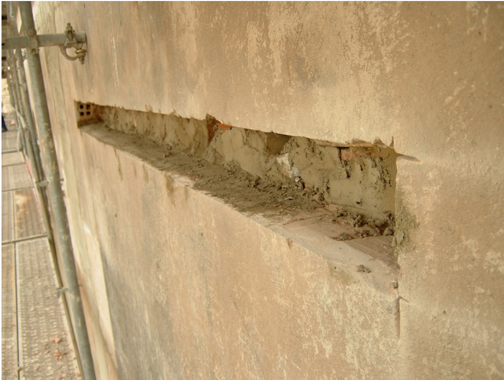
37.- Ejecución de rozas en la fachada para la colocación de dinteles que aseguren la apertura de nuevos huecos.
