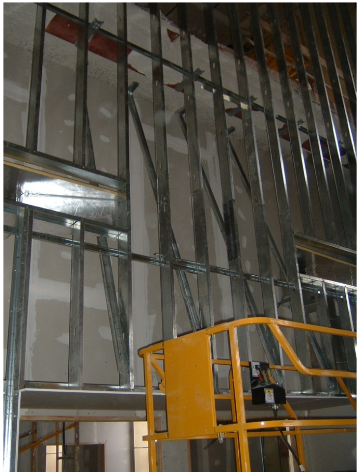
126.- Refuerzo mediante tirantes de perfil de acero de los dinteles de las puertas del vestíbulo.
