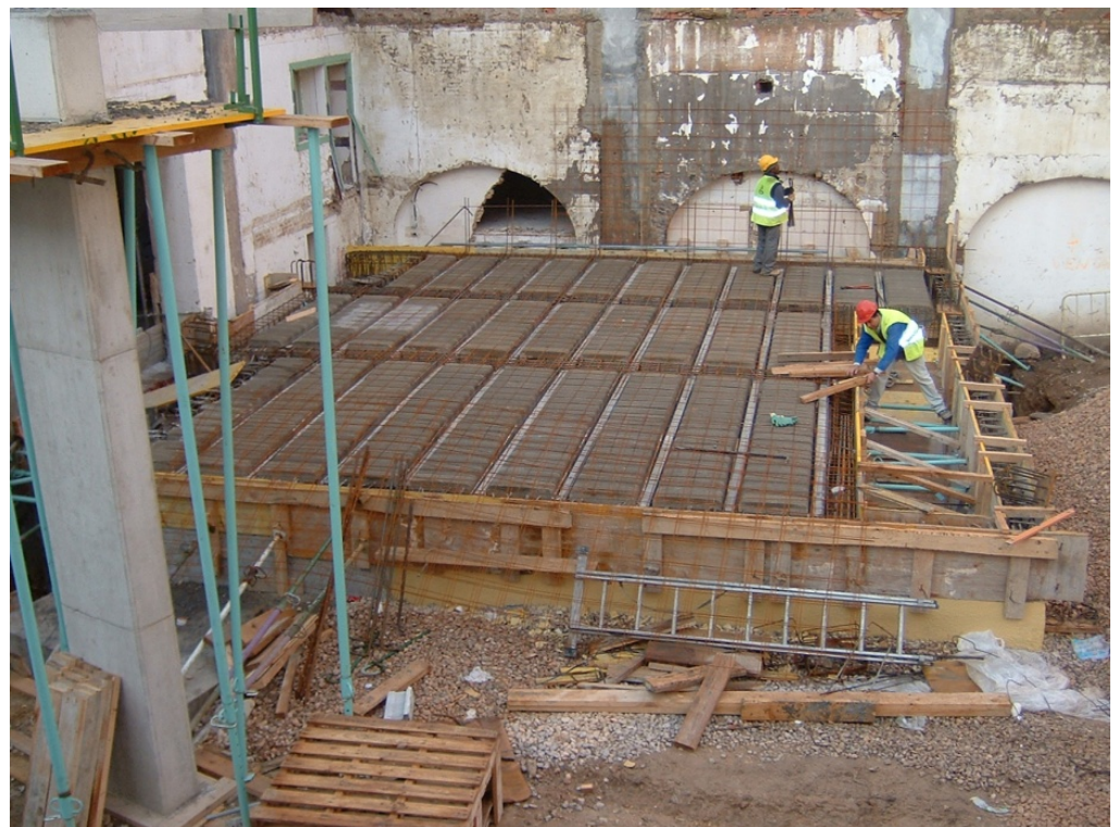
114.- Ejecución del forjado de planta baja sobre el sótano.
