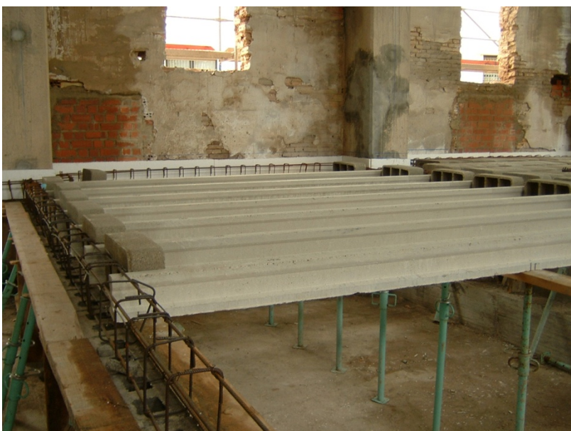
22.- Hormigonado de la solera para la sala de máquinas.
