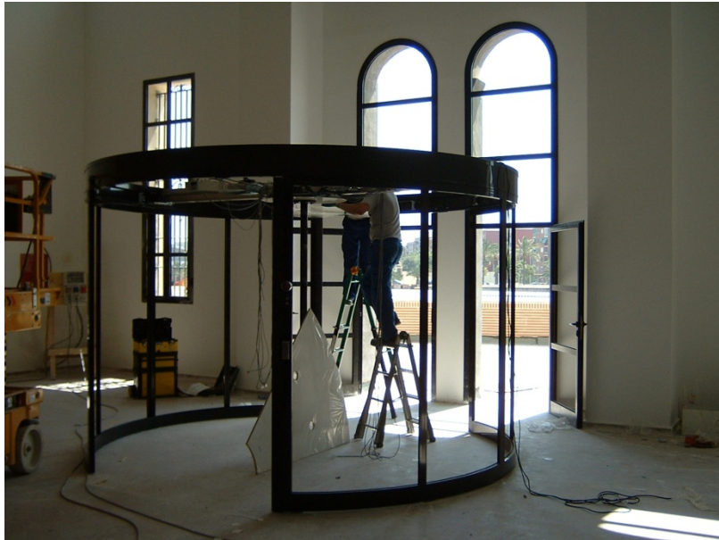
166.- Instalación de la puerta giratoria de entrada en el vestíbulo del edificio.
