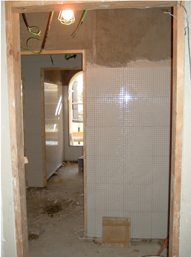
143.- Ejecución del alicatado cerámico de los núcleos de aseos.
