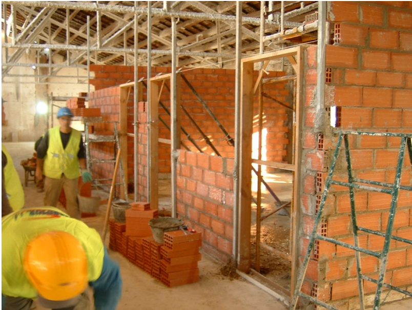
66.- Ejecución de la tabiquería de ladrillo hueco en los núcleos de aseos.
