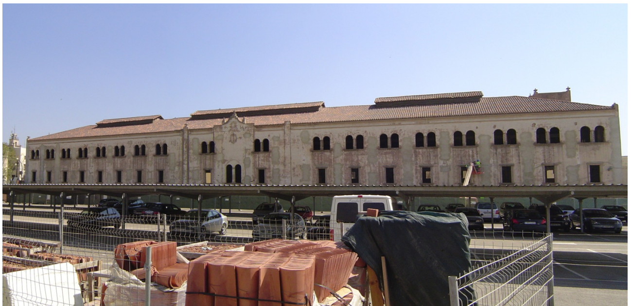
Figura 2.1 – Fachada principal de la nave al comienzo de la rehabilitación.
