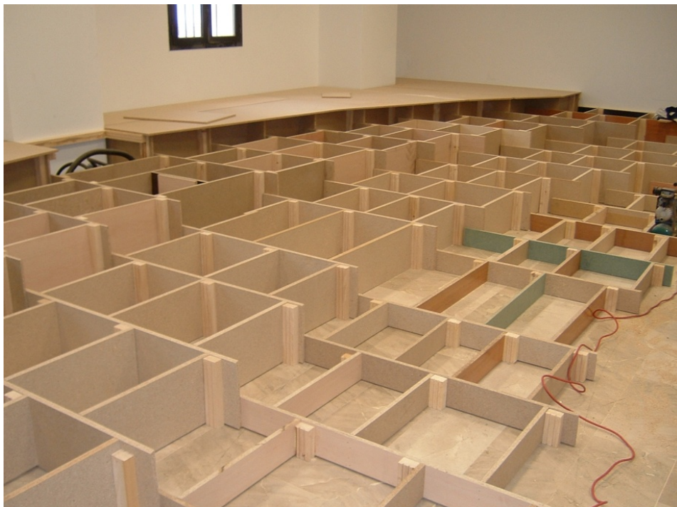
183.- Ejecución de la estructura de las gradas para las aulas de formación.
