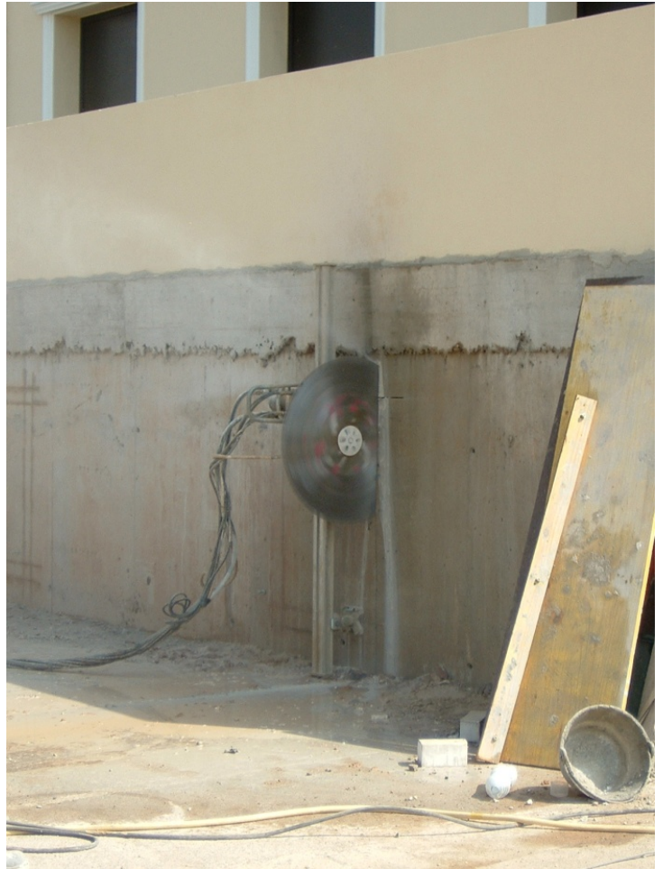
180.- Apertura de huecos en el muro de hormigón para la instalación de tomas de aire exterior de las climatizadoras.
