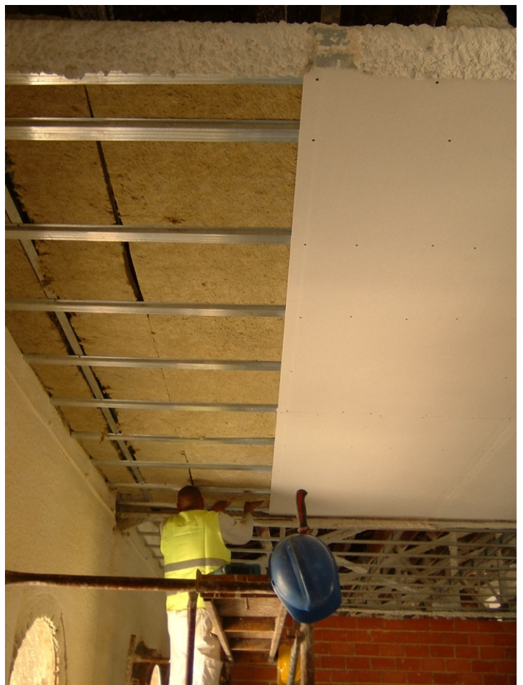
94.- Ejecución del falso techo entre las cerchas de cubierta mediante perfilera metálica, placa de cartón yeso y lana de roca.
