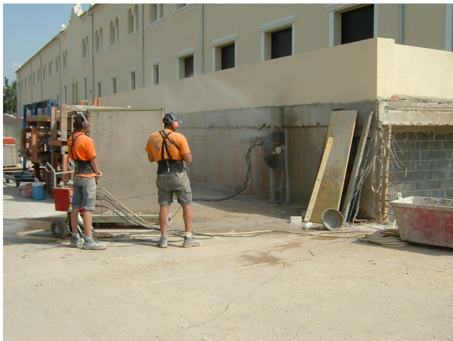
Figura 5.28 – Corte del muro de hormigón para los huecos de ventilación de la sala de máquinas.
