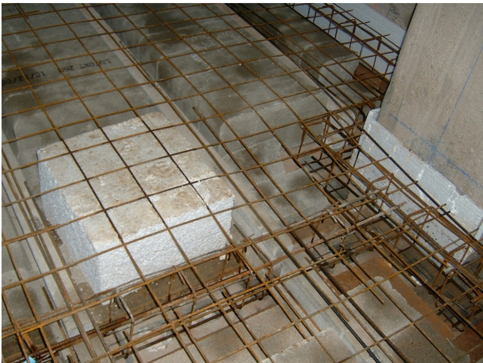
42.- Pieza de poliestireno embebida en el espesor del forjado para la formación de un hueco para el paso de instalaciones.
