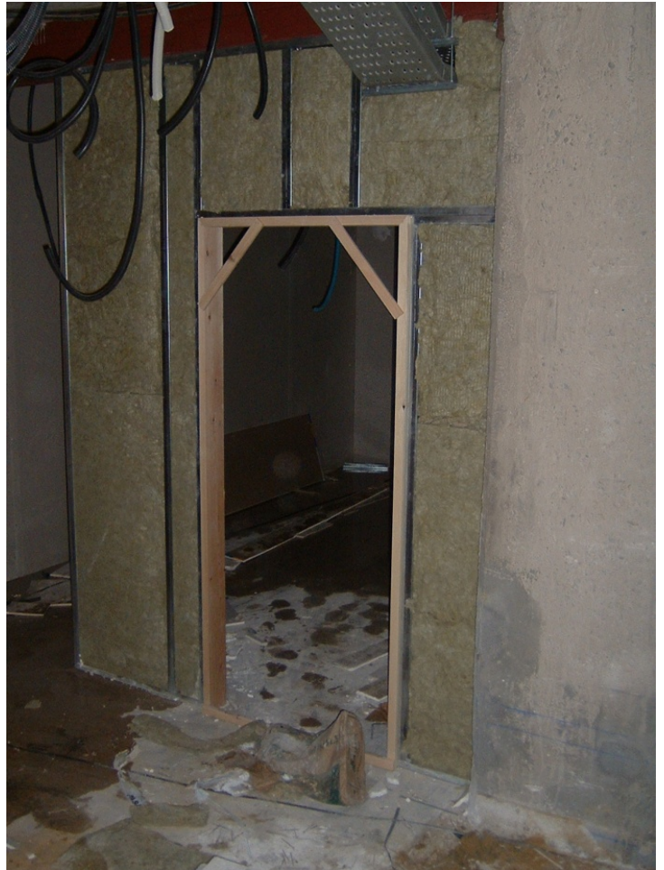
107.- Colocación de lana de roca en el interior de la tabiquería.
