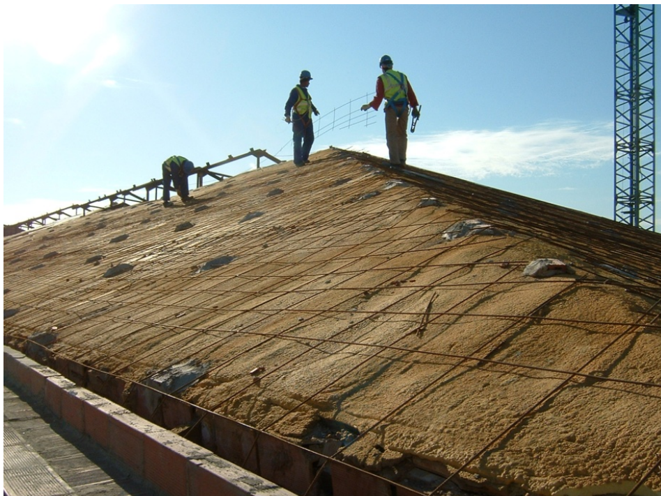
34.- Colocación de mallazo en la cubierta previo al hormigonado.
