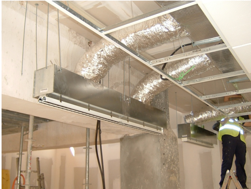
163.- Instalación de rejillas lineales de impulsión de aire acondicionado.
