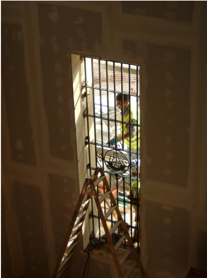
131.- Colocación de las rejas metálicas en los huecos de ventanas de planta baja.
