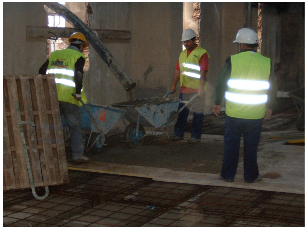
32.- Hormigonado con dificultad del forjado sanitario mediante carretillas, discurriendo sobre tableros de madera para no romper las bovedillas.
