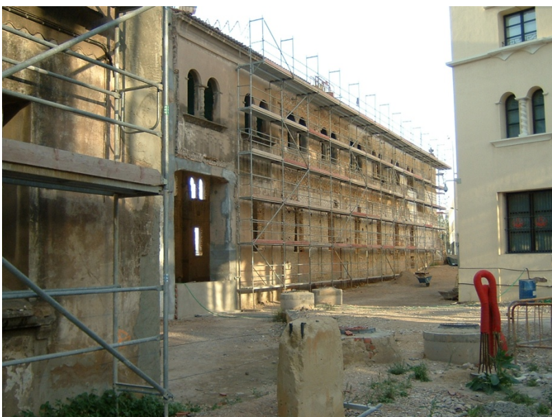
12.- Limpieza y picado de la fachada.
