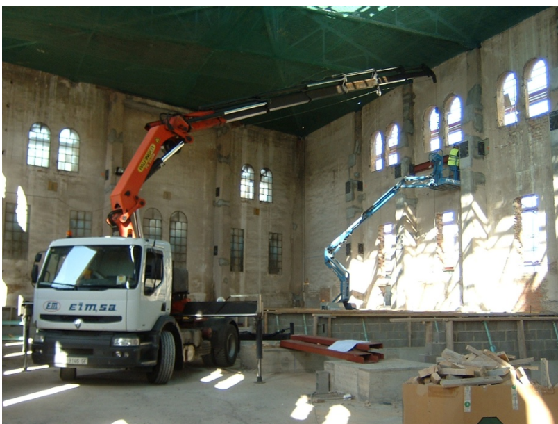
20.- Colocación de los zunchos metálicos de borde de la nueva estructura.
