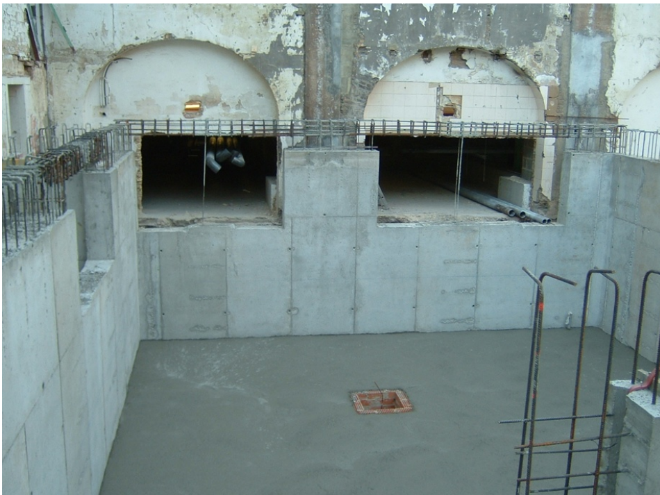
96.- Ejecución de la solera del sótano y de una arqueta de desagüe para el mismo.
