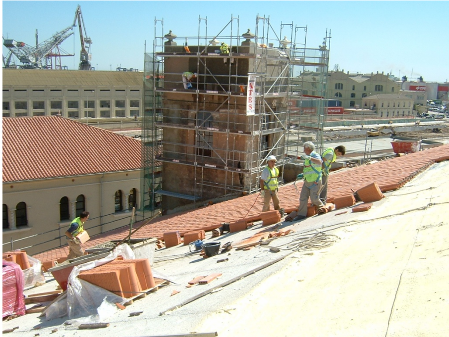
Figura 5.15 – Colocación de teja nueva en el faldón Este.
