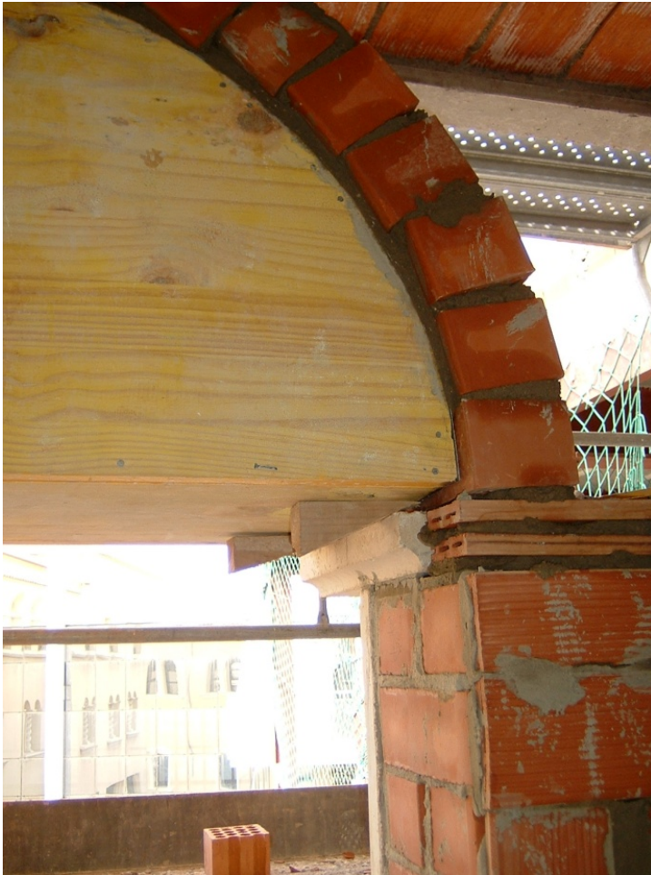
49.- Detalle de ejecución de un arco de medio punto mediante una rosca de ladrillo.
