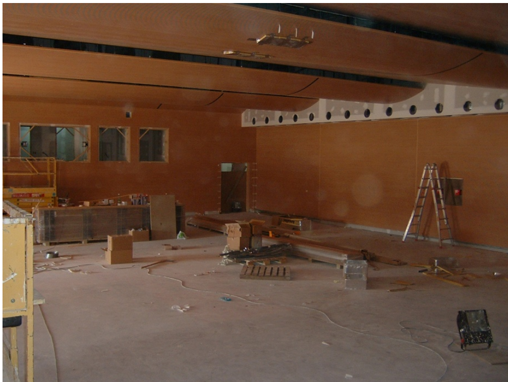
138.- Revestimiento de techos y tabiques del salón de actos.
