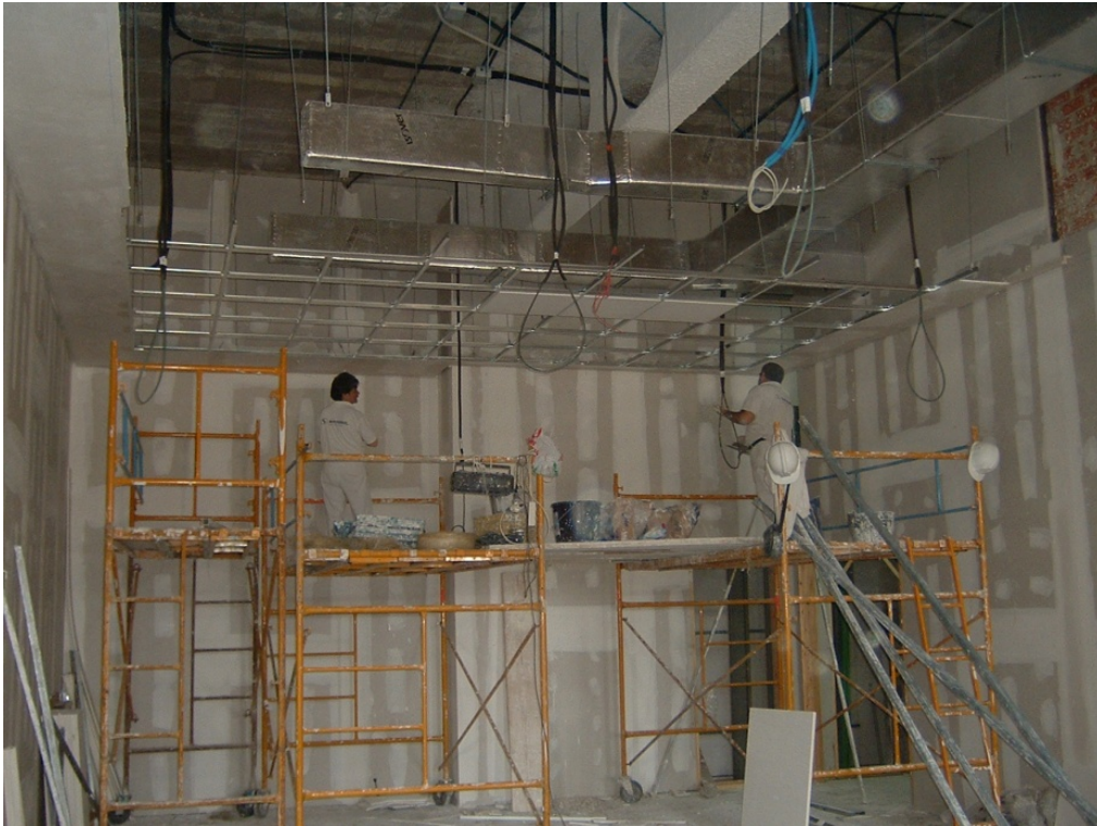
139.- Ejecución de falsos techos en la antesala al salón de actos.
