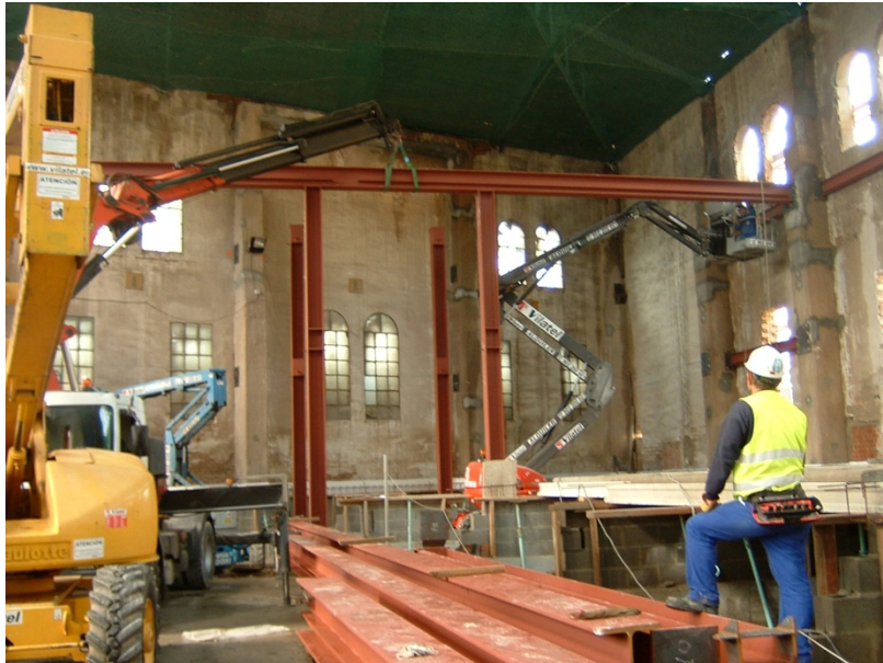
24.- Ejecución de la estructura metálica interior.
