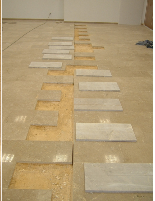
Figura 5.24 – Solución adoptada realizando la junta sobre las baldosas.
