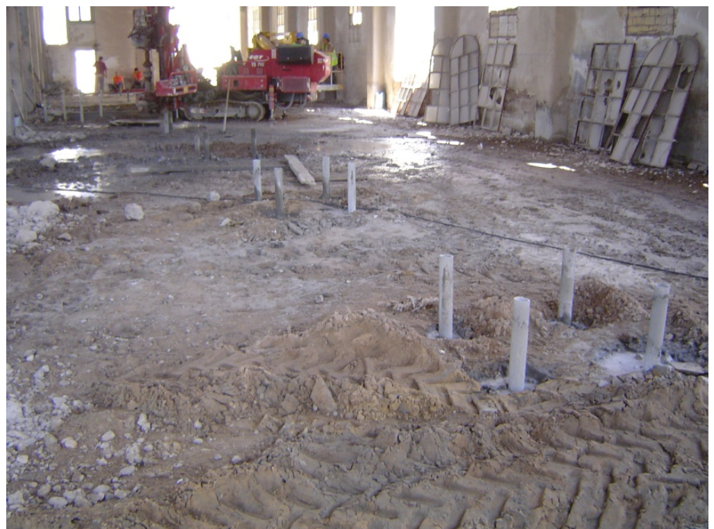
5.- Micropilotaje para el apoyo de la cimentación de la nueva estructura interior.
