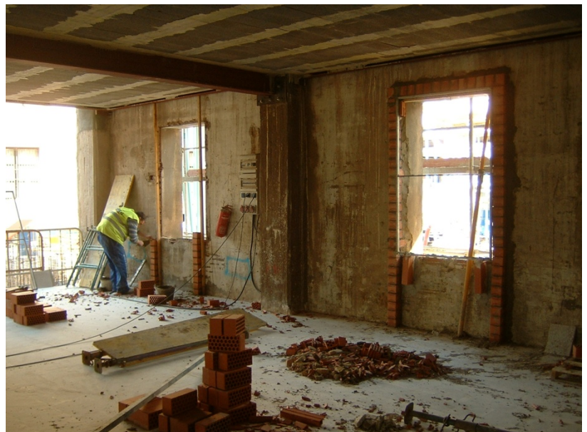
86.- Ejecución de la tabiquería de los núcleos de aseo en planta baja mediante fábrica de ladrillo perforado.
