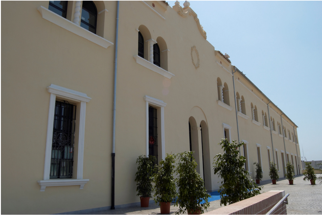
186.- Vista de la fachada una vez finalizada la obra.
