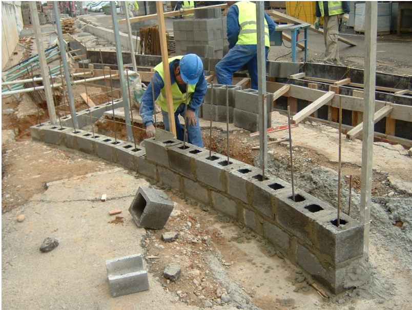
63.- Ejecución de muros de bloque de hormigón para la formación de las escaleras exteriores de acceso al edificio.
