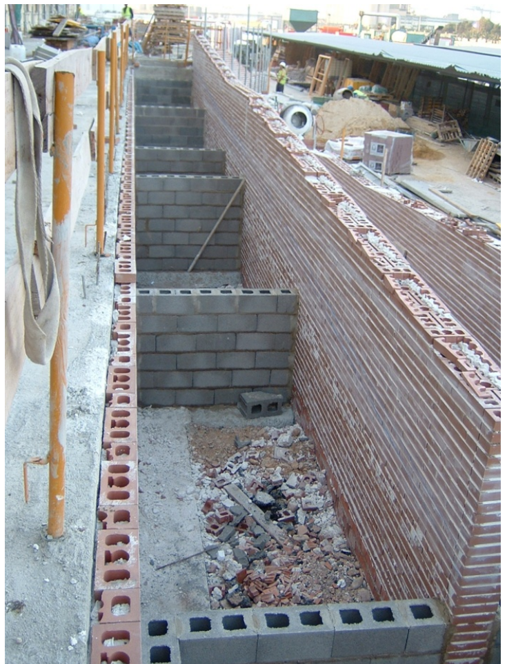
120.- Ejecución de muros de bloque de hormigón para el apoyo del forjado que formará la rampa.
