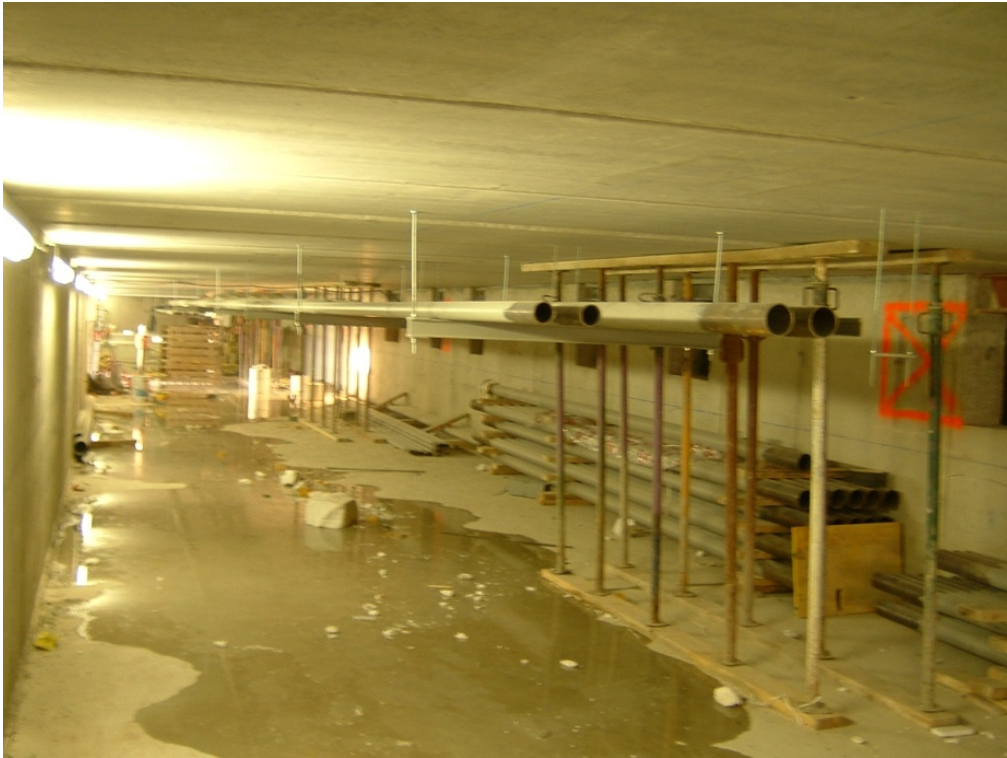
89.- Instalación de tubería para la alimentación de los climatizadores a instalar bajo la plataforma de acceso al edificio.
