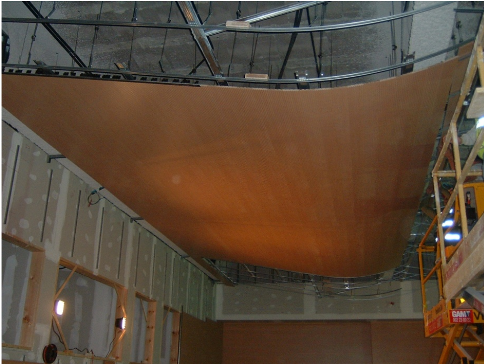
127.- Ejecución del falso techo de paneles de madera del salón de actos.
