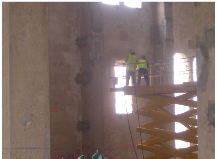
1.- Cegado de los huecos necesarios con fábrica de pie y medio de ladrillo perforado.
