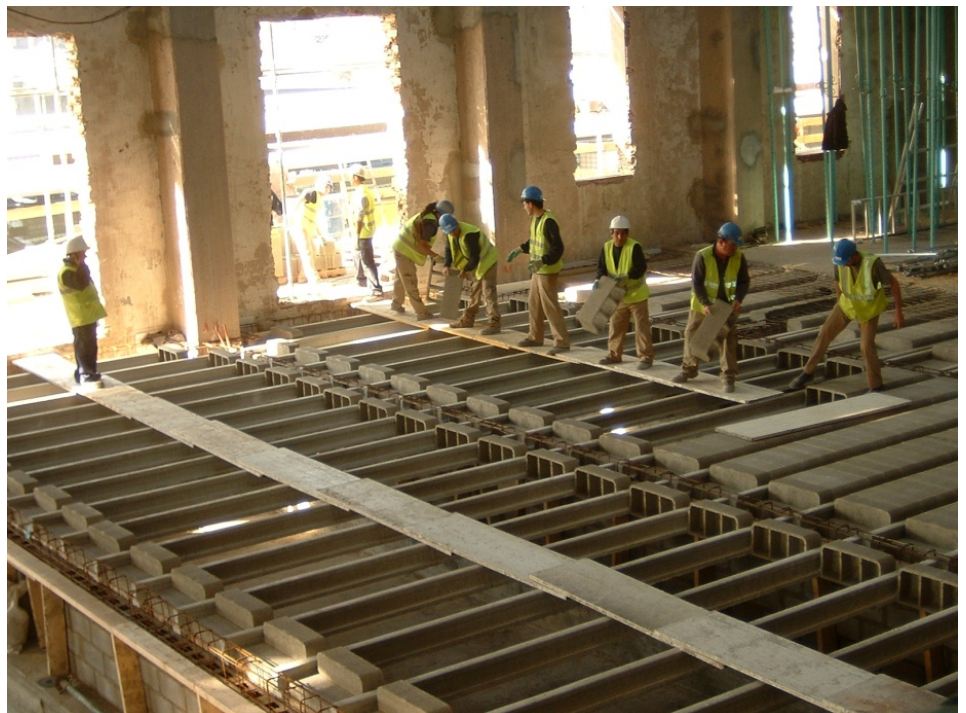
50.- Colocación de bovedillas de hormigón en el forjado sanitario suministradas desde el exterior del edificio.
