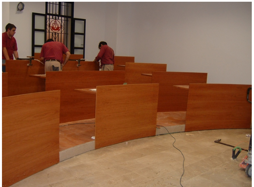
185.- Revestido y acabado de las gradas.
