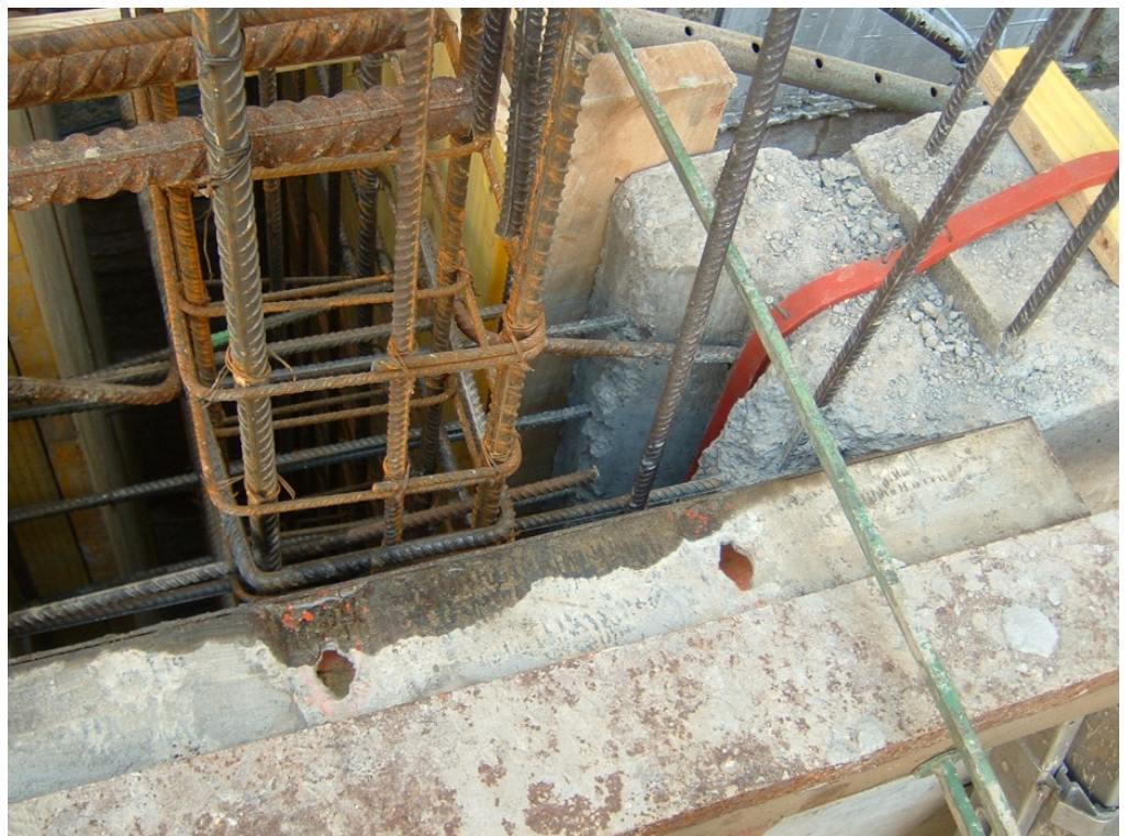
92.- Detalle de la junta de hormigonado entre dos tramos consecutivos del muro de sótano.
