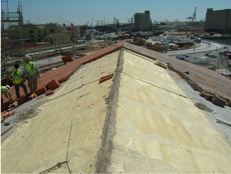
100.- Colocación de teja nueva y teja recuperada en dos faldones simultáneamente.
