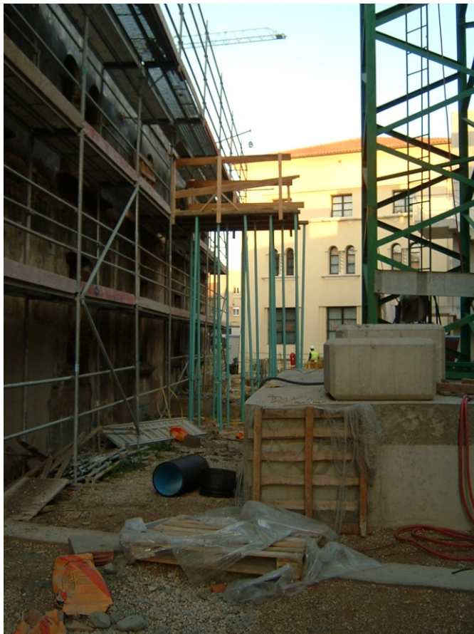
44.- Plataforma de descarga de material en la entreplanta.
