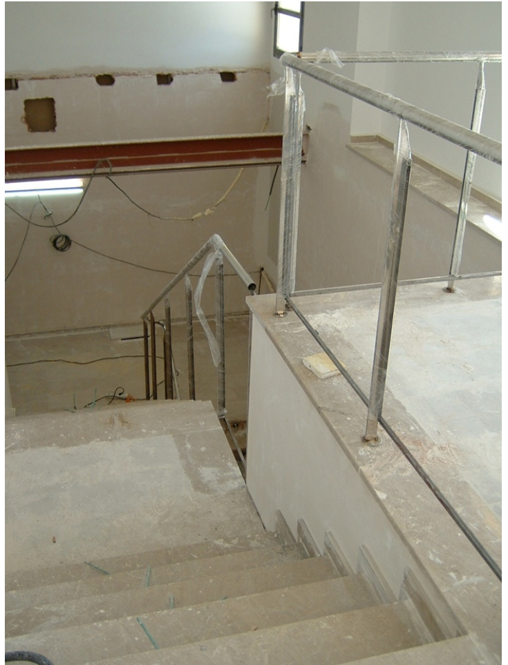
169.- Colocación de barandillas de acero inoxidable en las escaleras.
