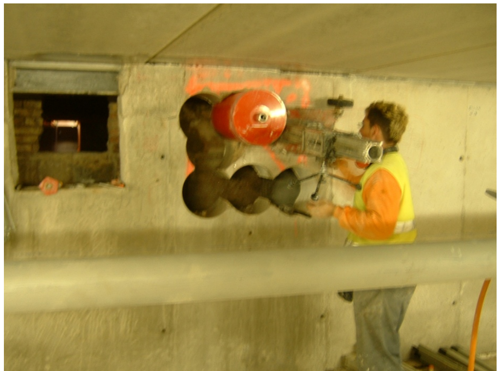
90.- Apertura de hueco para el paso de instalaciones en el muro de hormigón armado.
