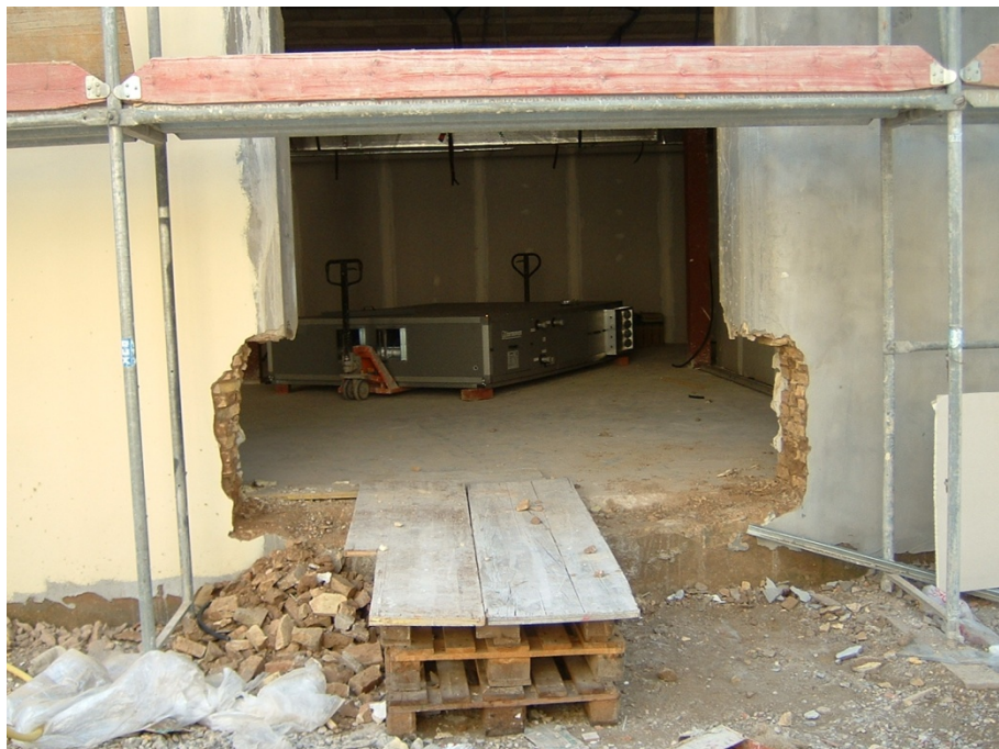
Figura 5.27 – Apertura de hueco para el paso de la máquina de climatización de cafetería.
