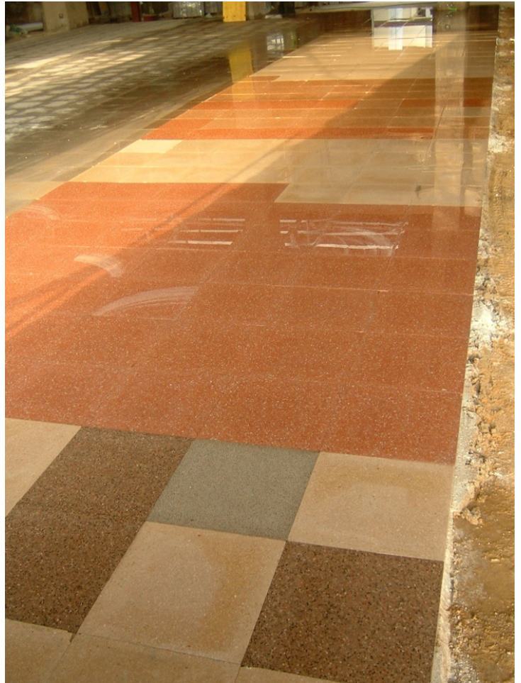
77.- Colocación de terrazo en el salón de actos como soporte al enmoquetado.
