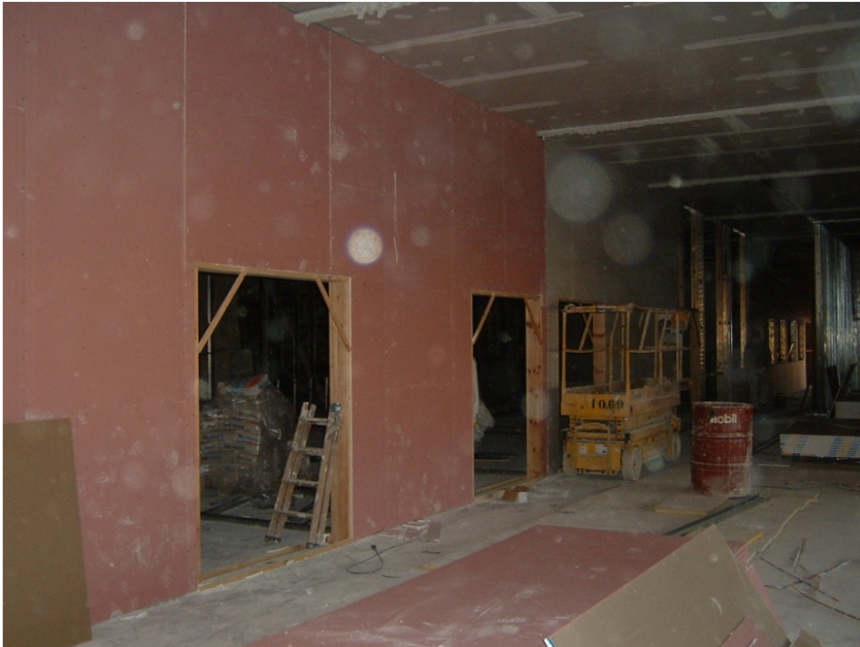
121.- Ejecución de tabiquería con placas de cartón yeso resistentes al fuego en los locales de riesgo especial.
