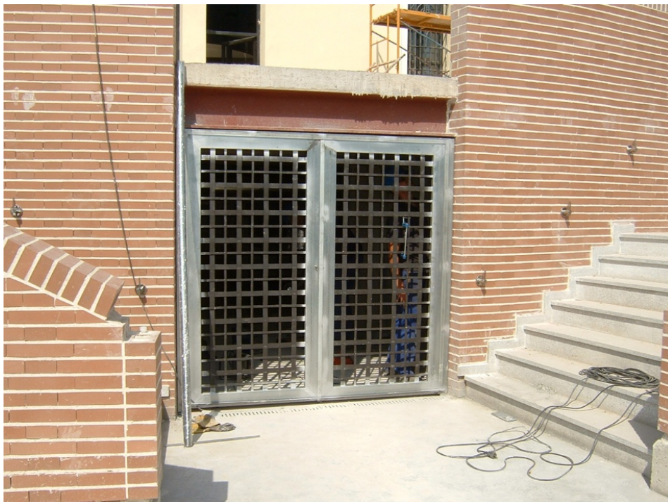
170.- Colocación de puertas metálicas para el acceso a la sala de máquinas bajo la plataforma de acceso al edificio.
