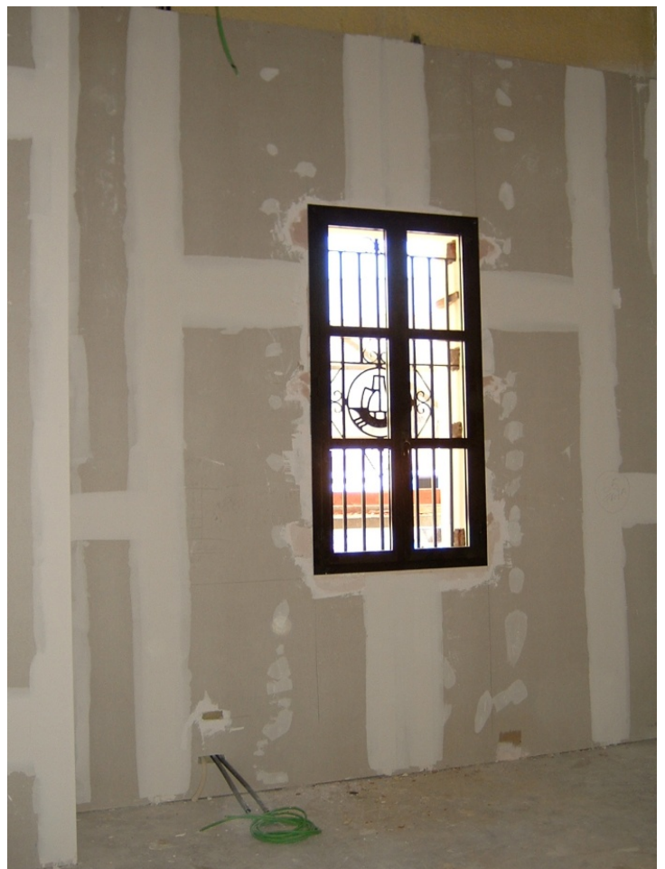
134.- Colocación de la carpintería metálica en los huecos de las ventanas.
