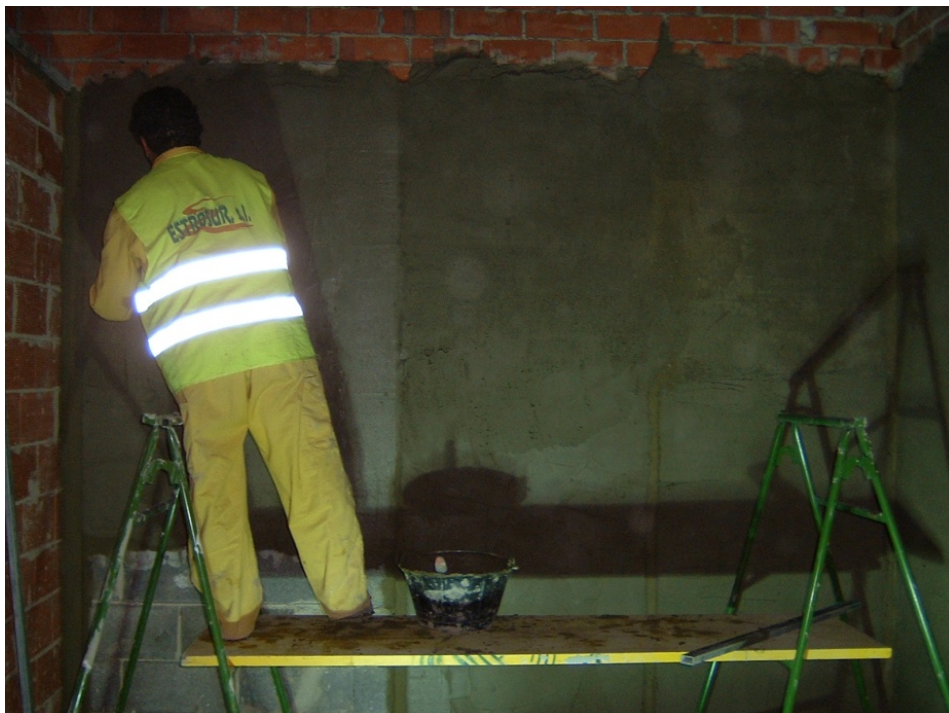
108.- Ejecución de enfoscado maestreado en los cuartos húmedos para soporte del alicatado.
