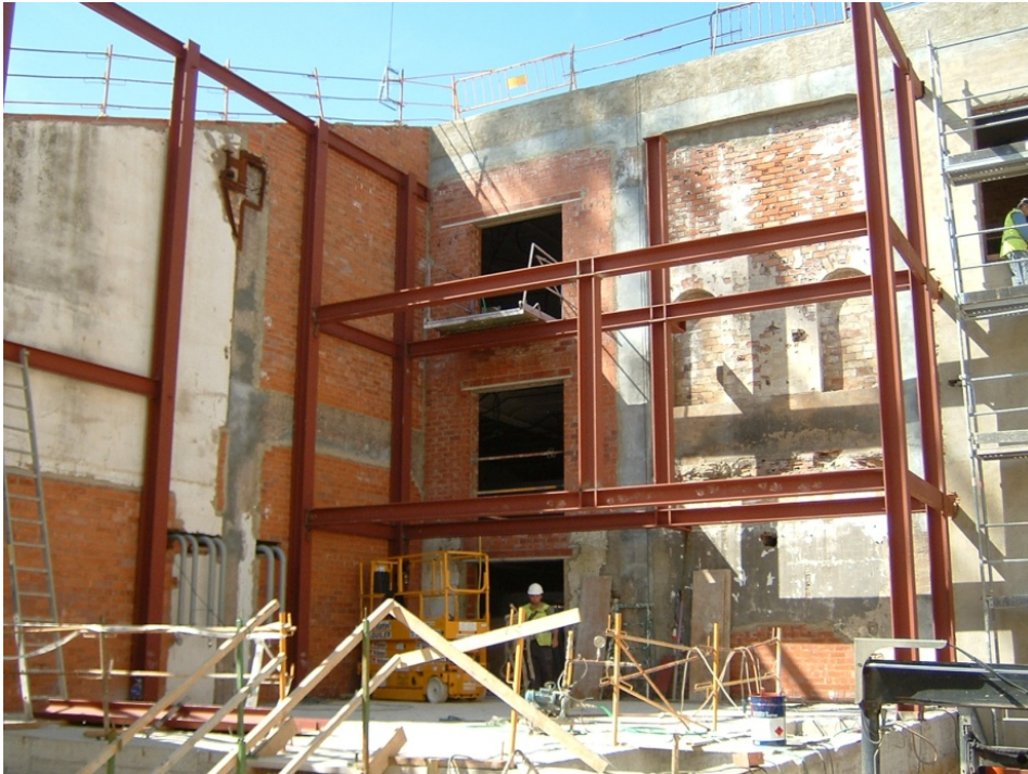
133.- Ejecución de la estructura metálica de la escalera exterior de la fachada este.
