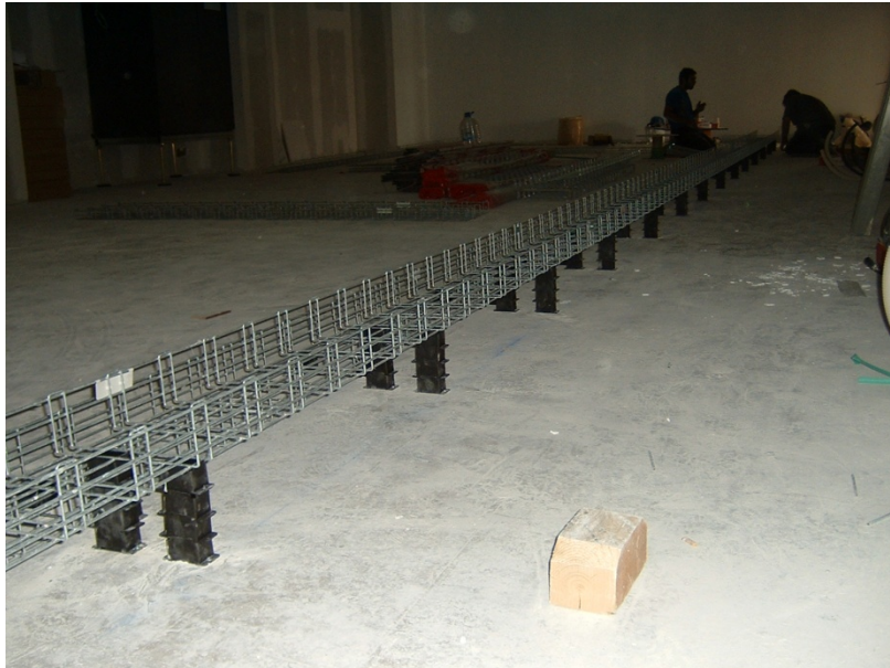
171.- Instalación de bandeja de rejilla de acero para el paso de las instalaciones eléctricas del Centro de Proceso de Datos.
