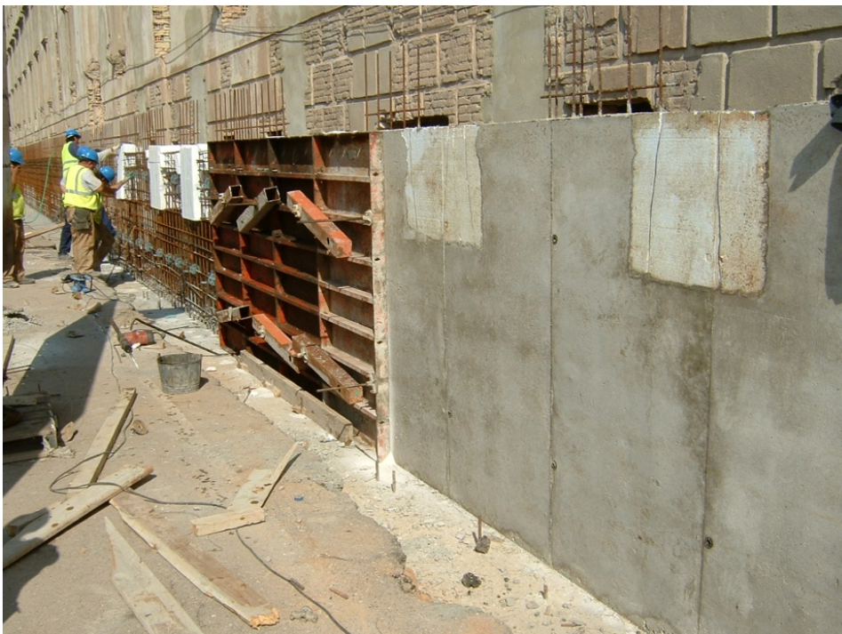
14.- Previsión de huecos en el muro para el paso de instalaciones.
