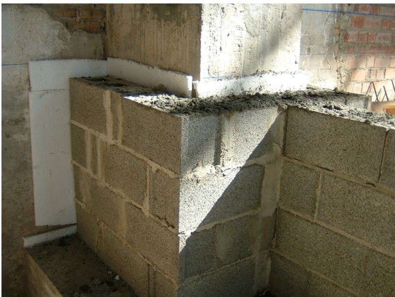
16.- Ejecución de muros de bloque de hormigón para el apoyo del forjado sanitario.
