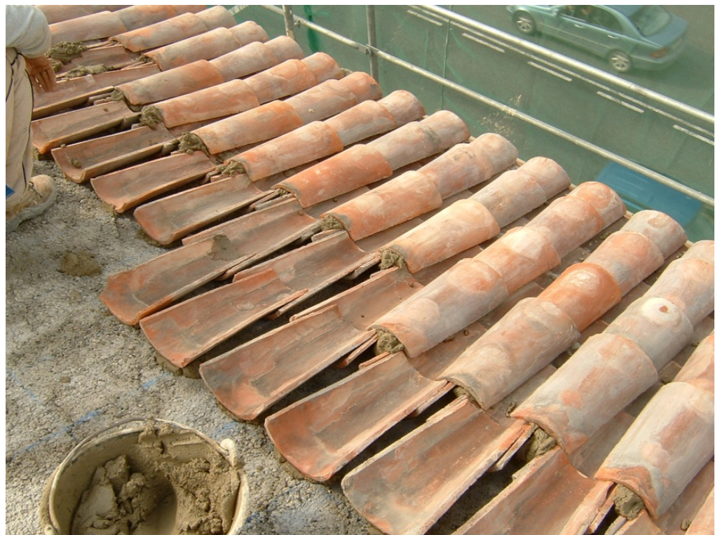
76.- Colocación de la teja curva árabe recuperada empleando motero de cemento.
