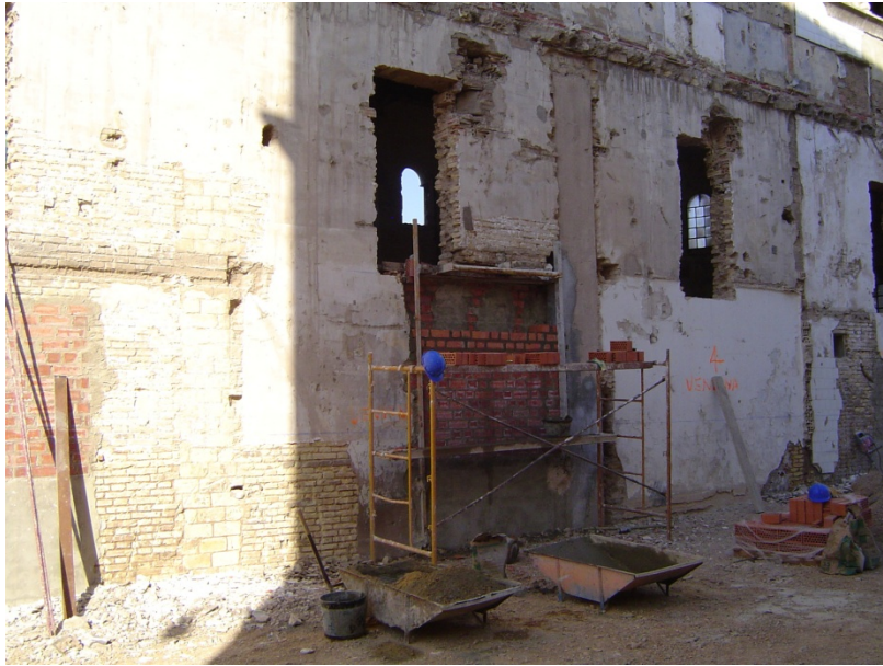
1.- Cegado de los huecos necesarios con fábrica de pie y medio de ladrillo perforado.
