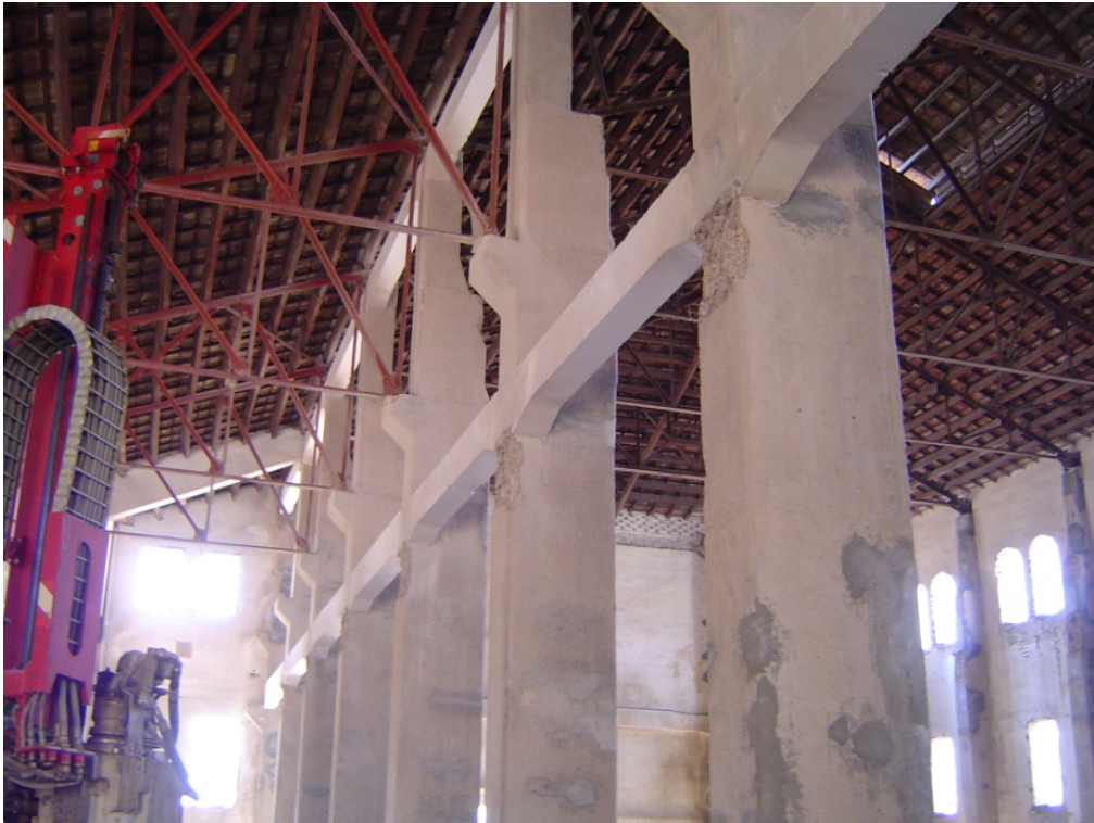
4.- Eliminación de las ménsulas de los pilares de hormigón que sustentaban las estructuras de los puentes grúa.
