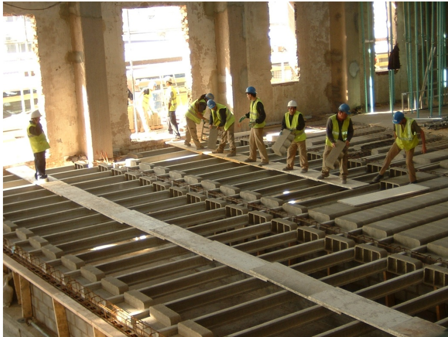
Figura 5.16 – Colocación de bovedillas en planta baja.
