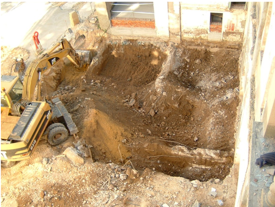
36.- Excavación del sótano, donde se encuentra la cimentación de una antigua edificación anexa al edificio.
