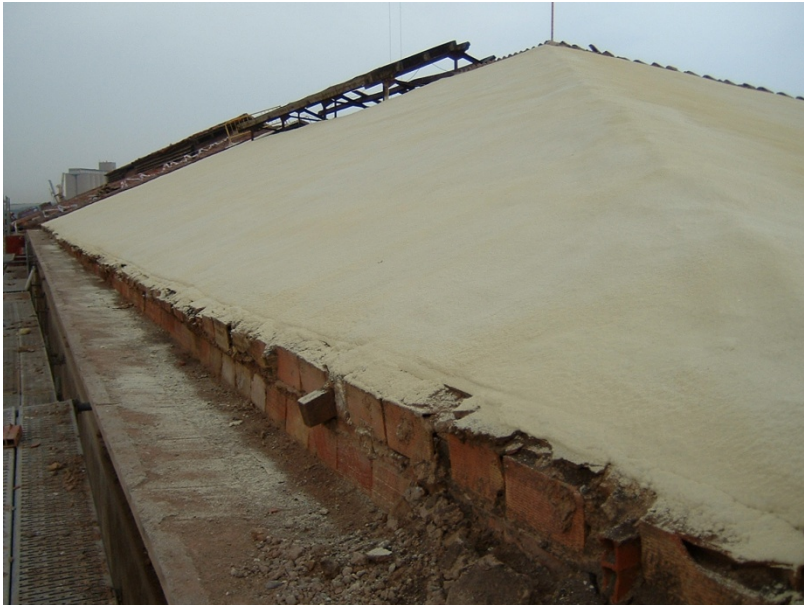
18.- Impermeabilización y aislamiento de la cubierta mediante poliuretano proyectado.
