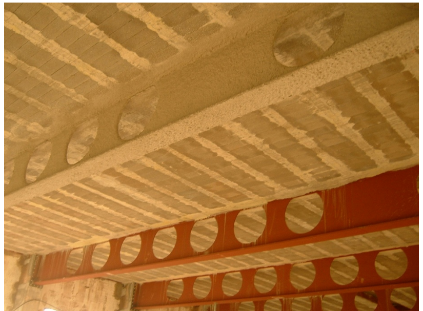
73.- Proyectado de vermiculita en la estructura metálica.
