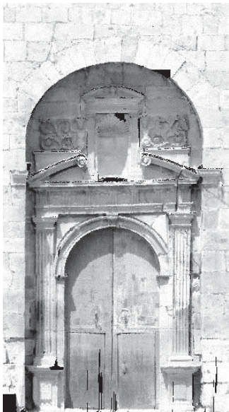
Fig. 6: Imagen de la portada pequeña del templo de Vistabella extraída de una nube de puntos captados por el scanner 3D. Fuente: J.T. Garfella
