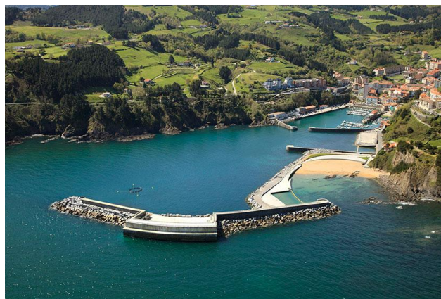
Figura 1: Imagen aérea de la planta de generación undimotriz NEREIDA MOWC construida a la entrada del puerto de Mutriku.
