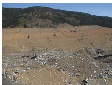
Imagen 2.8. Celdas de residuos con cubierta diaria [1]
