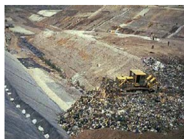
Imagen 2.9. Vertido, distribución y compactación de residuos. [2]
