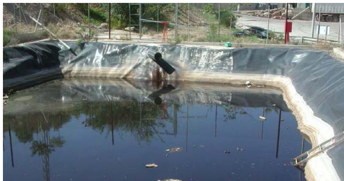
Imagen 3.3. Balsa de lixiviados, impermeabilización con geomembrana [8]
