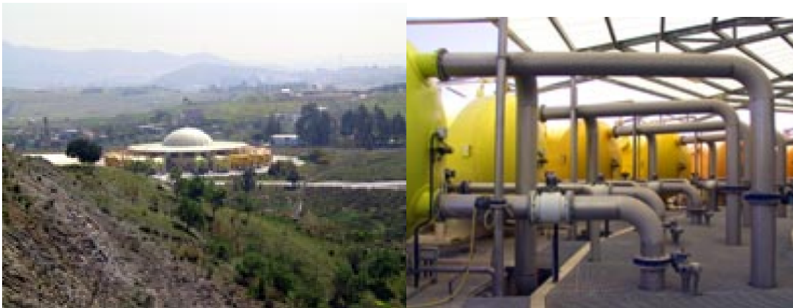
Figura. 13 Estación de Tratamiento de Agua Potable Pilonos en Málaga
