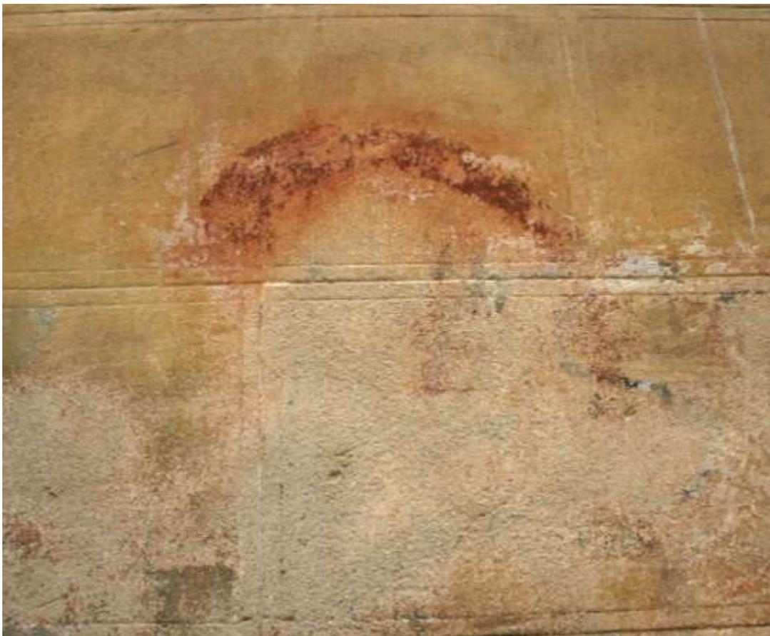
**FIGURA 7.** Erosión del soporte pétreo provocado por una limpieza agresiva en la fachada de la Iglesia de San Lorenzo (Valencia). Foto: Abraham Reina de la Torre
