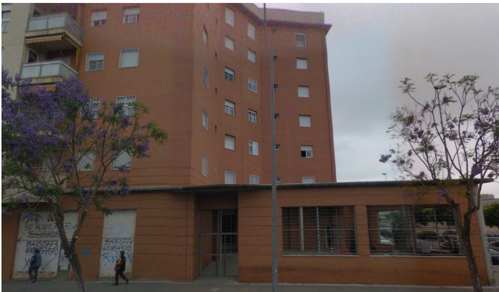
FIGURA A4-2. EDIFICIO MONITORIZADO EN EL ESTUDIO
