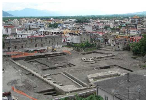
Fig. 7. Il baluardo "Vespasiano Gonzaga", il cantiere archeologico 20/05/2010 (Nicola Castaldo).
