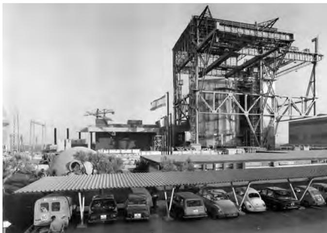
(figura 2.) edificio principal en construcción, carcasa del reactor
