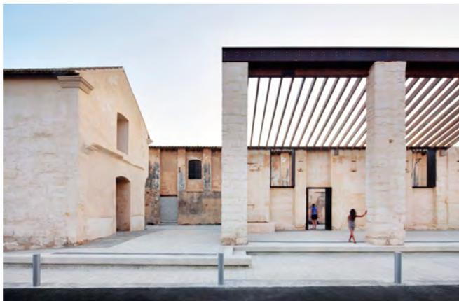
Figura 9. Consolidación del pabellón de vapor, el lienzo murario y la pérgola de acceso de las naves afectadas por el trazado del nuevo vial de la calle Brotad.
