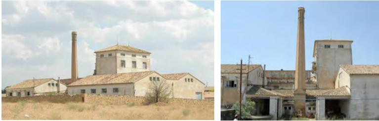
Figura 4: Imágenes del conjunto industrial donde se aprecia el estado actual del edificio principal con las naves que albergan los hornos, la torre de refrigeración, la chimenea, y los claustros adosados a los testeros de las naves principales.
